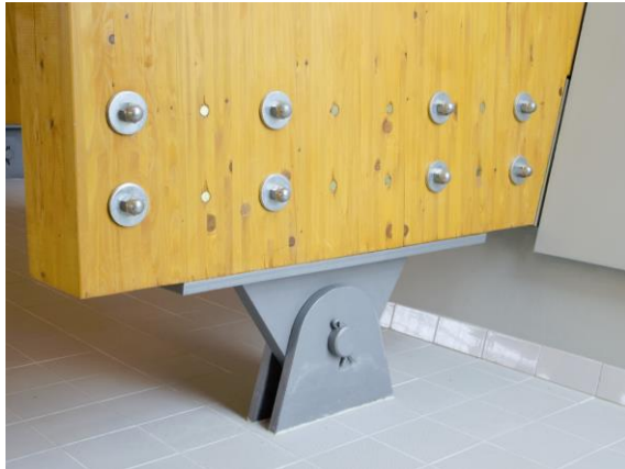
Obr. 3.1: Čepový dvojitřizňý spoj – Bazénová hala v Brně – Kohoutovicích (autor)
