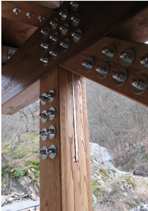
Obr. 2.9: Příklad přípoje prutu – přenos normálové a posouvající síly (autor)
