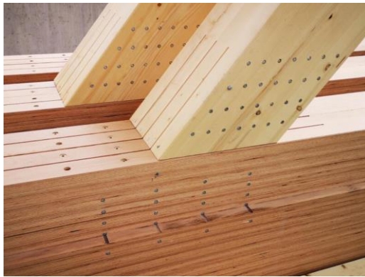
Obr. 2.1: Kolíkový spoj systému BSB – detail styčníku ( www.blumer-bsb.ch )
