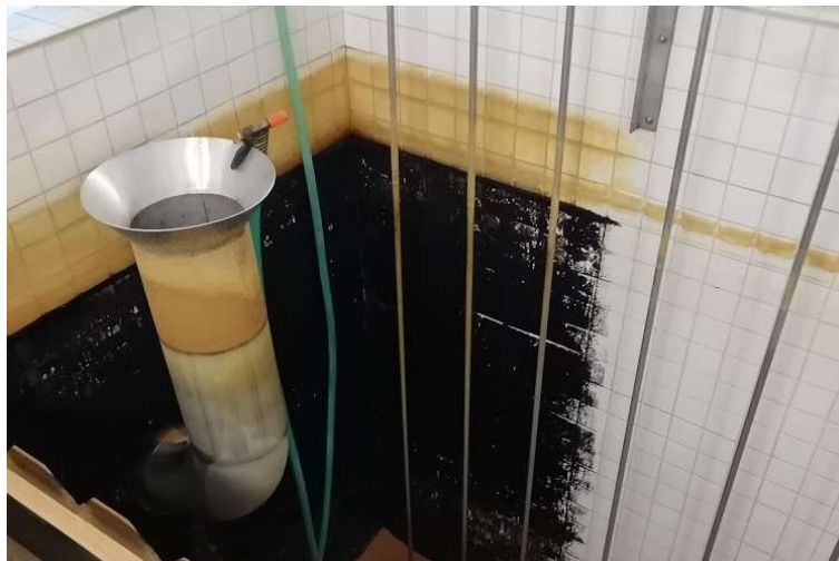
Obr. 20 Čištění filtrační nádrže
