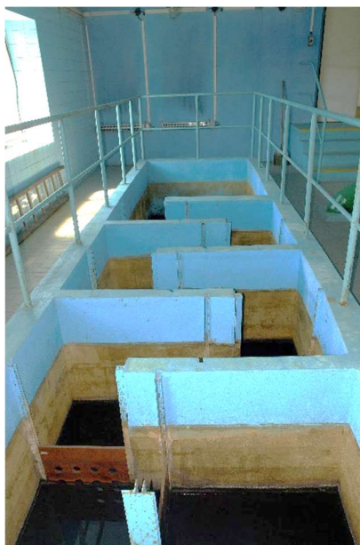
Obr. 27 Nevhodné provedení procesu rychlého míchání
