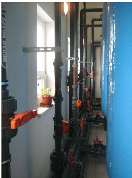
Obr. 28 Měření průtoku rotametry
