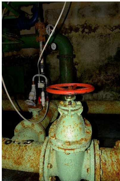
Obr. 24 Stav potrubních rozvodů
