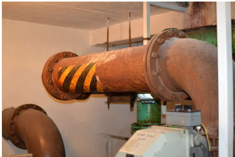
Obr. 31 Stav stropních konstrukcí – k faktoru ST1.1
