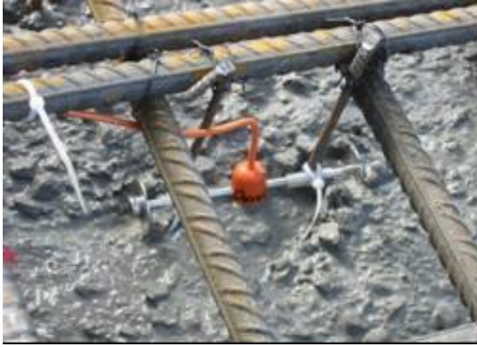
Obr. 21 Strunový tenzometr – betonáž základové desky.
