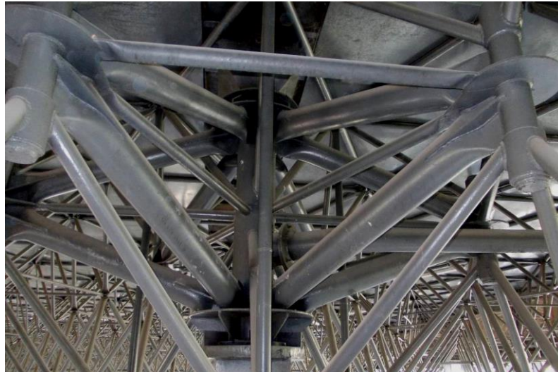
Obr. 57 Objekt pavilonu "D" - detail hlavice nad sloupem s patrným pravidelným rastrem segmentů střešní konstrukce v pozadí.
