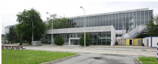
Obr. 53 Objekt pavilonu "D" v areálu BVV - původní stav.
