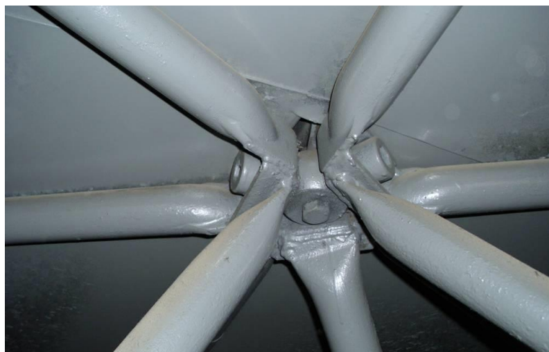
Obr. 56 Objekt pavilonu "D" - detail styku jehlanů, jsou patrná rohová tělesa a spojovací soudek.
