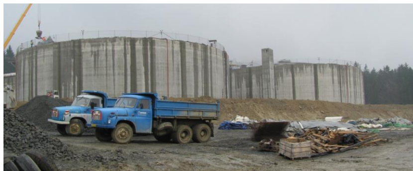
Obr. 16 Pohled na rozestavěné nádrže.
