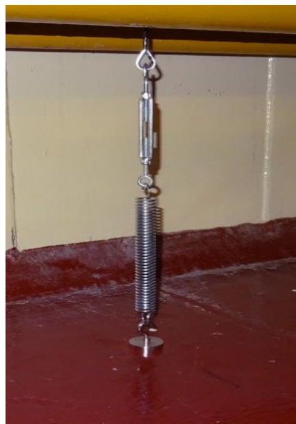
Obr. 126 Reálné přikotvení v plynojemu.
