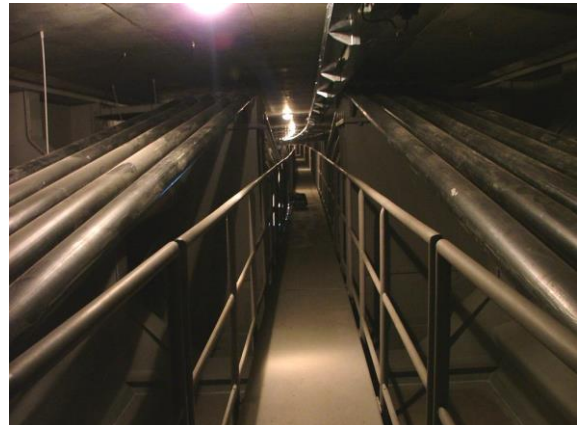
Obr. 39 Pohled do komory mostu s vedením podélných kabelů.
