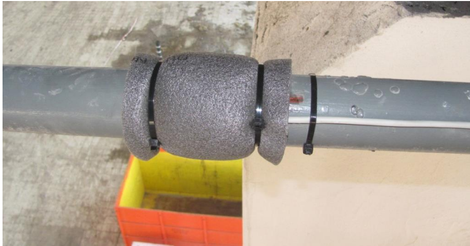
Obr. 74 Finální úprava měřicího místa příhradového prutu s ochranou proti mechanickému poškození.
