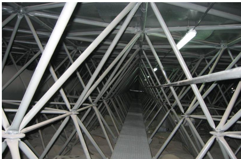
Obr. 54 Objekt pavilonu "D" - pohled v rovině původní konstrukce zastřešení.
