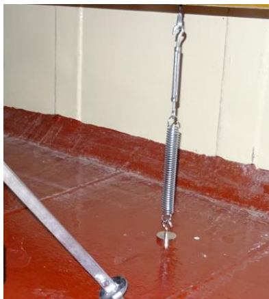
Obr. 144 Předepnutí a uchycení svislého lanka 3.
