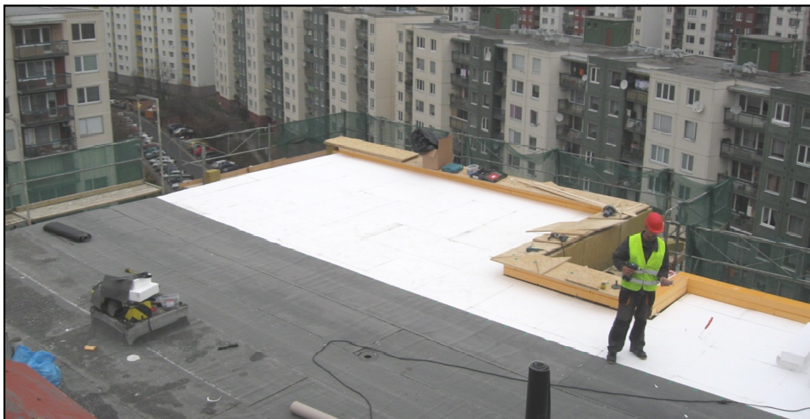
Obrázek 17: Provádění doplňkové tepelné izolace, hydroizolačního souvrství a nové atiky (archív autora)
