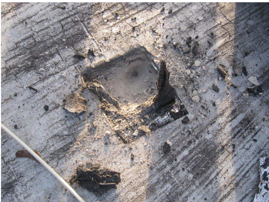
Obrázek 24: Sonda střešního souvrství (zdroj: archív autora)
