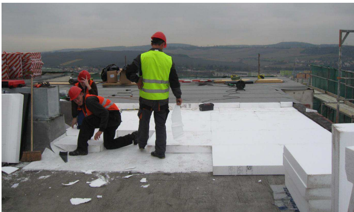
Obrázek 25: Pokládka doplňkové tepelné izolace a hydroizolačního souvrství na stávající skladbu (zdroj: archív autora)
