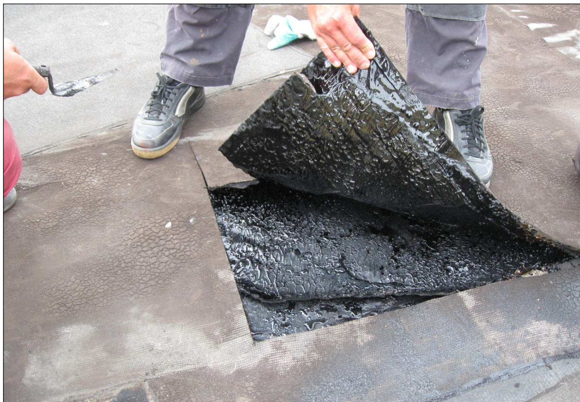
Obrázek 5: Zjevná kondenzace v hydroizolačním souvrství pod hlavní hydroizolací z asfaltových pásů (zdroj : archiv autora)
