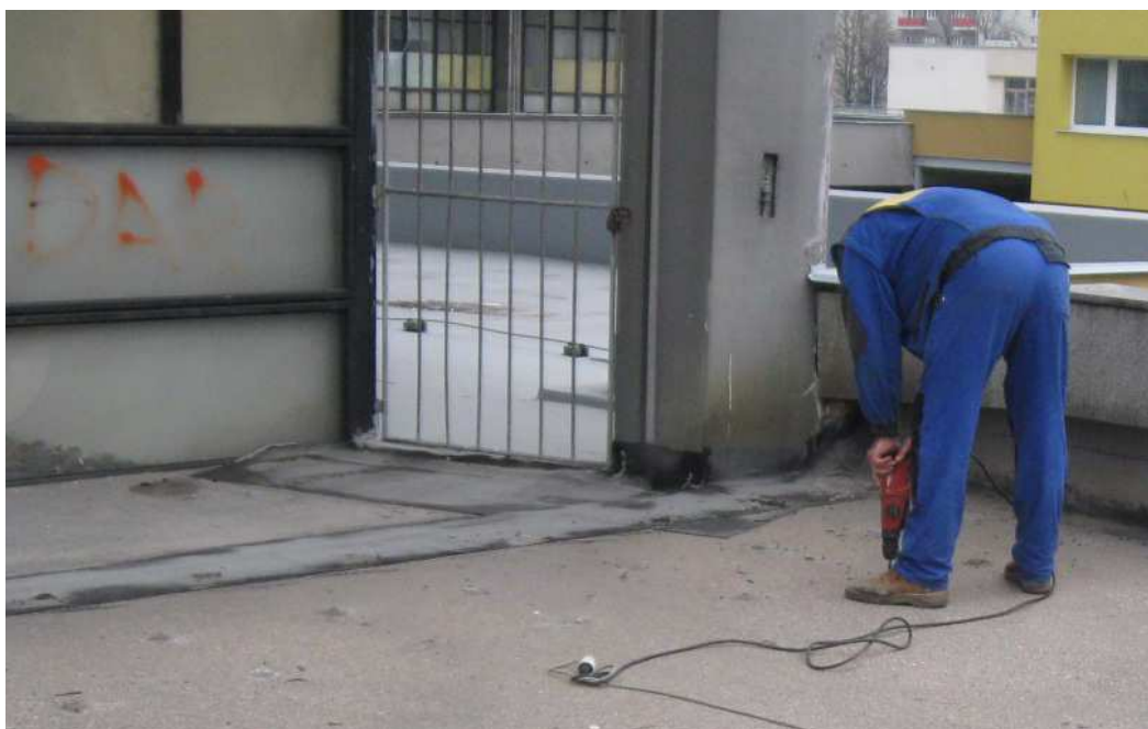
Obrázek 12: Provádění bodové perforace stávajícího střešního souvrství (zdroj: archív autora)
