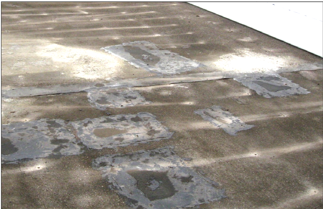
Obrázek 4: Bodová perforace – upraven jas a kontrast fotografie pro lepší zřetelnost perforace (zdroj: archiv autora)
