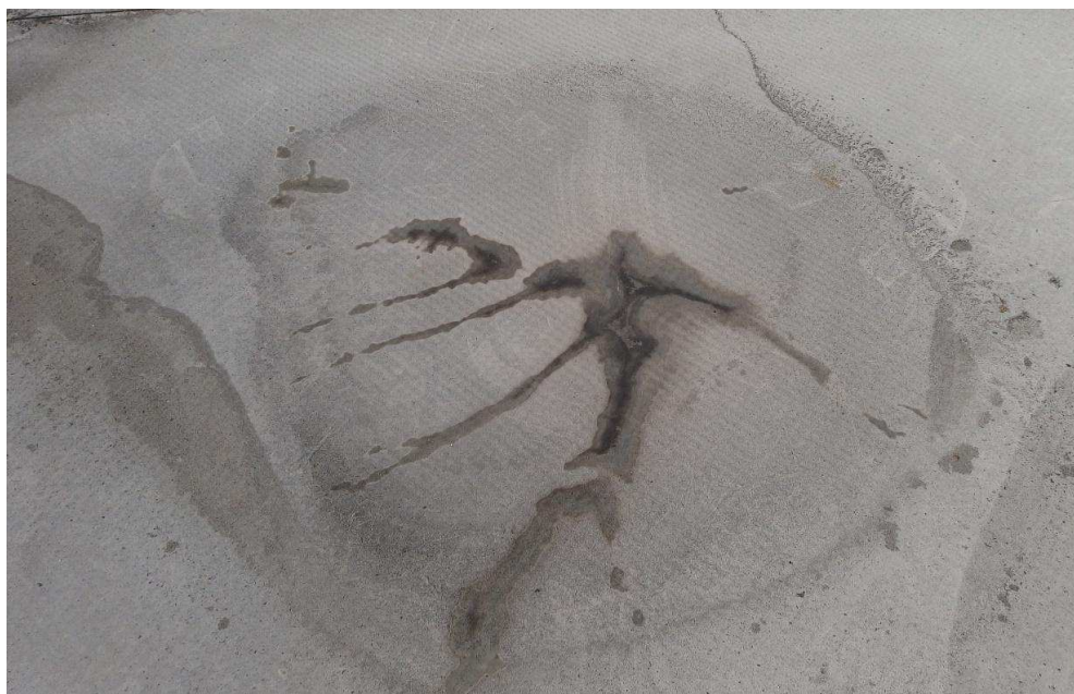
Obrázek 2: Ukázka narušené povlakové krytiny z fólie (zdroj: archív autora)
