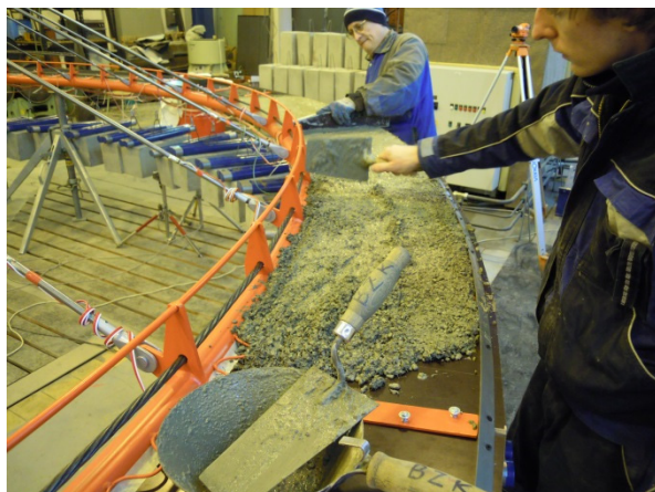
Obr. 7.111 Betonáž mostovky modelu v zavěšené části - vláknobeton
