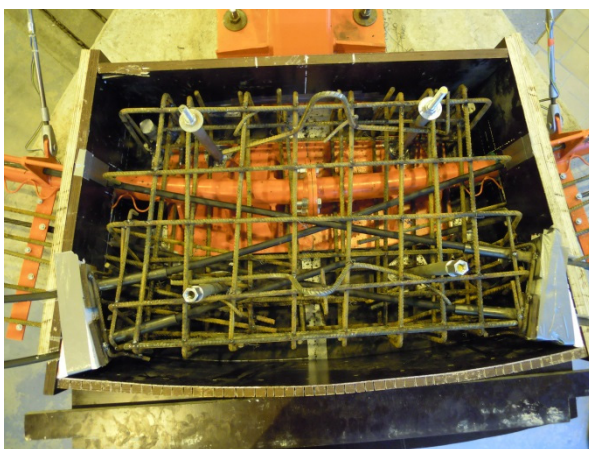
Obr. 7.107 Bednění a vyztužení kotevních bloků, příprava na betonáž
