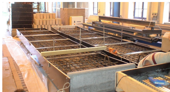
Obr. 8.37 Bednění a armatura před betonáží spřažené desky mostovky
