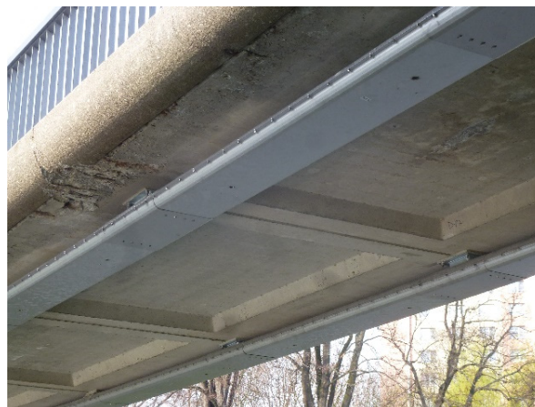
Obr. 9.22 Pohled, externí předpětí
