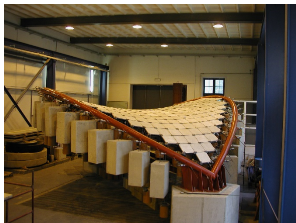
Obr. 7.37 Ukládání prefa prvků
