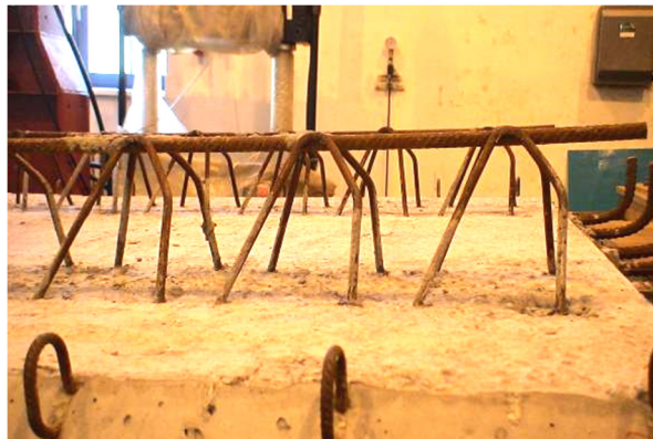
Obr. 8.31 Vybočení diagonál výztuže
