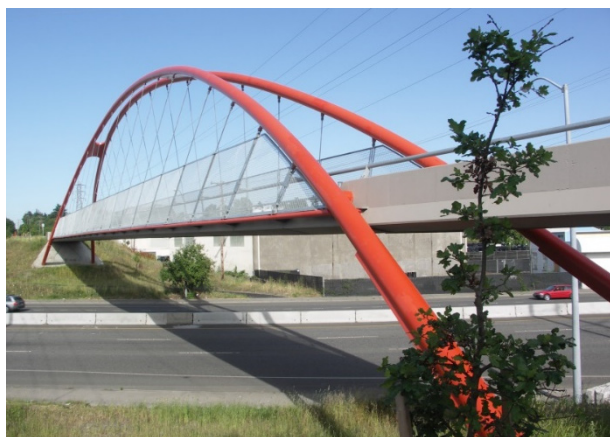
Obr. 10.26 Lávka pro pěší MCLOUGHLIN OVERCROSSING - realita
