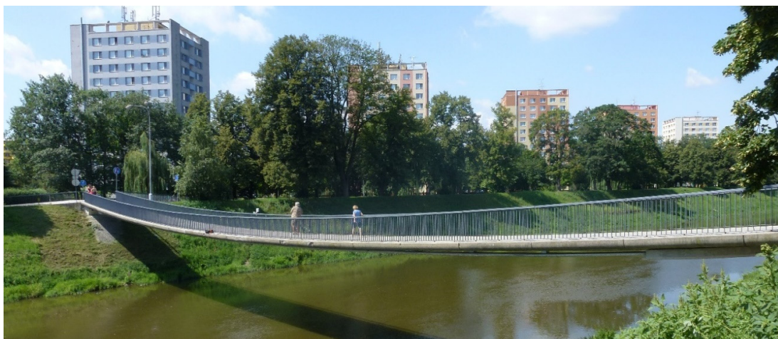
Obr. 8.43 Konstrukce tvořená předpjatým pásem v Kroměříži
