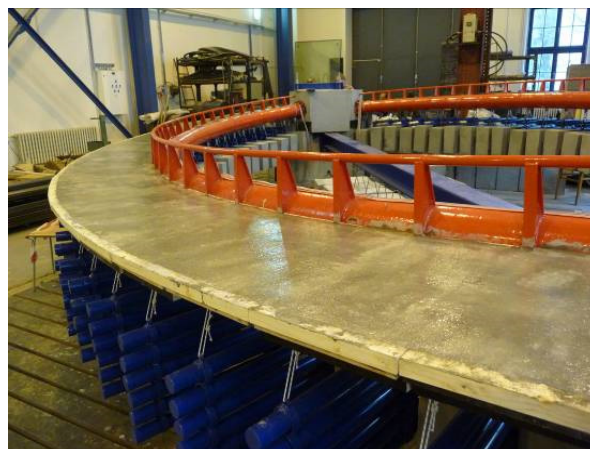
Obr. 7.76 Betonáž desky mostovky
