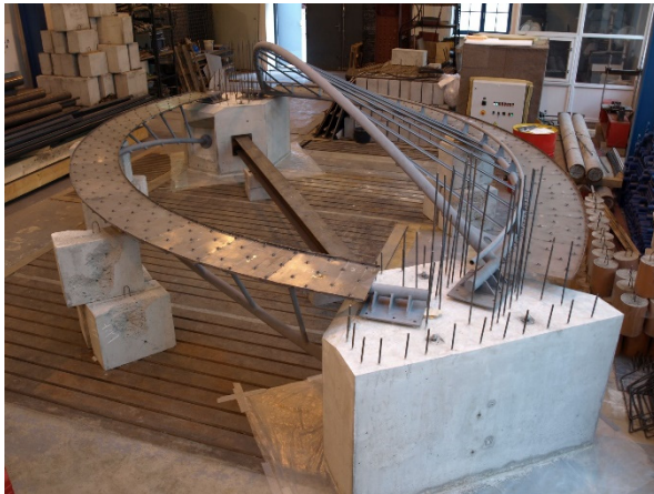
Obr. 7.145 Osazení ocelových konstrukcí
