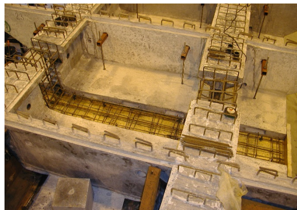
Obr. 7.12 Dobetonávka mezi segmenty vahadla a pole
