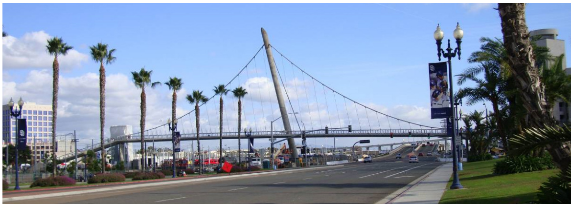
Obr. 9.33 Lávka přes Harbor Drive v San Diegu
