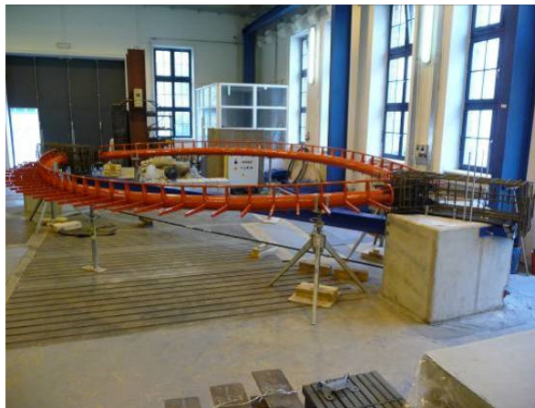
Obr. 7.73 Osazení ocelové konstrukce
