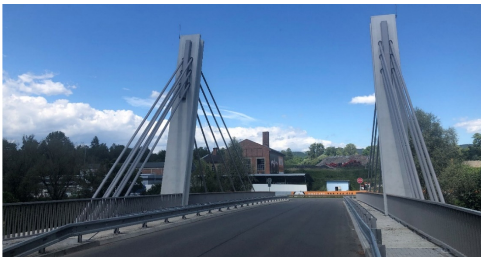
Obr. 9.45 Zavěšený most u obce Hrachovec
