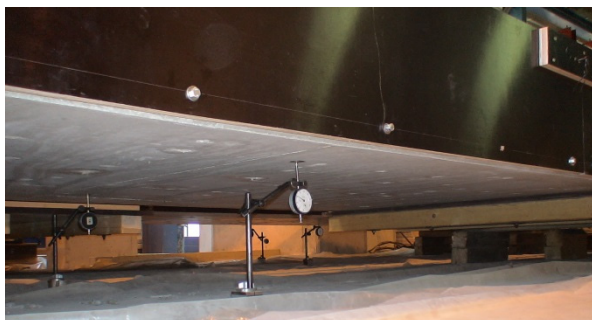
Obr. 8.36 Podepření a měření průhybů při betonáži spřažené desky
