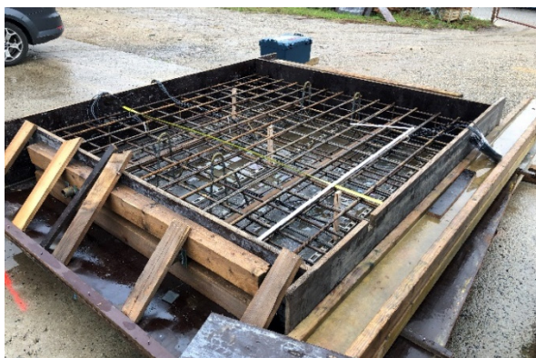
Obr. 8.44 Výroba zkušební vzorku, betonářská výztuž, uložené snímače
