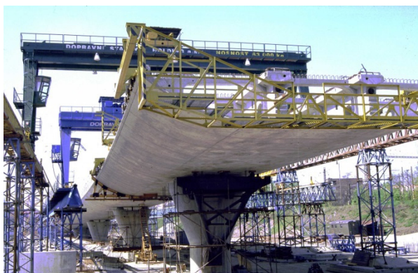
Obr. 7.3 Montáž mostu v Plzni v symetrickém vahadle
