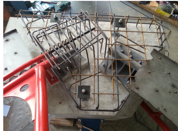
Obr. 7.146 Obetonování uložení mostovky
