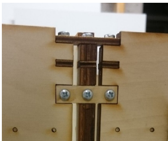
Obr. 10.18 Pevný spoj mezi panely
