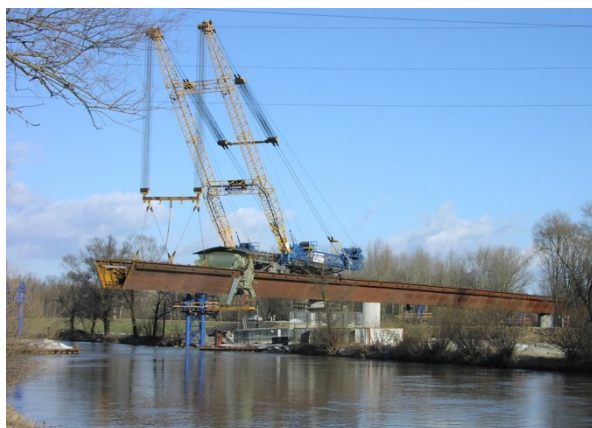
Obr. 8.1 Výstavba mostu přes Odru
