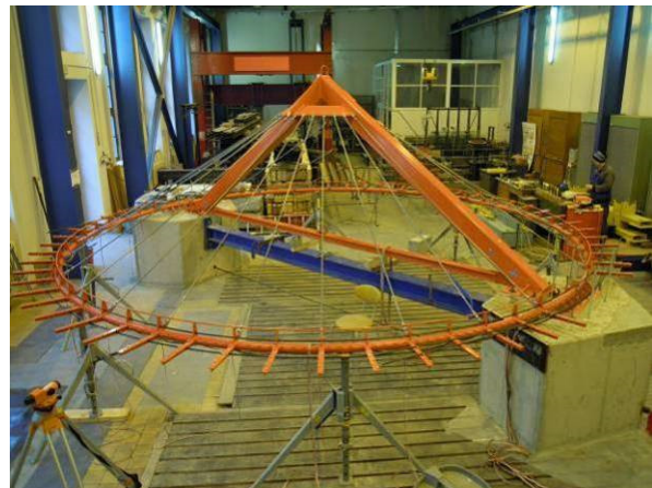
Obr. 7.106 Montáž ocelové konstrukce pylonu, osazení závěsů a visutého lana
