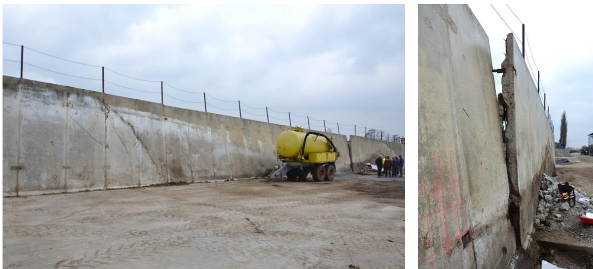
Obr. 67 Silážní žlab, jehož stěny jsou tvořeny železobetonovými prefabrikáty ve tvaru písmene L, se základnou překrytou deskou z drátkobetonu. Zde porušená část jihozápadní stěny silážního žlabu v délce 30 m. Vpravo za cisternou je patrný výrazný zlom stěny. Vpravo detail jedné z poruch mezi prefabrikáty č. 21 a 22 při pohledu z vnitřní strany
