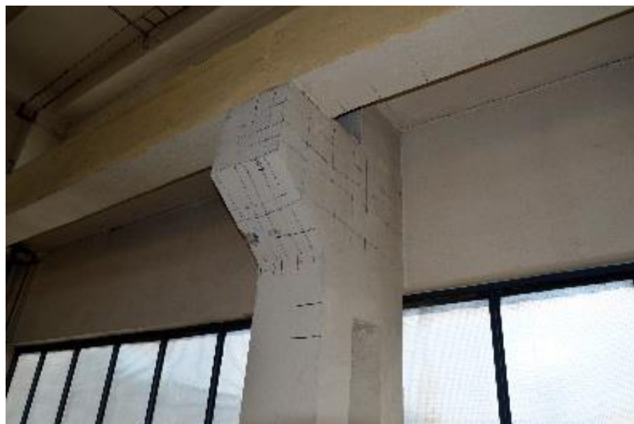
Obr. 152 Liniové měření elektromagnetickým indikátorem na spodním líci nosníku, v blízkosti sloupu S1. V místě provedení sondy N1-1 byly identifikovány třmínky s průměrnou roztečí 260 mm. Pro další využití byla poloha výztuží současně kreslena na povrch konstrukce [72]
