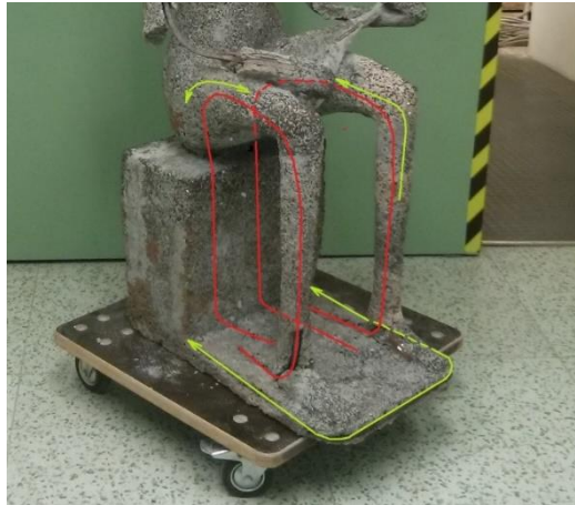
Obr. 181 Předpokládaný průběh výztuže v nohách plastiky. Červená – čtverhranný průřez 10 \times 10 mm, zelená – kruhový průřez \varnothing 6 mm
