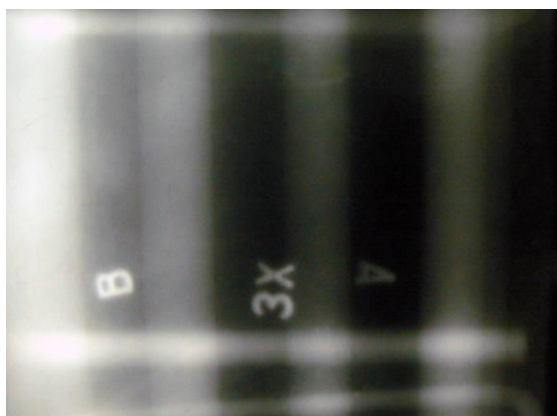
Obr. 16 Jeden z radiogramů, patrné 4 z hlavních výztuží, dobře jsou viditelné olověné značky [7]
