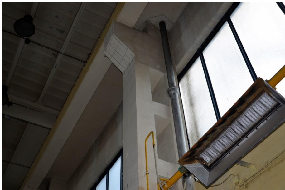
Obr. 149 Liniové měření elektromagnetickým indikátorem napříč konzolou sloupu S2, v místě provedení sondy K2-1b. S využitím kalibrace přístroje Profometer PM630 bylo zaměřeno celkem 8 profilů svislé výztuže o průměru 20, 18 a 8 mm. Pro další využití byla poloha výztuží současně kreslena na povrch konstrukce [72]
