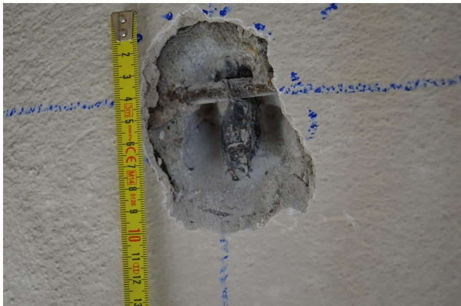
Obr. 155 Sekaná sonda k výztuži SV4, provedená na boční straně konzoly sloupu S1. V místě provedení sondy byla identifikována výztuž 10 425 (V) o průměru 18 mm. Krytí výztuže 20 – 25 mm. Třmínek v místě sondy o průměru 8 mm, hladká výztuž 10 216 (E). Rozsah sekané sondy byl omezen na minimum [72]
