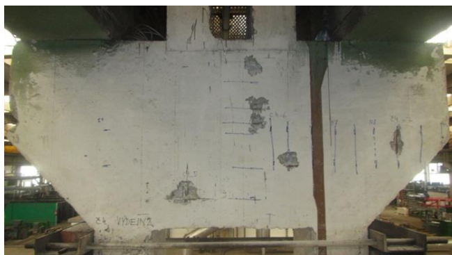
Obr. 21 Příklad cílené sekané sondy pro určení typu výztuže – sloup a konzoly jeřábové dráhy
