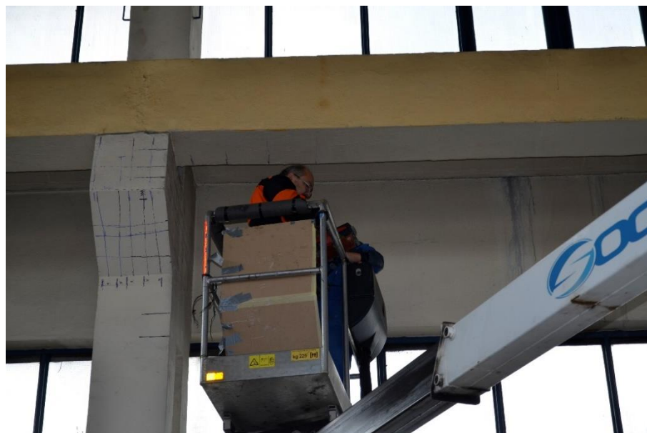
Obr. 151 Liniové měření elektromagnetickým indikátorem na spodním líci nosníku, v blízkosti sloupu S1.
