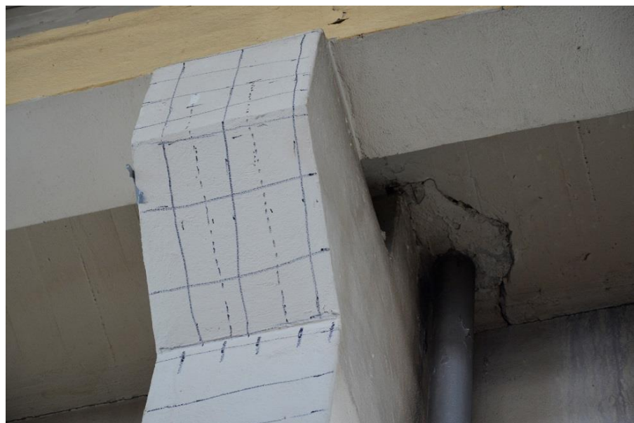
Obr. 150 Liniové měření elektromagnetickým indikátorem napříč šikmou částí konzoly sloupu S2, v místě provedení sondy K2-2. S využitím kalibrace přístroje Profometer PM630 bylo zaměřeno celkem 5 profilů svislé šikmé výztuže. Pro další využití byla poloha výztuží současně kreslena na povrch konstrukce [72]
