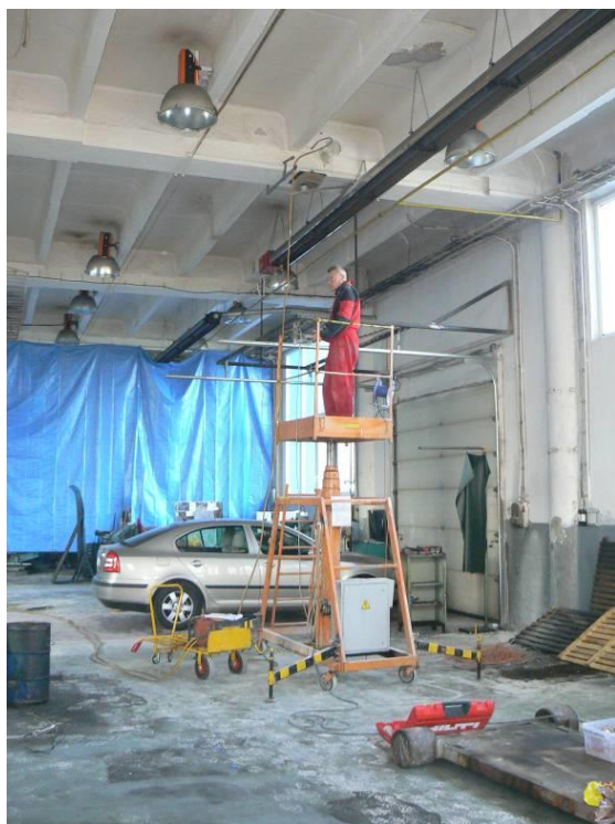
Obr. 14 Příprava prozařování železobetonového průvlastku uprostřed rozpětí [7]
