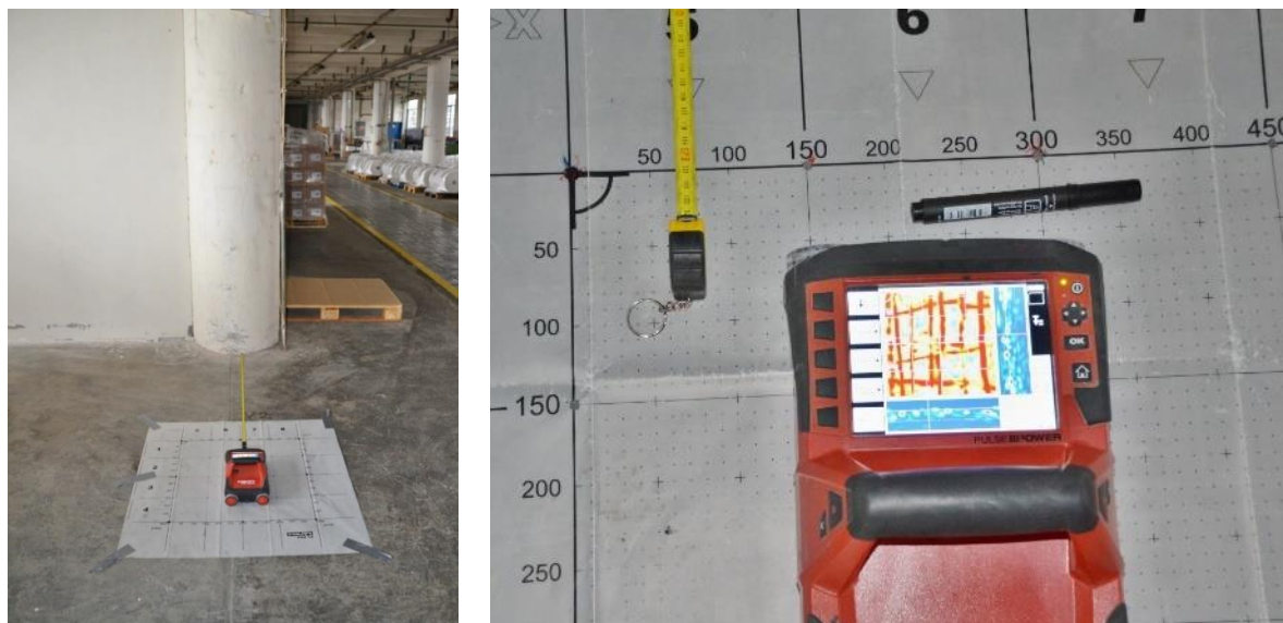
Obr. 86 Příprava místa provádění vývrtu v průmyslovém objektu, radarová sonda Hilti PS1000 X-SCAN umožňuje na displeji okamžitou vizualizaci plošného skenu a rozhodnutí pro místo vrtání
