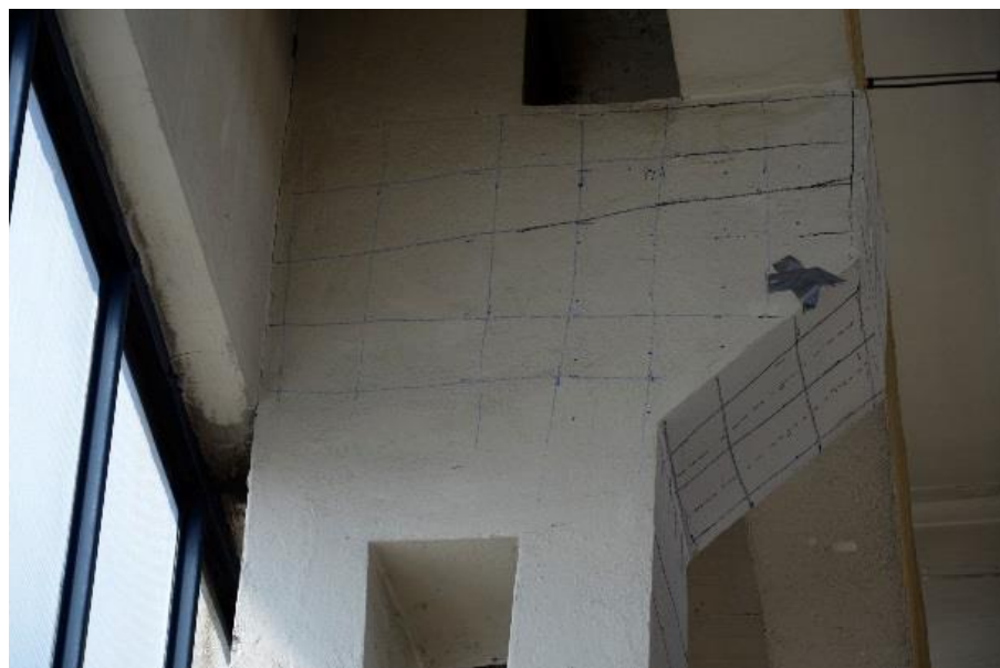
Obr. 148 Liniové měření elektromagnetickým indikátorem napříč konzolou sloupu S2, v místě provedení sondy K2-1a. S využitím kalibrace přístroje Profometer PM630 bylo zaměřeno celkem 6 profilů svislé výztuže o průměru 20, 18 a 8 mm. Pro další využití byla poloha výztuží současně kreslena na povrch konstrukce [72]
