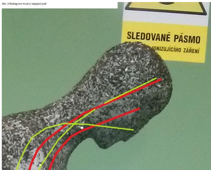
Obr. 188 Předpokládaný průběh výztuže v hlavě. Červená – čtverhranný průřez 10 \times 10 mm, zelená – kruhový průřez \varnothing 6 mm
