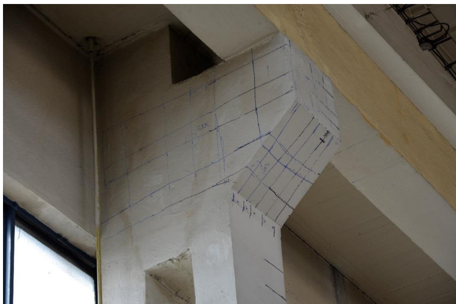
Obr. 142 Liniové měření elektromagnetickým indikátorem napříč šikmou částí konzoly sloupu S1, v místě provedení sondy K1-2. S využitím kalibrace přístroje Profometer PM630 bylo zaměřeno celkem 5 profilů svislé výztuže. Dva profily blízko povrchu byly ověřeny sekanými sondami SV5 a SV6, byl identifikován průměr výztuže 16 mm. Pro další využití byla poloha výztuží současně kreslena na povrch konstrukce [72]
