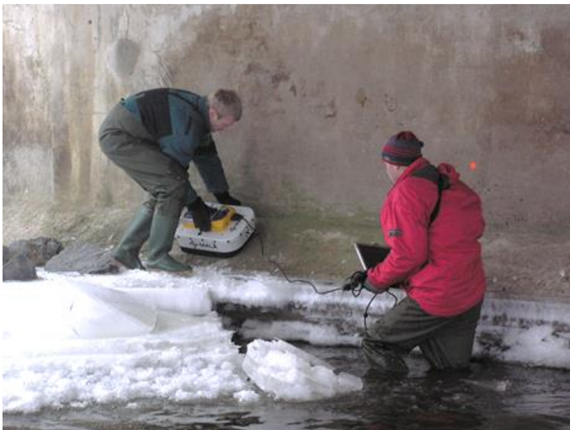
Obr. 27 Ukázka experimentálního měření na mostní podpěře anténním systémem 500 MHz [17]
