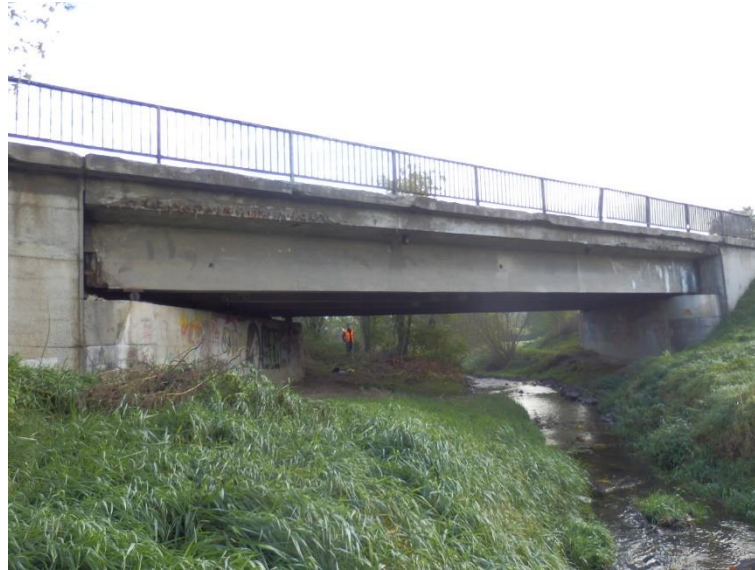
Obr. 93 Silniční most ev.č. 57-016 přes místní vodoteč u obce Holasovice u Opavy, stav k srpnu 2011
