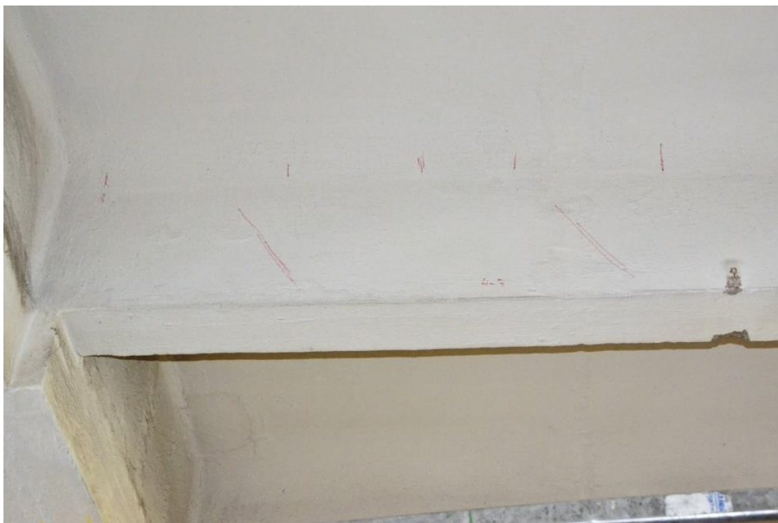
Obr. 83 Díky okamžité vizualizaci výsledků měření na displeji radarové sondy je možné například okamžitě zakreslení polohy ohybů na povrch prvku pro další činnosti [59]
