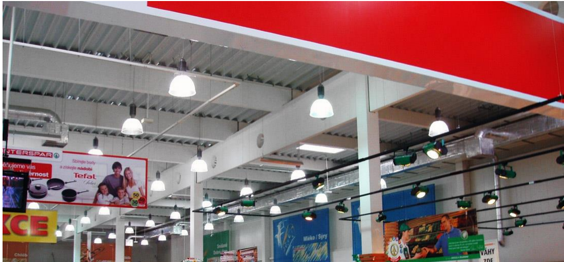
Obr. 159 Konstrukce nákupního centra s předmětnými vazníky
