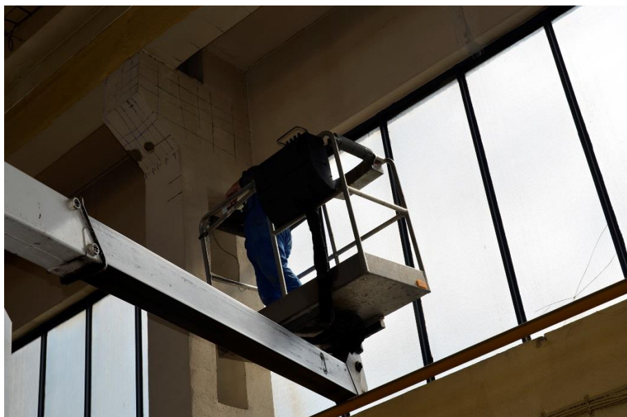
Obr. 136 Liniové měření elektromagnetickým indikátorem napříč sloupem S1 ve výšce 7000 mm od podlahy, v místě provedení sondy S1-2. S využitím kalibrace přístroje bylo zaměřeno celkem 5 profilů hlavní svíslé výztuže o průměru 20 mm. Vnější hrana sloupu. Pro další využití byla poloha výztuží současně kreslena na povrch konstrukce [72]
