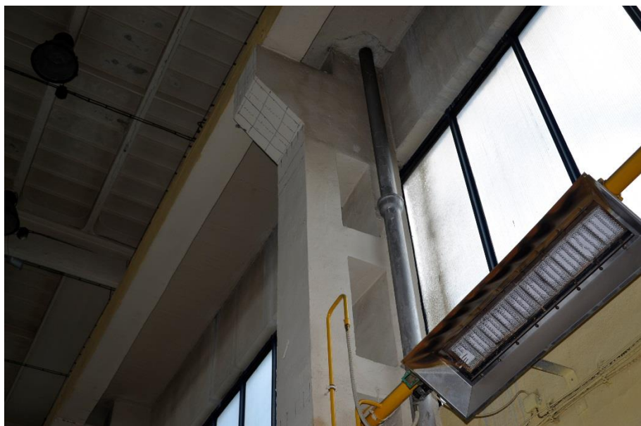
Obr. 145 Liniové měření elektromagnetickým indikátorem napříč sloupem S2 ve výšce 7000 mm od podlahy, v místě provedení sondy S2-2. S využitím kalibrace přístroje bylo zaměřeno celkem 5 profilů hlavní svíslé výztuže o průměru 20 mm. Vnější hrana sloupu. Pro další využití byla poloha výztuží současně kreslena na povrch konstrukce [72]
