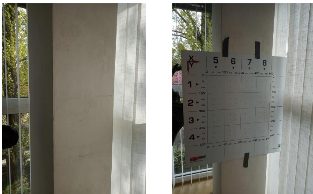
Obr. 46 Sloup obdélníkového průřezu s přístupnými dvěma stranami. Pro aplikaci plošného radarového skenu je vhodné použít pevnou podložku s natištěným skenovacím rastrem
