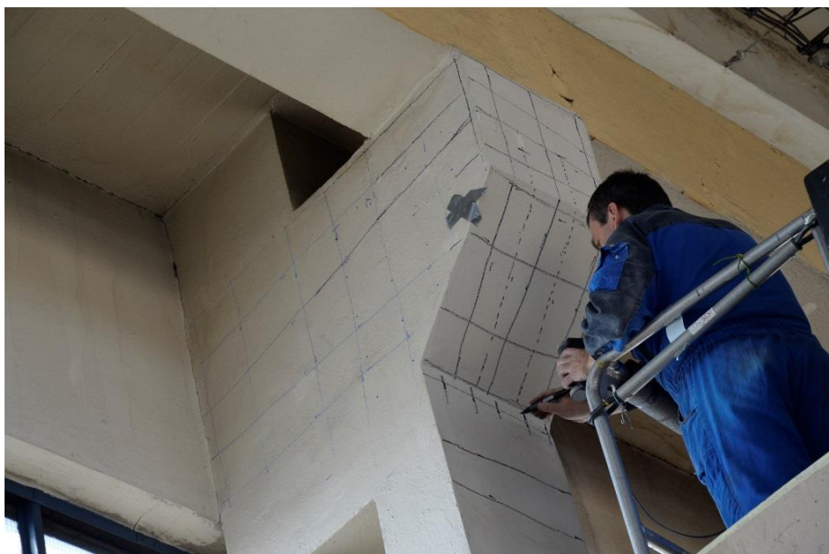
Obr. 147 Liniové měření elektromagnetickým indikátorem napříč sloupem S2 pod konzolou, v místě provedení sondy S2-4. S využitím kalibrace přístroje Profometer PM630 bylo zaměřeno celkem 5 profilů hlavní svislé výztuže o průměru 20 mm. Vnitřní hrana sloupu. Pro další využití byla poloha výztuží současně kreslena na povrch konstrukce [72]
