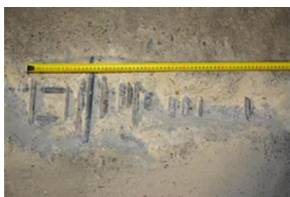
Obr. 65 Dvojice radarových skenů 1200 \times 1200 mm (nahore) pořizená z horní strany železobetonové desky Nákupního centra na Vídeňské ulici v Brně. Uprostřed půdorys stropu s vyznačením ploch obou skenů (H1-2 a H1-1) a výkresem zjištěné výztuže, dole sekaná sonda S1 v místě skrytého průvzlaku a výkres výztužení (řez) v místě sondy. Ve skenech je výztužení jednoznačné, s výjimkou skrytého průvzlaku, kde jsou jednotlivé výztuže díky nahuštění obtížně detekovatelné [53]
