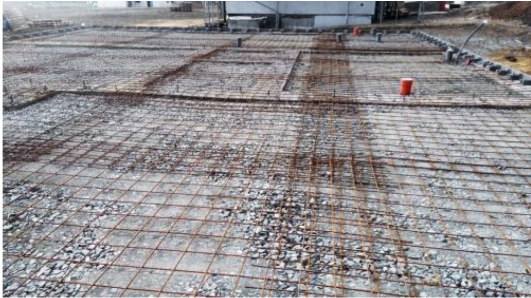
Obr. 162 Situace před betonáží základové desky, ve fázi pokládání svařovaných sítí. Jak je patrné, sítě dosud nejsou mezi uložení na základových pasech podloženy
