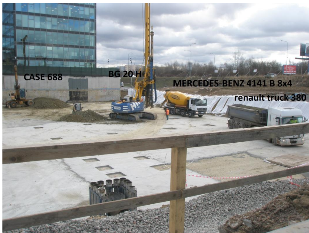
Obrázek 7 Reálný stavební provoz, souběžné zapojení strojů, definování zdrojů hluku [©kantova.r@fce.vutbr.cz]
