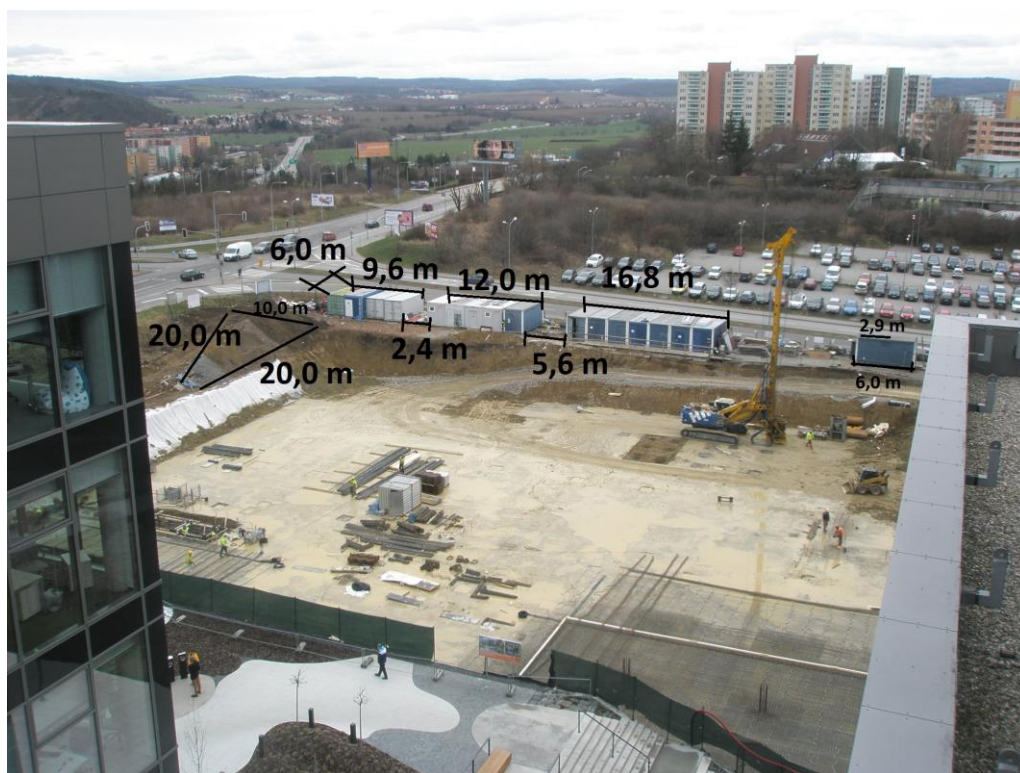
Obrázek 12 Reálný staveništní provoz, souběžné zapojení strojů, definování zdrojů hluku [©kantova.r@fce.vutbr.cz]
