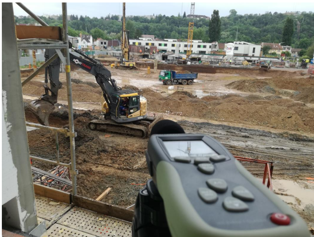
Obrázek 5 Záběry z reálného měření hluku z výstavby hlukoměrem, staveniště výstavby bytových domů se souběžně zapojenými mecha-nismy [©kantova.r@fce.vutbr.cz]
