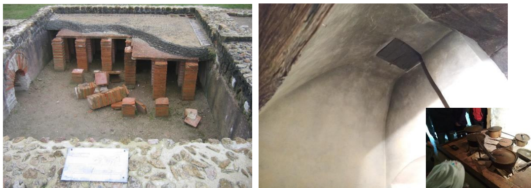
Obr. 56 – Vlevo: spodní část hypokaustového vytápěcího systému z římské vily. Oblast Caen, Francie. Převzato z [223]. Vpravo: místnost nazývaná černá kuchyně (podle barvy stěny zčernalých od sazí a kouře) s otevřeným ohništěm a velkým sopouchem pro odvod kouře do komína (hrad Kost, ČR, archiv autora).
