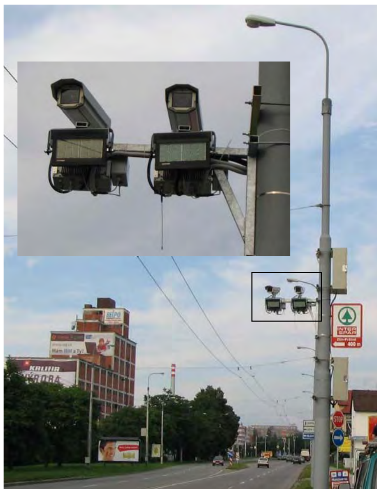
Obr. 49 Instalace systému Unicom v městské zástavbě
