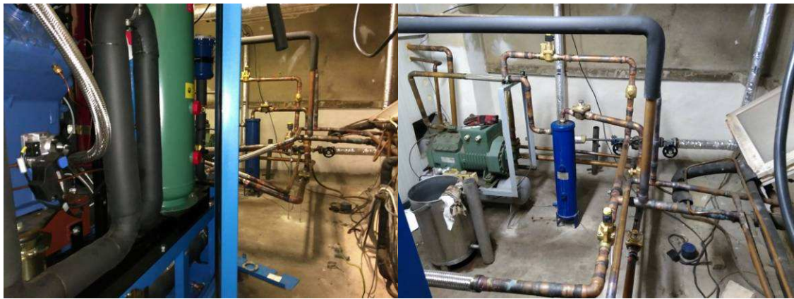
Obr. 5.18 Montáž jednotky ve firmě Steinex a.s., napojení na stávající rozvody
