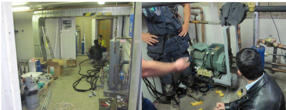
Obr. 5.19 Montáž jednotky ve firmě Steinex a.s., úprava stávajících rozvodů chladu
