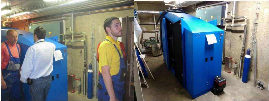
Obr. 5.17 Montáž jednotky ve firmě Steinex a.s., detail jednotky ve strojovně
