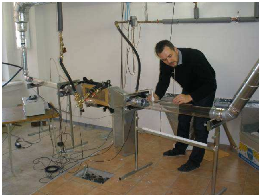
Obr. 6.30 Osazování prototypu 4 do měřicí tratě
