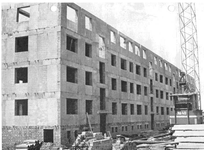
Obr. 9 Blokopanelový systém T 0B. Převzato z [72].
