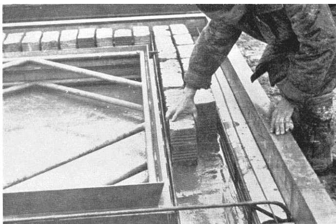
Obr. 13 Ruční ukládání cihelných tvarovek CDKL při výrobě panelu s oknem. Převzato z [72].
