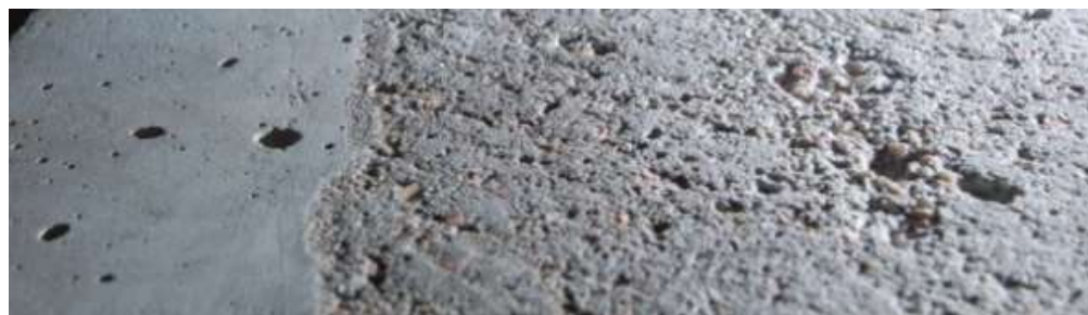
Obr. 4-2 Přejít mezi neošetřeným povrchem betonu (vlevo) a předupraveným povrchem betonu (vpravo). Čištění. Rotační paprsek, tlak 130 MPa, beton C45/55.
