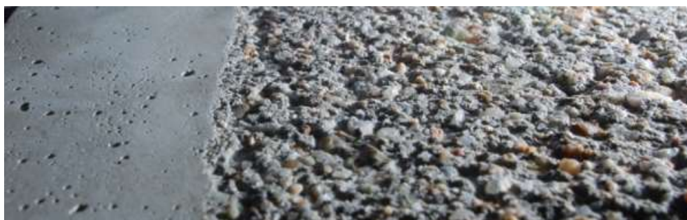
Obr. 4-3 Přejít mezi neošetřeným povrchem betonu (vlevo) a předupraveným povrchem betonu (vpravo). Zdrsnění. Rotační paprsek, tlak 130 MPa, beton C20/25.
