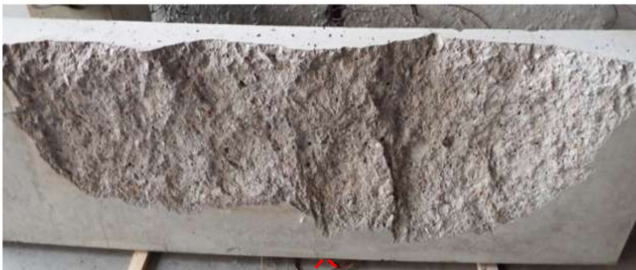
Obr. 10-18 Odprýsknutí betonu na spodní zahřívání straně desky, beton R7-OL-I (cement CEM I 42,5 R, kamenivo biotický granodiorit)
