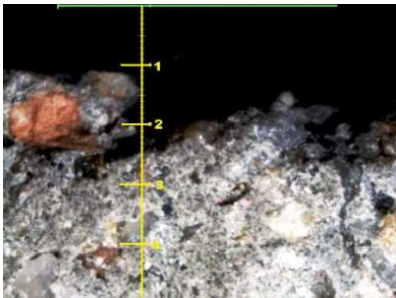
Obr. 7-2 Detail drážky v betonu C40/50, tlak 130 MPa, průměrná hloubka řezu 1,21 mm
