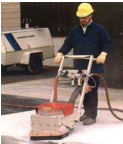
CSP2 – broušení (grinding)
