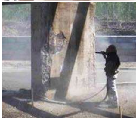
CSP3, CSP5, CSP7 – otryskávání (shotblasting)
