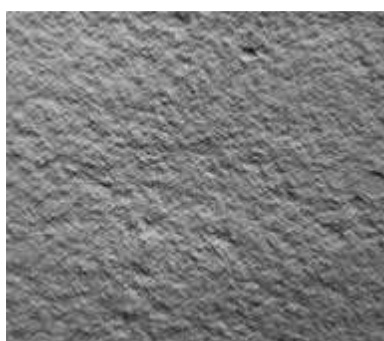
CSP5 – otryskávání (medium shotblast)
