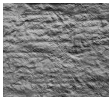
CSP6 – drážkování (medium scarification)
