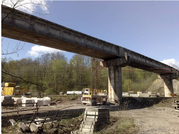
Obr. 108 - Po odbourání kolejového svršku a římsy
