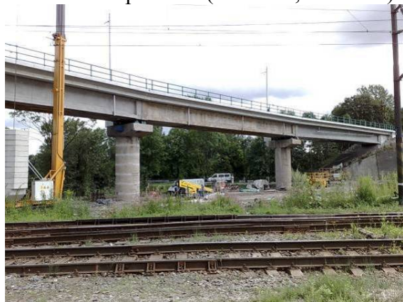
Obr. 116 - Most po dokončení rekonstrukce, před uvedením do provozu
