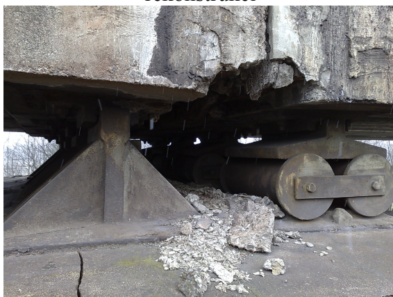
Obr. 77 - Detail mostních ložisek
