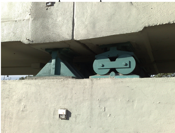
Obr. 82 –Detail ložisek
