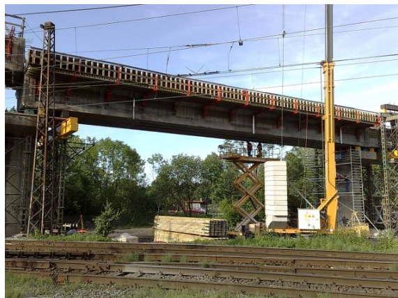
Obr. 110 - Pole 3 před betonáží
