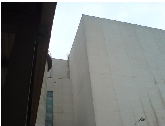
Obr. 175 – ilustrativní pohled na ŠLH z termovizního stanoviště TM1
