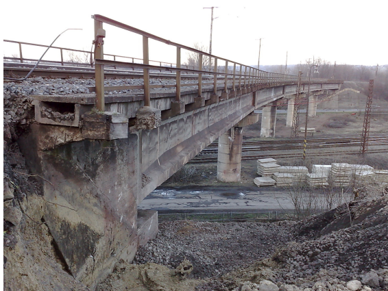
Obr. 75 - Most Gagarin z roku 1961 před rekonstrukcí
