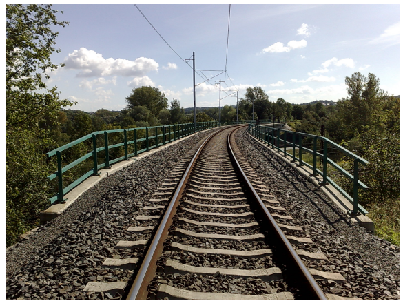
Obr. 83 – Most Gagarin – pohled na kolej po rekonstrukci
