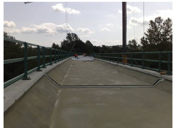
Obr. 115 - Most po betonáží nového koryta
