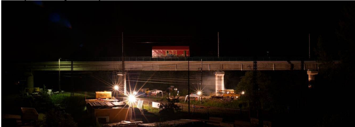
Obr. 120 - Zatížení břemenem tárovacího vozu při ověřovací zatěžovací zkoušce
