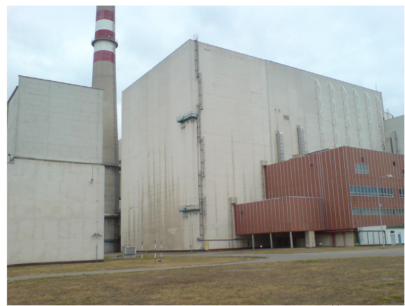
Obr. 176 – ilustrativní pohled na ŠLH z termovizního stanoviště TM2
