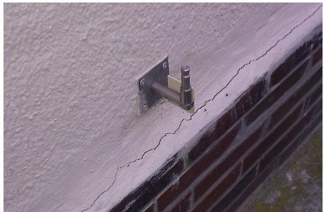
Obr. 187 – detail konzolky s trnem Leica
