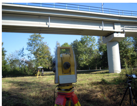
Obr. 103 - monitoring stanicí Topcon 9001A
