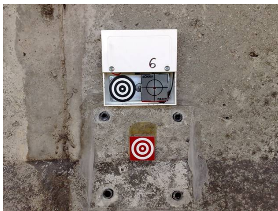
Obr. 92 - Detail měřické značky na mostovce
