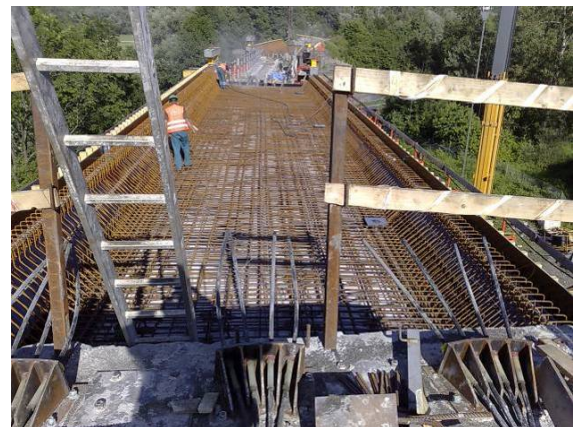
Obr. 111 - Pole 3 před betonáží
