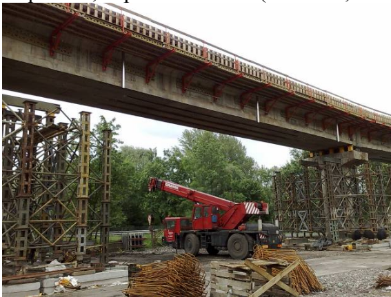
Obr. 112 - Pole 2 před betonáží
