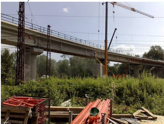
Obr. 114 - Most po betonáží nového koryta
