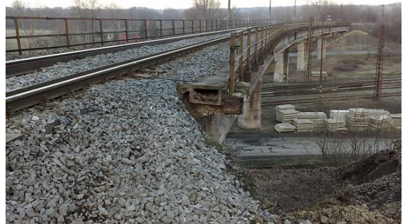
Obr. 107 - Most Gagarin před rekonstrukcí
