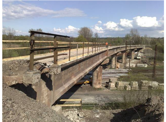
Obr. 109 - Po odbourání kolejového svršku a římsy
