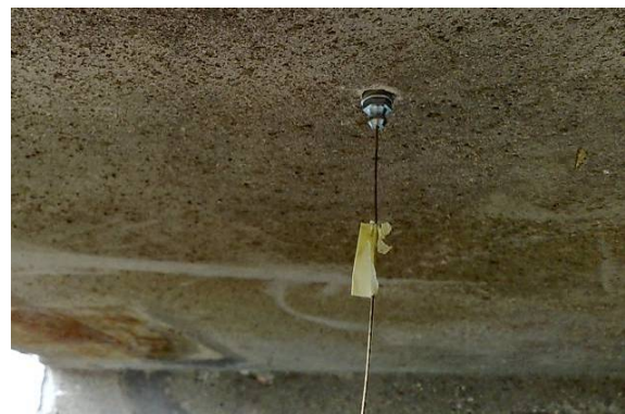
Obr. 127 - Upevnění měřící struny na pohledu nosné konstrukce
