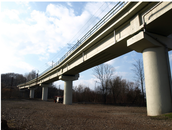
Obr. 80 – Most Gagarin po rekonstrukci – pohled zespodu
