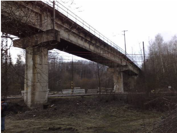
Obr. 106 - Most Gagarin před rekonstrukcí
