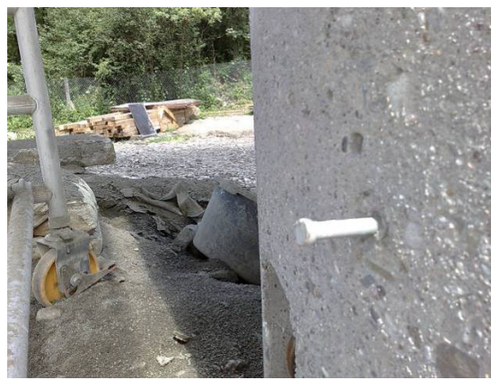
Obr. 93 - Detail výškové měřické značky na podpěře
