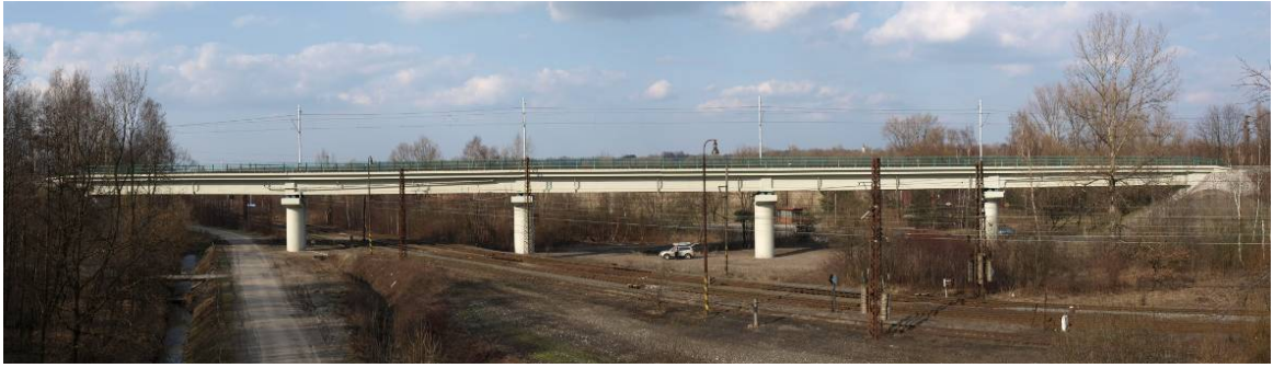
Obr. 79 - Most „Gagarin“ po rekonstrukci
