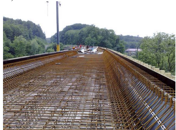
Obr. 113 - Pole 2 před betonáží
