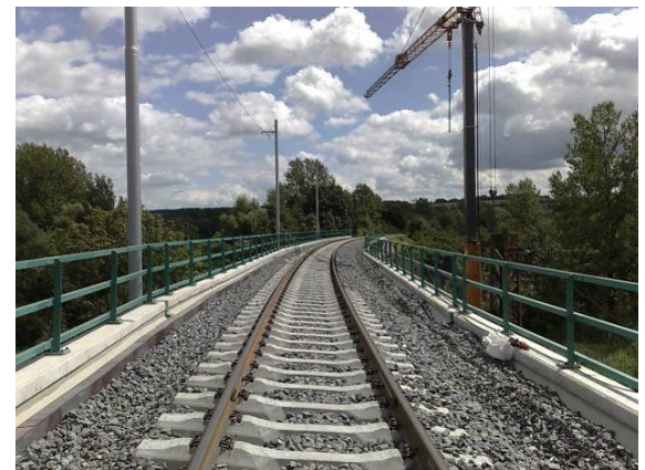
Obr. 117 - Most po dokončení rekonstrukce, před uvedením do provozu
