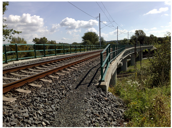
Obr. 81 - Most Gagarin po rekonstrukci
