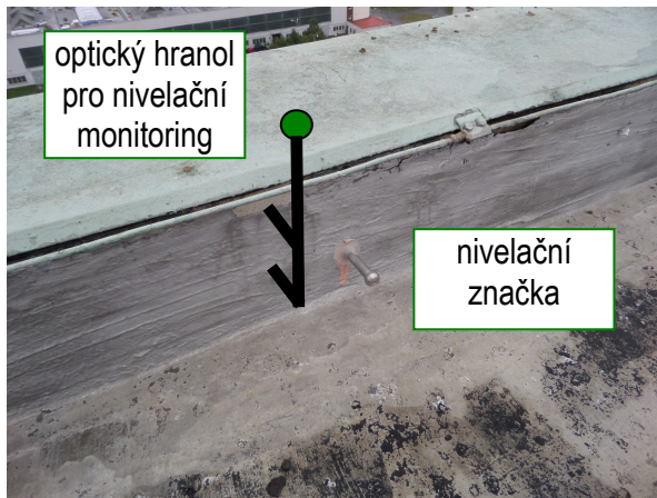
Obr. 190 – osazení čepové nivelační značky do atiky a optického hranolu pro nivelační monitoring
