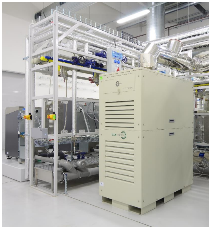
Obr. P4.3 Plynová mikroturbína Capstone C30 v Laboratoři energeticky náročných procesů, NETME Centre
