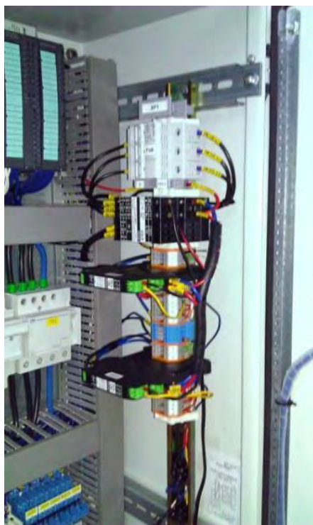
Obr. 46 Elektronické prvky pro měření činného výkonu a řídicího signálu akčních členů [38]
