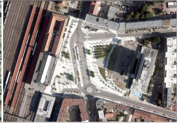
Stav po rekonstrukci – 2015
