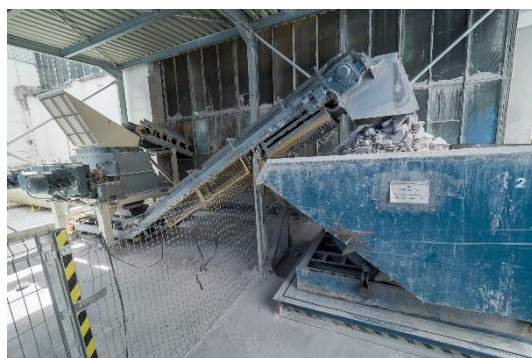
Obrázek 76 První stupeň drcení pórobetonové hmoty
