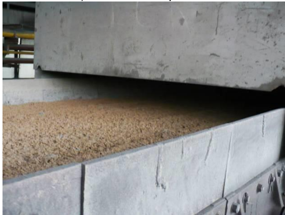
c) Zapálená vsázka postupuje pod exhaustory
