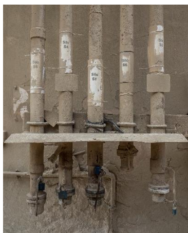
Obrázek 71 Pneumatická doprava pro syké suroviny
