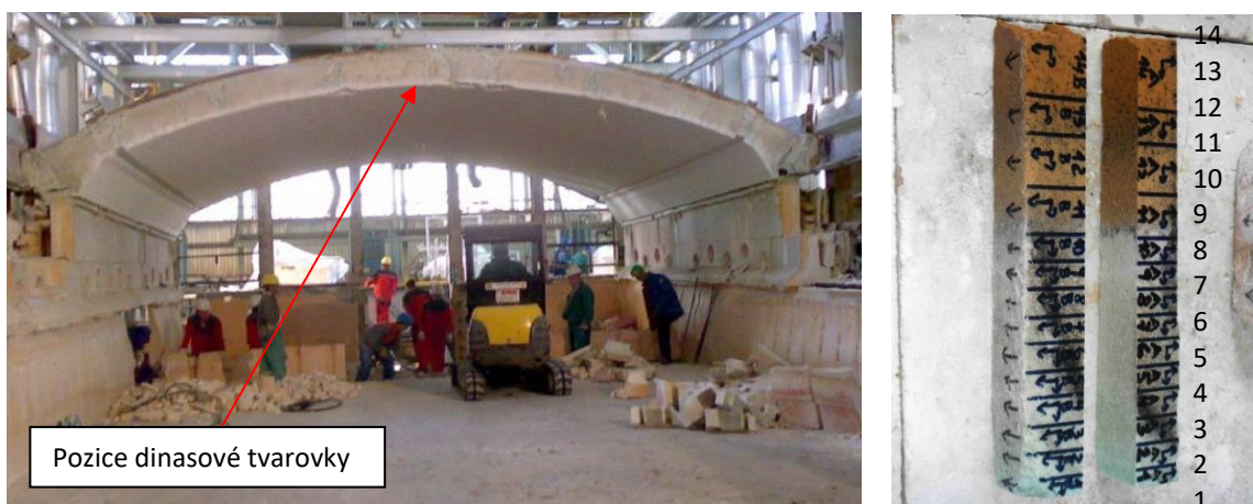
Obrázek 19 Pozice tvarovky v klenbě pece, pozice vzorků na tvarovce. Vzorek 1 je žárový líc tvarovky.
