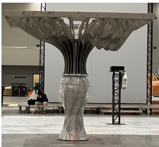
Obr. 70 a 71) Pohled na realizovanou hybridní konstrukci TAPIRUS, díky technologiím parametrického návrhu, digitálního dvojčete, CNC prefabrikace a aditivní výroby 3D tisku betonu (zdroj: autor).
