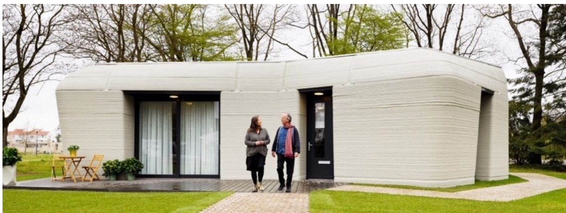
Obr. 22) Pohled na realizovaný dům Milestone realizovaný 3D tiskem betonu (zdroj: https://www.3dprintedhouse.nl/ ).
