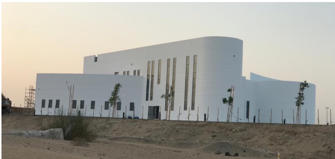
Obr. 27) Budova správy města Dubai se stane světově největší budovou vytvořenou technologií 3D tisku (zdroj: https://www.archdaily.com © Apis cor)
