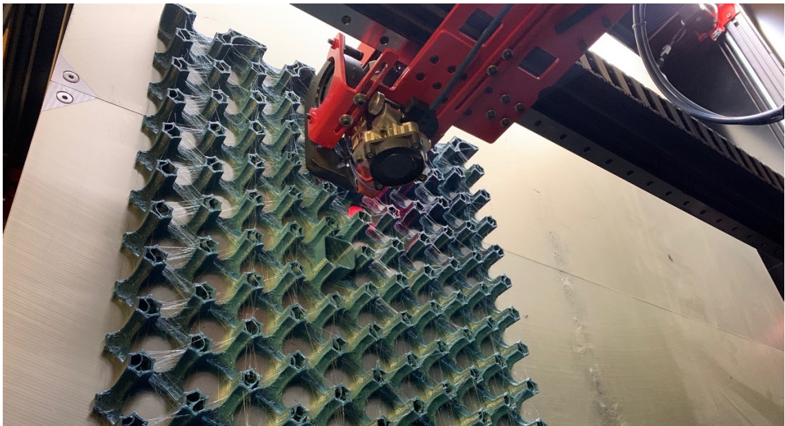
Obr. 19) Výroba vnitřní části panelu zelené fasády technologií 3D tisku recyklovacího PETs parametricky definovanou geometrií (zdroj: autor)
