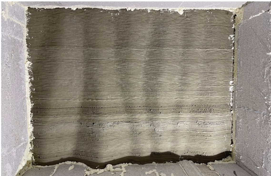
Obr. 92) Pohled na exteriérovou část stěny před osazením povrchových čidel. Patrné dotěsnění montážní PUR pěnou ve styku s osazovacím rámem.
