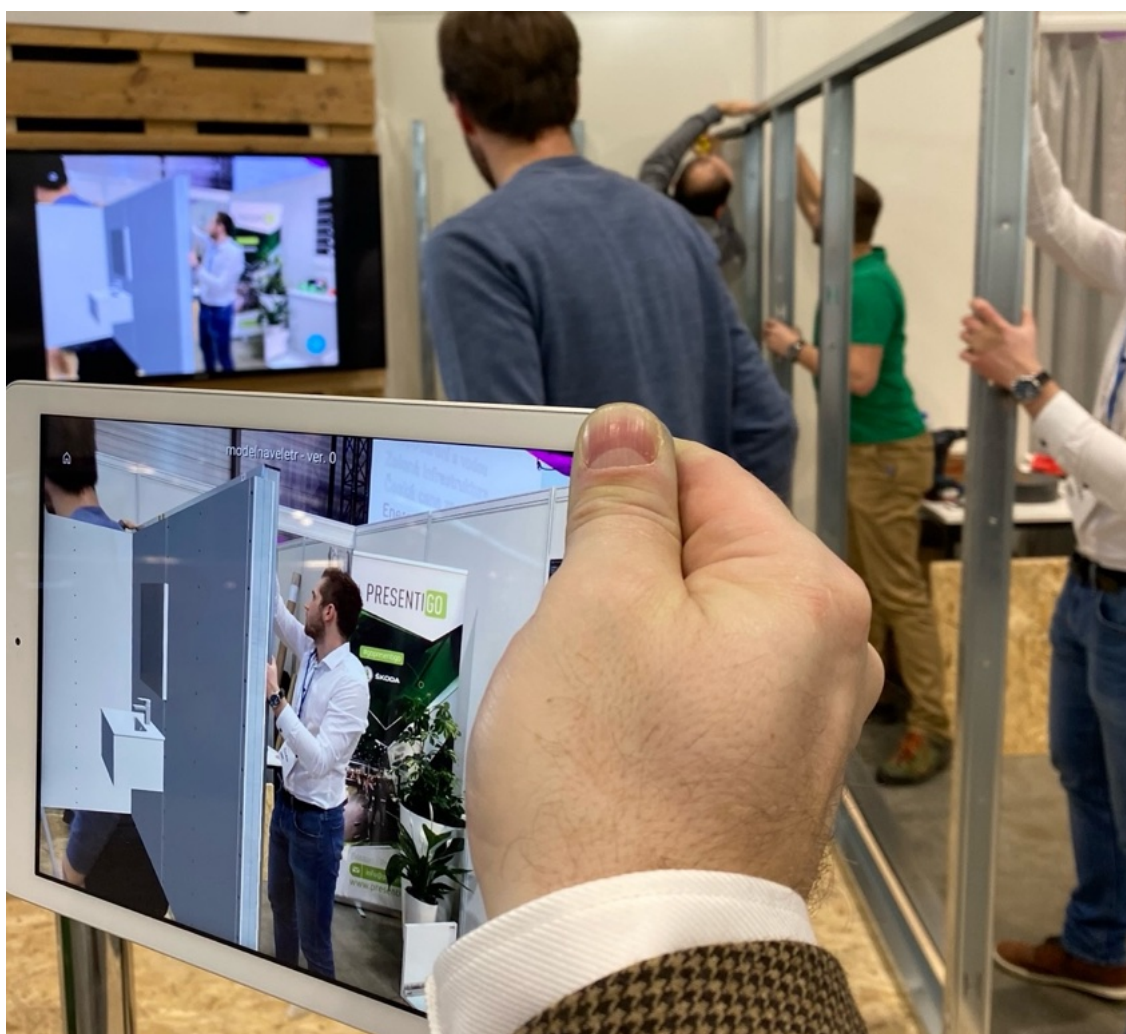
Obr. 53) Pohled na digitální dvojče v rozšířené realitě a na realizaci vnitřní nosné konstrukce příčky (zdroj: autor)
