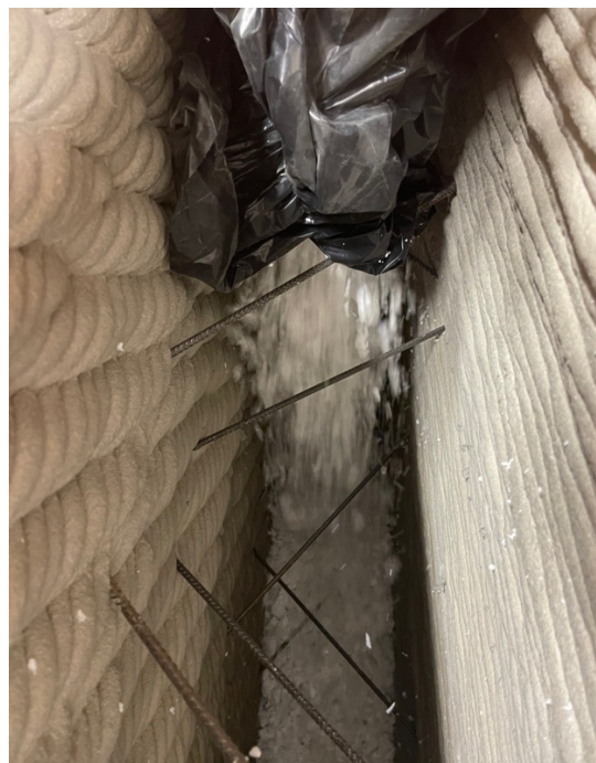
Obr. 83 a 84) Izolace stěn sypaným polystyrenem (zdroj: autor)
