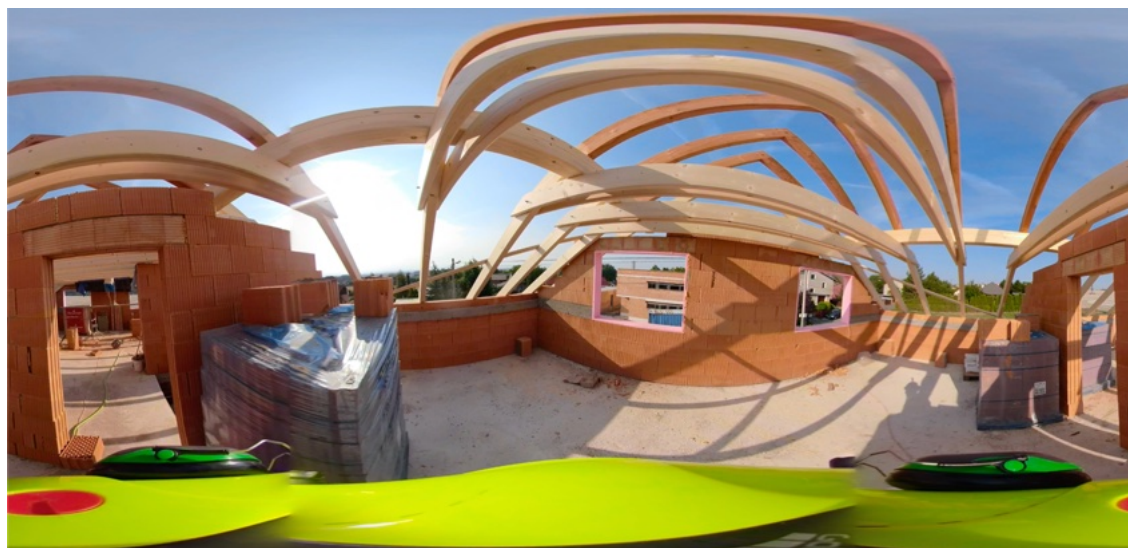
Obr. 54) Rozvinutý 360° záznam dozoru stavby rodinného domu (období lockdownu COVID-19, 2020). Využito pro cloudové sdílení s investorem a dodavateli (zdroj: autor)
