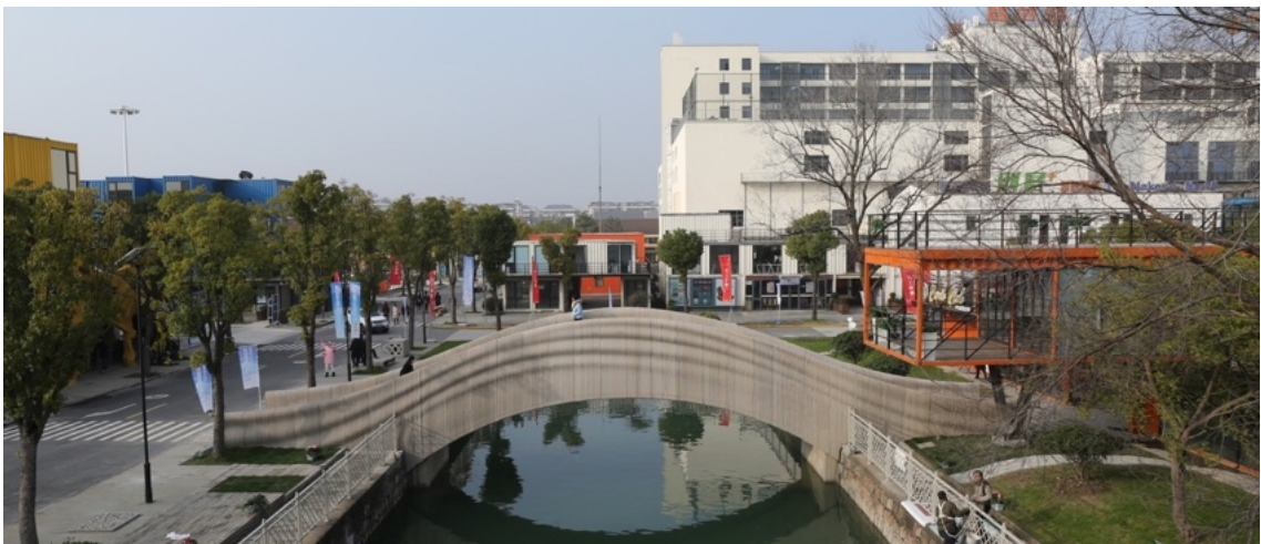
Obr. 26) Most sestavený z elementů vytvořených technologií 3D tisku betonu (zdroj: https://www.archdaily.com/ © Professor Xu Weiguo)
