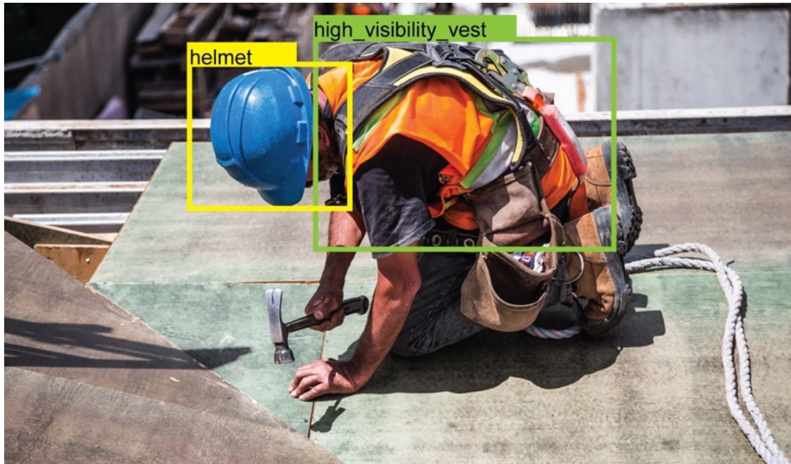
Obr. 3) Společnost AGMIS vyvinula počítačové vidění pro zlepšení bezpečnosti pracovníků v nebezpečných pracovních podmínkách. Toto řešení, umožňuje monitorovat záznamy z bezpečnostních kamer a identifikovat bezpečnostní vybavení jako ochranné helmy, vesty, brýle a boty. (zdroj: https://agmis.com )
