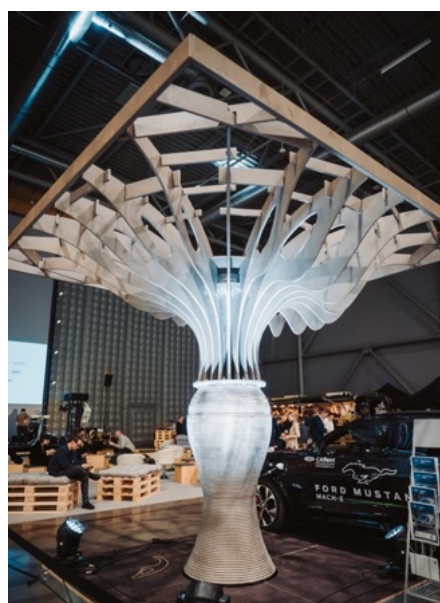
Obr. 70 a 71) Pohled na realizovanou hybridní konstrukci TAPIRUS, díky technologiím parametrického návrhu, digitálního dvojčete, CNC prefabrikace a aditivní výroby 3D tisku betonu (zdroj: autor).
