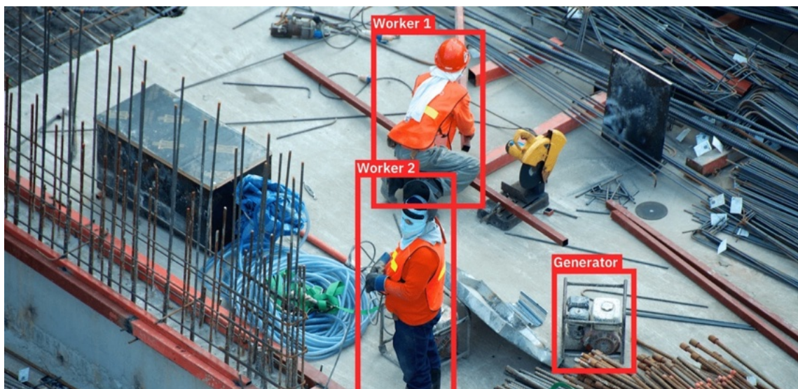
Obr. 2) Detekce osob a předmětů na staveništi z bezpečnostních kamer pomocí AI a strojového učení [2]
