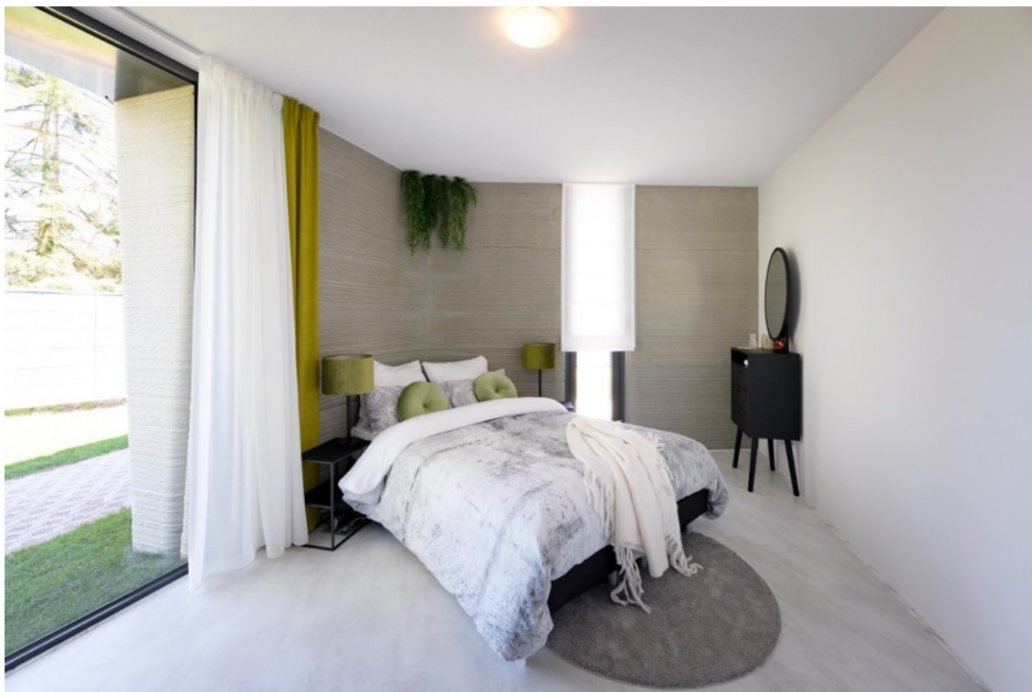
Obr. 23) Interiér objektu Milestone s ponechaným pohledovým prvkom 3D tištěné struktury betonu (zdroj: https://www.3dprintedhouse.nl/ ).
