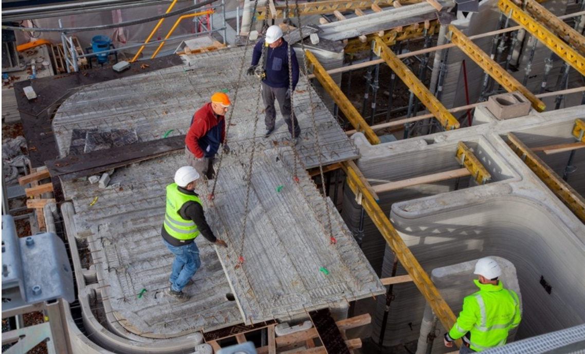
Obr. 25) Pohled na realizaci filigránového stropu na 3D tištěné stěny s monolitickým jádrem (zdroj: https://mense-korte.de ).
