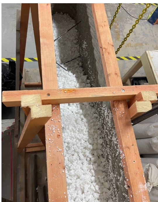
Obr. 83 a 84) Izolace stěn sypaným polystyrenem (zdroj: autor)
