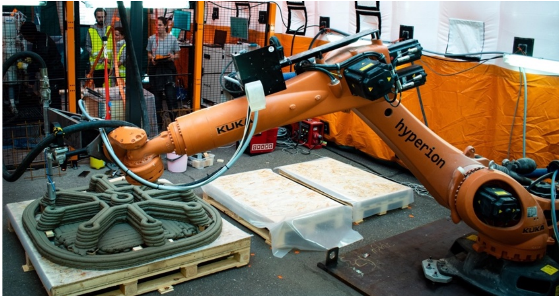
Obr. 21) 3D tisk základové patky s tvarovou optimalizací z vysokohodnotného betonu. Projekt Hyperion Robotics a Peikko na staveništní 3D tisk ve finském Lahti (zdroj: https://www.hyperionrobotics.com/projects ).
