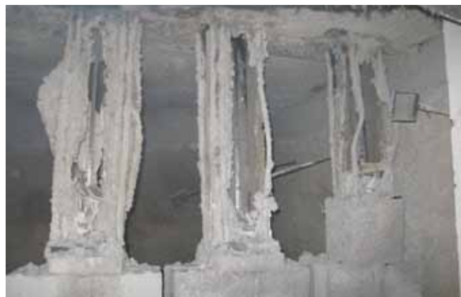
Vyvíjená kompozitní výztuž ve zkušebních rámech po provedené požární zkoušce – pohled do pece
