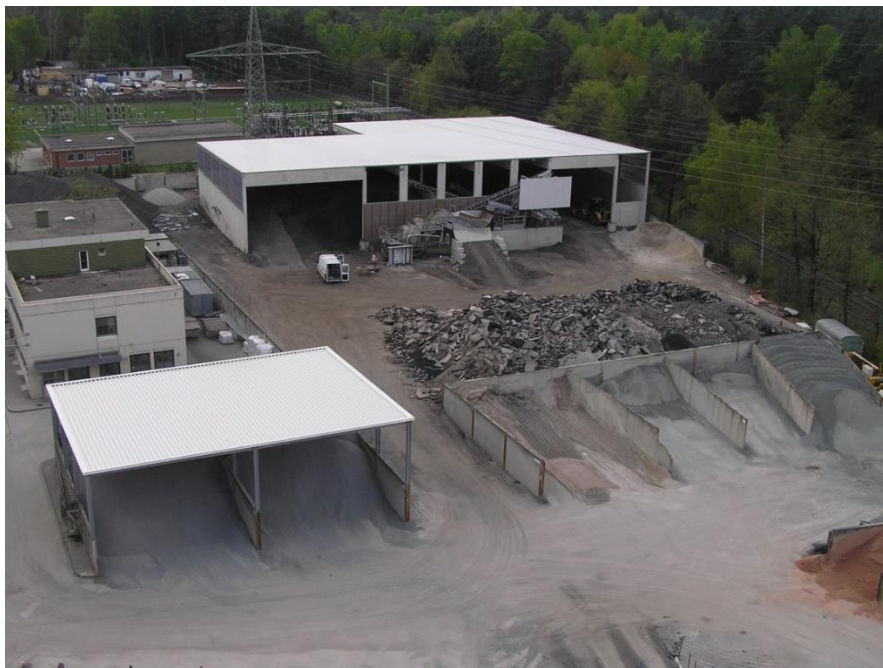
Obrázek 2 Zastřešení skládky předrceného R-materiálu
