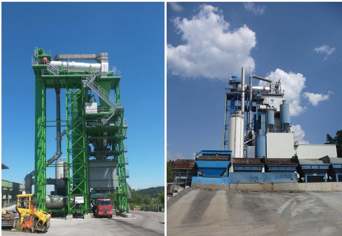
Obrázek 13: Obalovny asfaltových směsí vybavené paralelním sušícím bubnem – vlevo Česká republika - Bruntál, vpravo Spolková republika Německo - Norimberk
