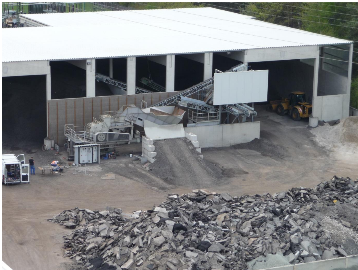
Obrázek 9: Zastřešení skládky R-materiálu
