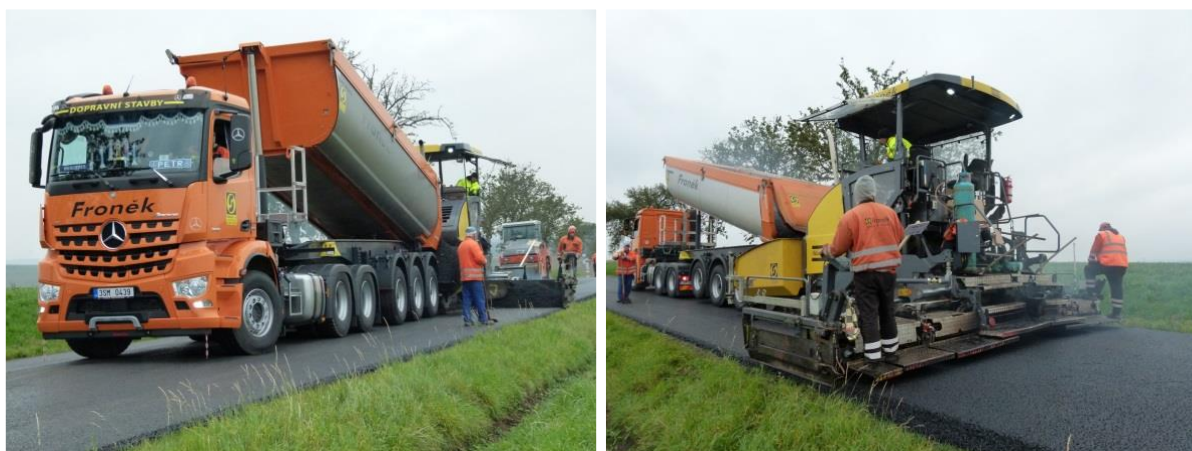
Obrázek 23: Pokládka směsí SMA 11S s 50 % podílem R – materiálu [54], vlevo: doprava směsí, vpravo: finišer
