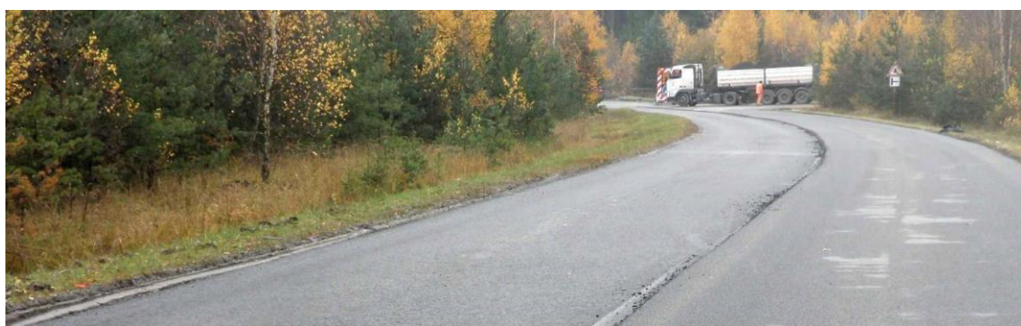
Obrázek 20: Provádění pokusného úseku
