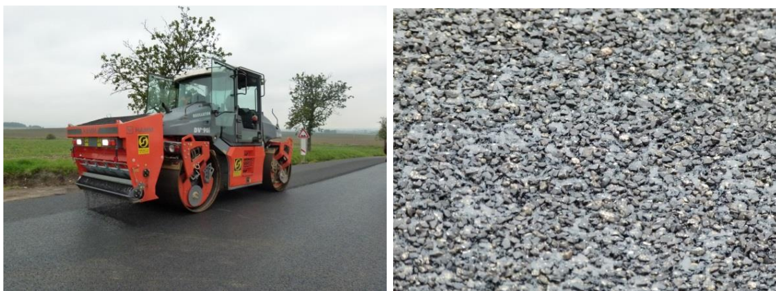
Obrázek 24: Vlevo: Poslední fáze hutnění s podrťováním povrchu vrstvy, vpravo: detail hotové zhutněné vrstvy [54]
