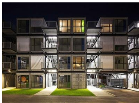
Obr. 182: Vertikálne komunikačné jadrá vysokoškolského domova v Le Havre vo Francúzsku dynamicky akcentujú monotónnu schému opakujúcich sa modulárnych buniek. ( Zdroj: FILLON, V. Cité a docks - student housing [online].
