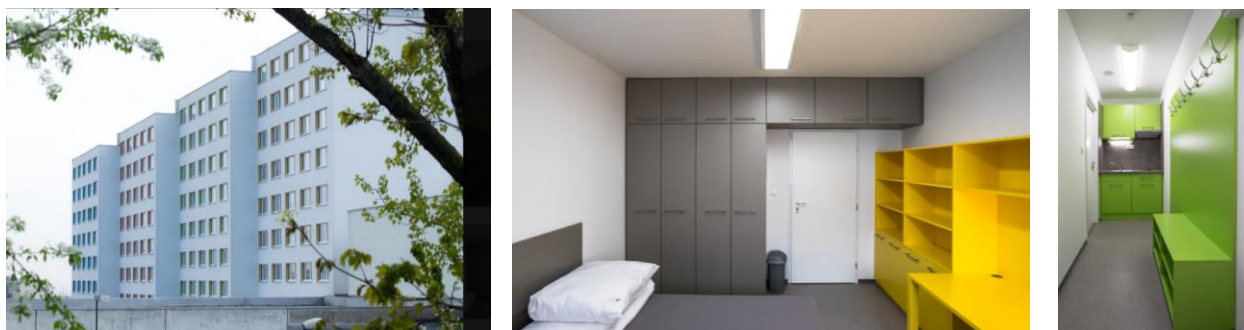
Obr. 46: Rekonštrukcia „Manželských internátov“ v Mlynskej doline (2007-2014), architektonický ateliér Endorfine, Bratislava. Obnova objektu študentského domova v havarijnom stave. Štyri farby charakterizujú jednotlivé sekcie panelovej prefabrikovanej výstavby: v exteriéri akcentujú ostenia, v interiéri definujú vertikálne komunikačné jadrá a zároveň odtieň nábytku. ( Zdroj : DUPKALA, T. a kol. Internáty mlynská dolina [online]. )
