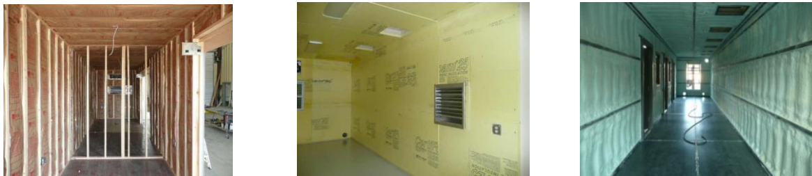
Obr. 156: Možnosti zateplenia prepravných kontajnerov zo strany interiéru: hrádzená konštrukcia s vloženou minerálnou vatou, aplikácia tvrdeného polystyrénu a striekaná penová izolácia. Penová izolácia zabezpečí dokonalú príľnavosť, čím sa predchádza korózii a plesniam. Môže sa aplikovať na vonkajšie aj vnútorné steny kontajnera. Nevýhodou je jej vyššia cena. ( Zdroj: Insulation: Interior Finishing [online]. )
