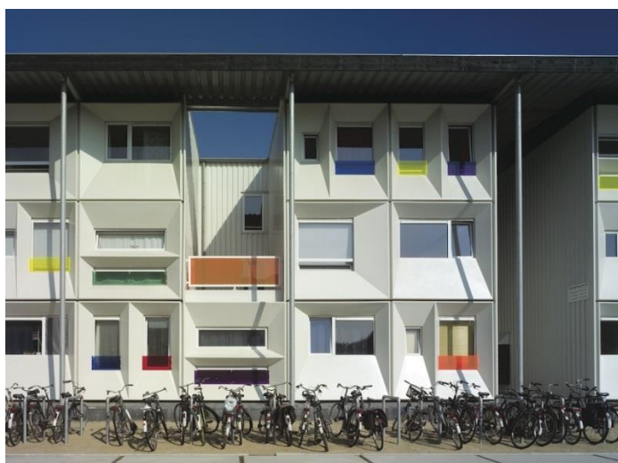
Obr. 127: Lapidárnosť prefabrikovaného systému oživuje plasticita fasád, kde jednotlivé obytné bunky majú okenné otvory v zošikmených osteniach vsunutých do vnútra objektu, okná variujú v rozmeroch i farbách plôch. ( Zdroje: FRIEDMAN, A. Innovative student residences, s. 71.; Student houses, Amsterdam, Netherland [online].)
