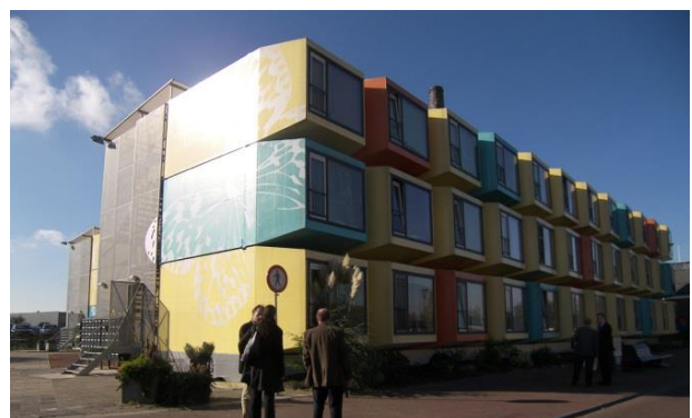
Obr.87: Vysokoškolský komplex v meste Eindhoven: modulárne jednotky v bielej farbe a Spacebox v Amersfoorte - vo farebnom prevedení. ( Zdroj: Holland COMPOSITES. Prefabricated living modules [online]. )
