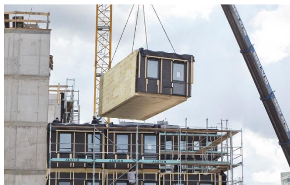
Obr. 115: Drevená prefabrikovaná modulárna jednotka zaizolovaná minerálnou vatou je po zhotovení v špecializovanej fabrike osadená na mieste výstavby. ( Zdroj: Woodiefy your life [online]. )
