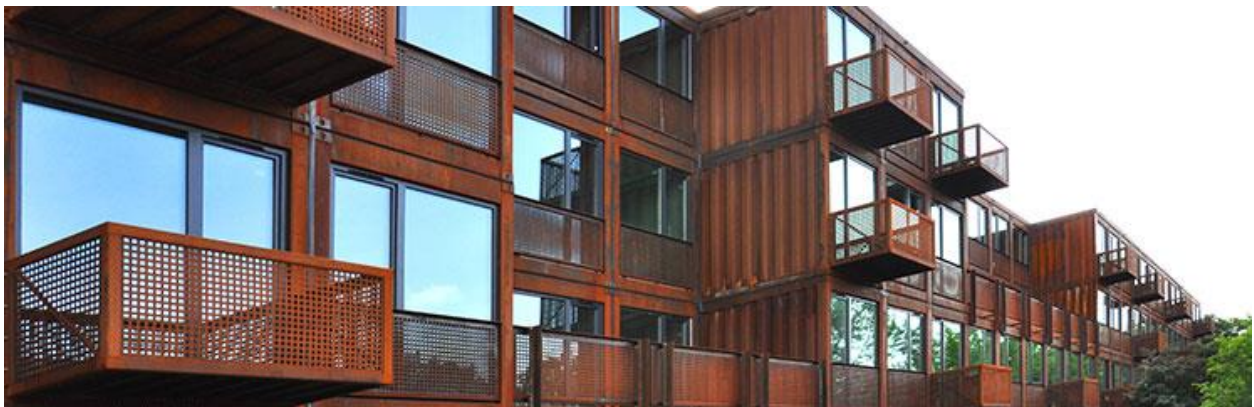
Obr. 134: Pohľad na pozdĺžnu fasádu jedného z trojice objektov ubytovacieho komplexu v Berlíne. Industriálny výraz objektu podčiarkuje aplikácia oceľovej fasády Corten. ( Zdroj: Modulares Bauen [online]. )
