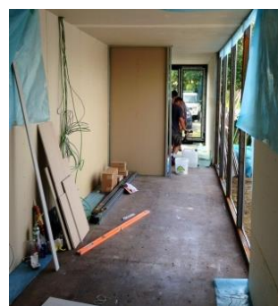
Obr. 137: Proces modifikácie prepravných kontajnerov prebiehal v exteriéri, finalizácia interiérových povrchov priamo na mieste výstavby. ( Zdroj: Duske, J. Das Projekt EBA51 [online]. )
