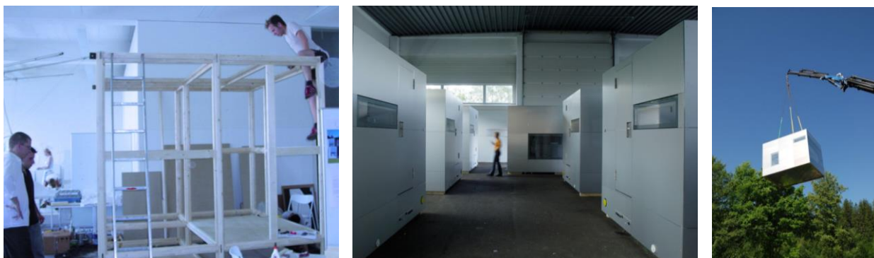
Obr. 73: Výroba obytnej jednotky micro-compact home vo fabrike. Počas jej výroby sa na parcele zrealizujú prípojky inžinierskych sietí, jednoduché základy s pomocným hliníkovým rámom na osadenie, chodníky a výsadba. Objekt sa zvyčajne preloží z nákladného auta na pozemok žeriavom, čo minimalizuje poškodenie plochy parcely. ( Zdroj: HORDEN, R. Micro-compact home: technical specifications [online]. )
