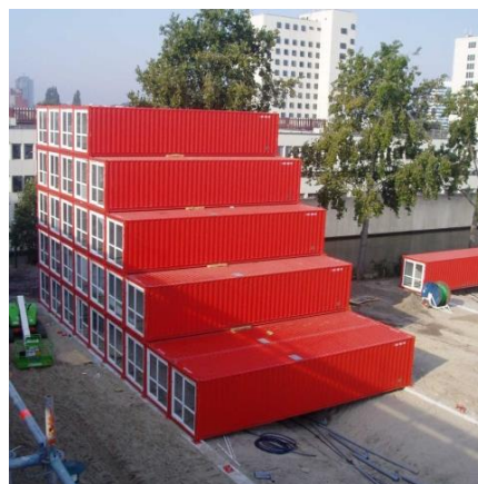
Obr. 122: Konverzia kontajnerov na študentské obytné bunky prebiehala vo fabrike. Na mieste výstavby boli kontajnery ukladané a pripevňované na seba v piatich radoch. ( Zdroj : Keetwonen [online]. )
