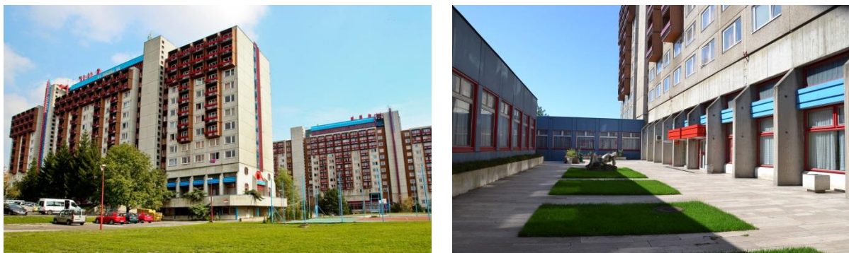
Obr. 45: Čitateľnosť konštrukčnej prefabrikovanej skladby objektu na priečeliach, špecifická plasticita a akcentovanie farbou. Vysokoškolský domov Družba, Bratislava. ( Zdroj : Vysokoškolský internát Družba [online]. )
