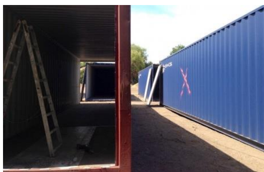
Obr. 137: Proces modifikácie prepravných kontajnerov prebiehal v exteriéri, finalizácia interiérových povrchov priamo na mieste výstavby. ( Zdroj: Duske, J. Das Projekt EBA51 [online]. )
