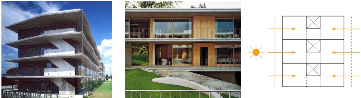
Obr. 163: Analógia obojstrannej orientácie študentských ubytovacích miestností je čitateľná aj u ikonických vysokoškolských domovov realizovaných konvenčnými stavebnými technológiami, benefitom je prísun denného svetla z oboch strán dispozície ubytovacej bunky . Vysokoškolský domov Garching v Nemecku, architekti: Dietrich Fink, Thomas Jocher a vysokoškolský domov Mendrisio vo Švajčiarsku. ( Schéma - autor. Zdroje fotografií: HEINRICH, M. Studentenwohnen Campus [online]; CASIRAGHI, A. Gegenüber , s. 39. )
