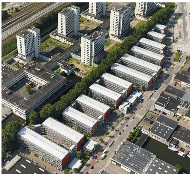
Obr. 119: Ekonomicky efektívne radenie budov ubytovacieho komplexu Keetwonen v Amsterdame. Typická fasáda objektu s opakovaným modulom červenej farby, veľkým presklením a balkónom. ( Zdroj: Keetwonen [online]. )
