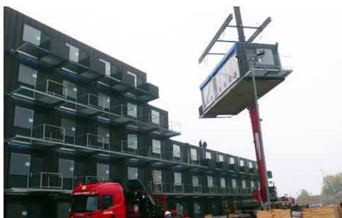
Obr. 96: Osadzovanie modulárnych jednotiek na mieste výstavby. Ubytovací areál Zuiderzeeweg. ( Zdroj: Gestapelt auf Zeeburgereiland: Wohnheim von Fact Architects in Amsterdam bezogen [online]. )
