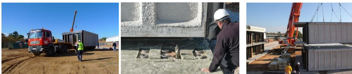
Obr. 151: Prevoz modulárnej bytovacej jednotky a osadenie na základovú železobetónovú platňu. Vysokoškolský domov v Barcelone. ( Zdroj: LIESE, J. Stacked modules: Student housing near Barcelona [online]. )
