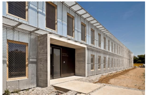
Obr. 175: Architektonická identifikácia vstupného priestoru - vynechaním modulárnych buniek, doplnením predsadenej atypickej konštrukcie závetria. Modulárny vysokoškolský domov Qubic v Amsterdame a internát v Barcelone.
