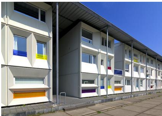
Obr. 175: Architektonická identifikácia vstupného priestoru - vynechaním modulárnych buniek, doplnením predsadenej atypickej konštrukcie závetria. Modulárny vysokoškolský domov Qubic v Amsterdame a internát v Barcelone.
