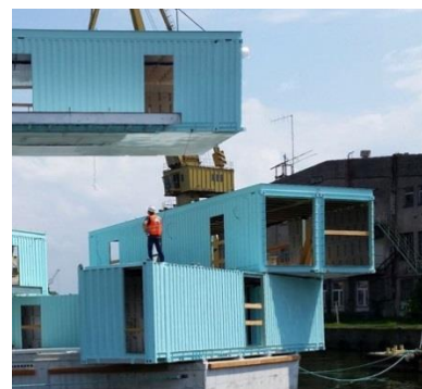
Obr. 143: Recyklácia lodných kontajnerov vo fabrike, osadenie na betónový pontón pomocou žeriava. ( Zdroj: Urbanrigger [online]. )
