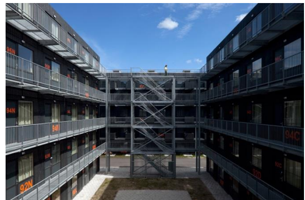
Obr. 95: Drevený fasádny obklad v kombinácii s pozinkovanými oceľovými konštrukciami balkónov, pavlačí a schodísk. Ubytovací areál Zuiderzeeweg. ( Zdroj: Zuiderzeeweg [online]. )
