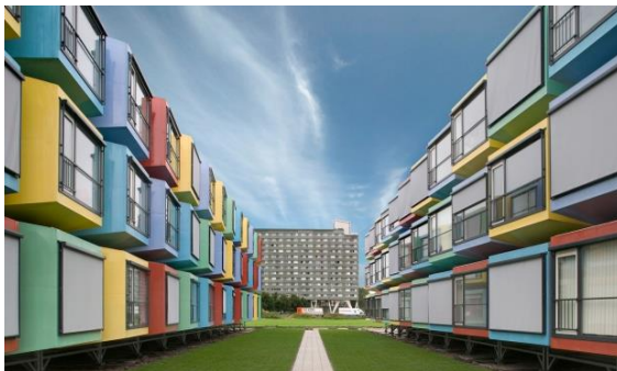
Obr. 179: Dislokovateľný modulárny vysokoškolský domov Spacebox v Utrechte. Vysokoškolský domov Duwo v Delfte, architektonický koncept nepredpokladá jeho premiestnenie v budúcnosti. ( Zdroj: HOLLAND COMPOSITES. Prefabricated living modules [online].; : Student Housing DUWO: Delft, Netherlands [ online ].)
