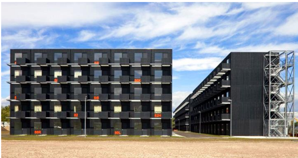
Obr. 93: Tmavá fasáda vysokoškolského ubytovacieho areálu Zuiderzeeweg je komponovaná so striktno opakovaných objemov obytných modulov. ( Zdroj: MEINHOLD, B. Zuiderzeeweg [online]. )
