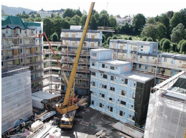
Obr. 109: Výroba modulárnych jednotiek vo fabrike: prefabrikované hygienické jadrá ako súčasť bunky. Využitie lodnej dopravy na prevoz modulárnych buniek na stavebný pozemok. Stohovanie ubytovacích jednotiek: prenos žeriavom. ( Zdroj: POPP, P. Modulare Vielfalt: Studenten-Apartments von 3RW arkitekter [online]. )
