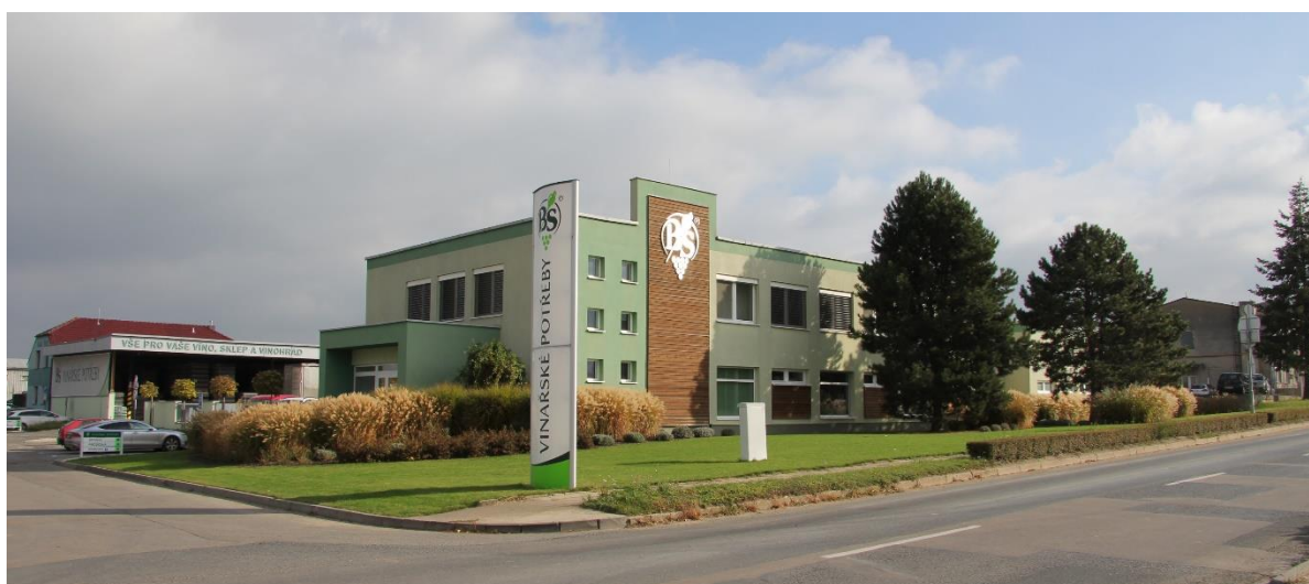
Obr. 105 „Areál Vinařských potřeb BS ve Velkých Bílovicích“ (okr. Břeclav)
