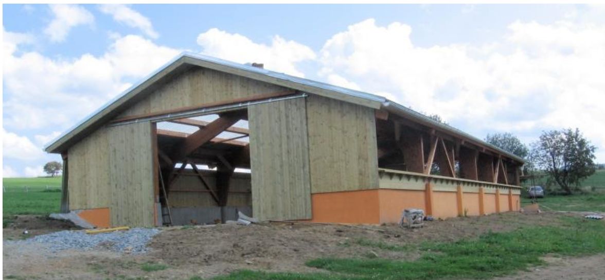
Obr. 35 Dřevostavba ovčína v Dlouhé Stropnici s využitím rámové konstrukce TESKO. Zdroj: Internet
