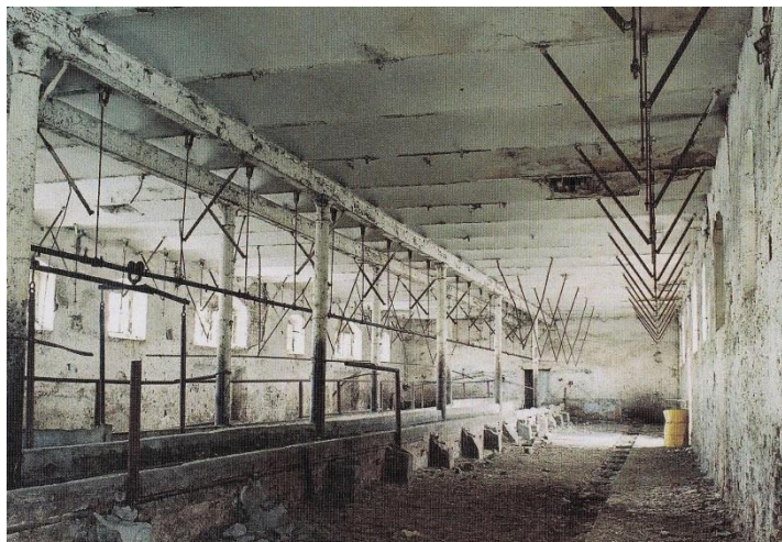
Obr. 25 Interiér kravínu Karlín (okr. Kolín) z 80. let 19. stol. se zastropením klenbami do železných nosníků nesených dvěma řadami litinových sloupů podél střední chodby. Zdroj: Žižka, J.: Hospodářské dvory bývalých panství v Čechách, str. 100
