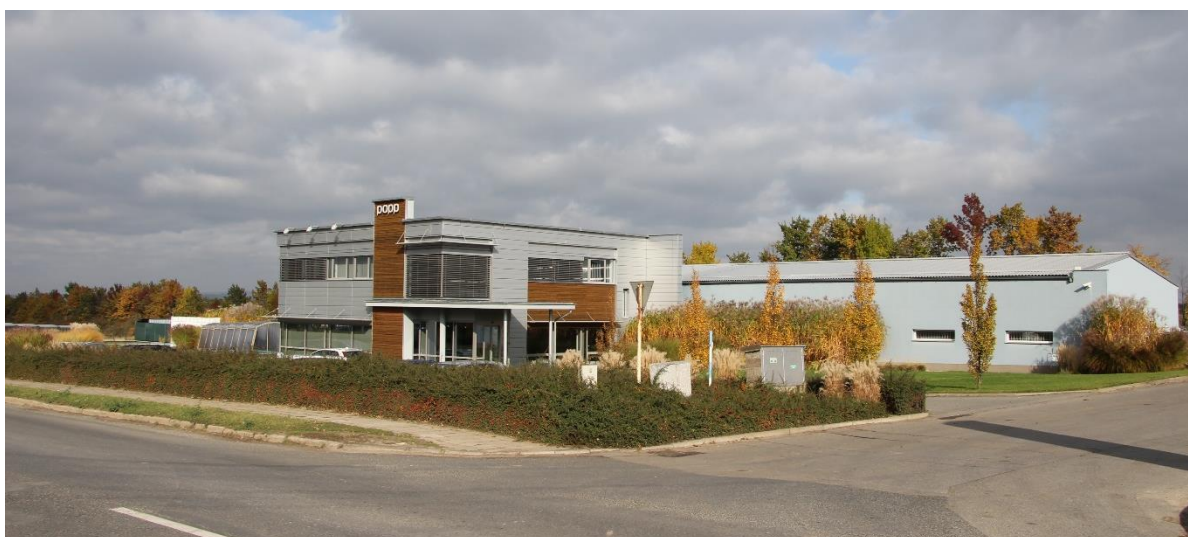
Obr. 106 „Areál Vinařských potřeb BS ve Velkých Bílovicích“ (okr. Břeclav)
