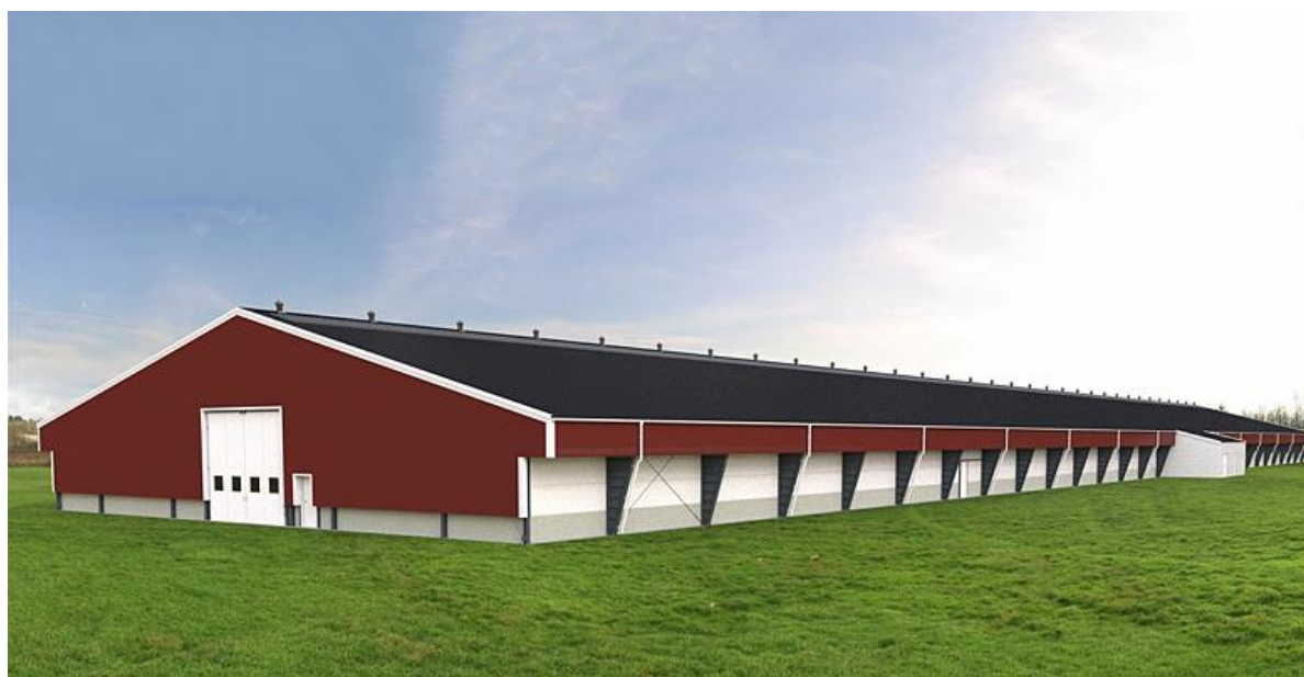
Obr. 66 Příklad soudobého architektonického výrazu haly chovu drůbeže.
