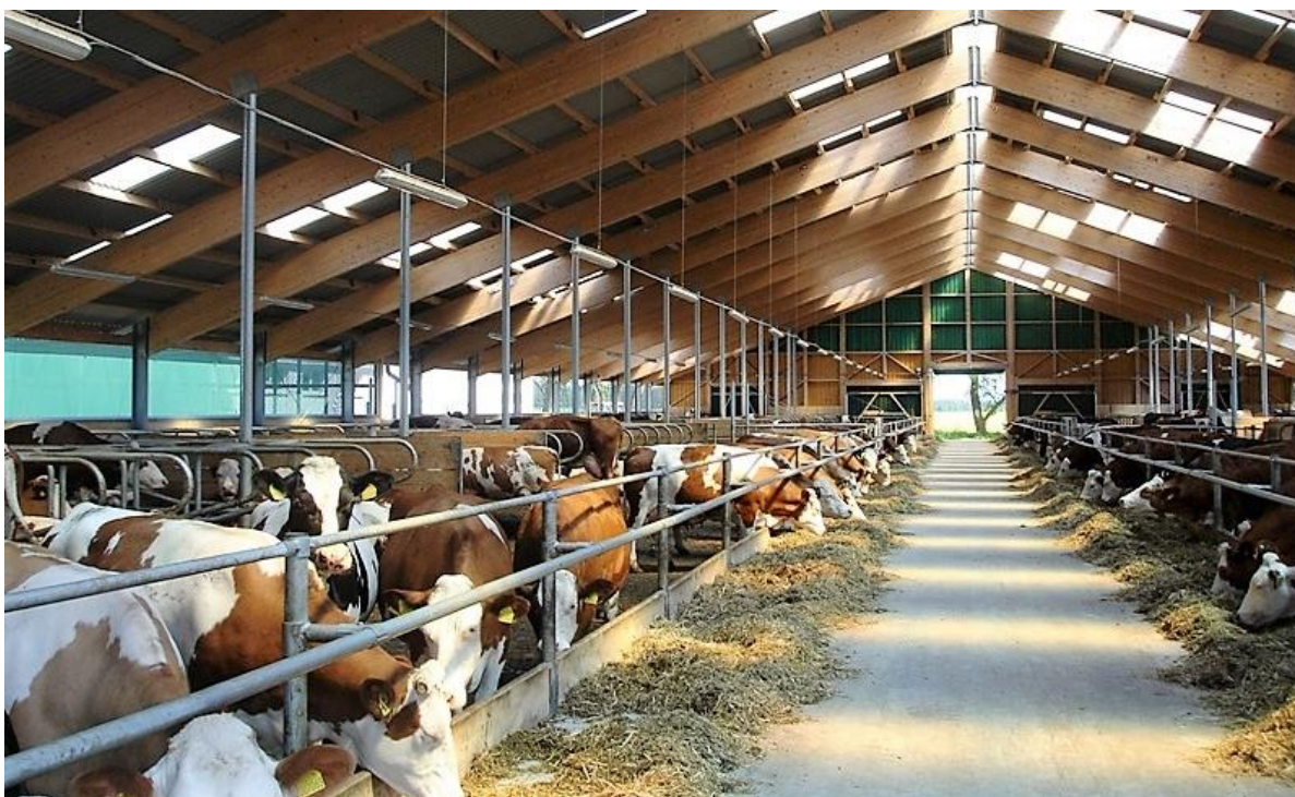
Obr. 54 Ukázka moderní ocelo-dřevěné haly výkrmu skotu. Šířka objektu 32 m, délka 74 m. Zdroj: WOLF SYSTÉM s.r.o. - výrobce a dodavatel ocelo-dřevěných hal
