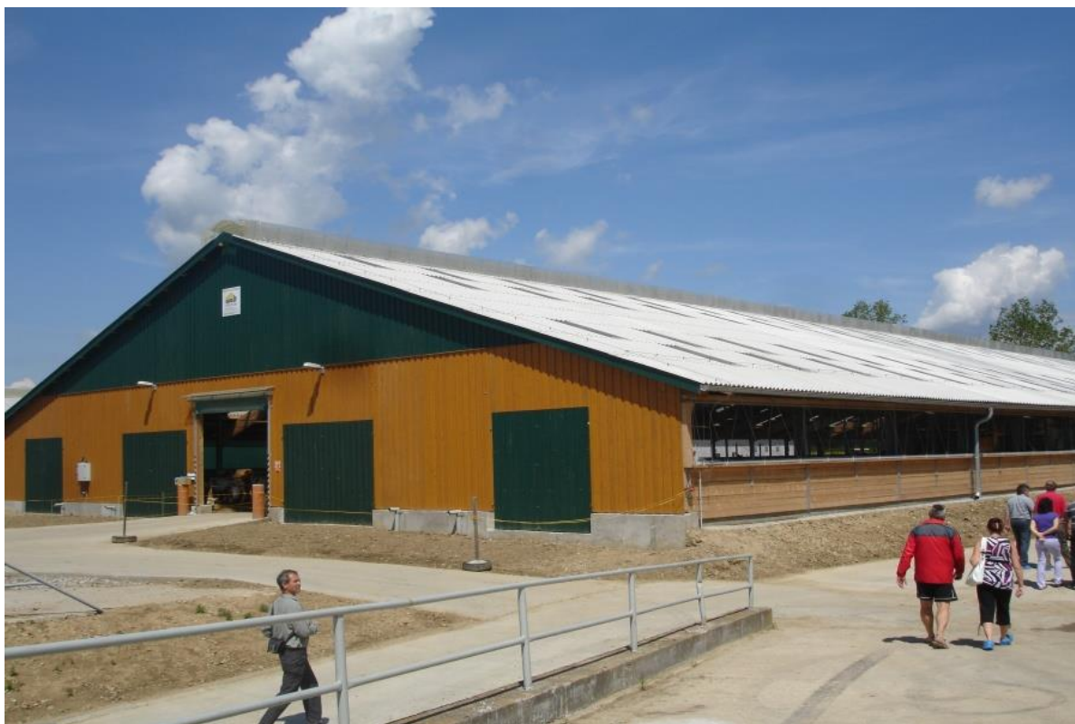
Obr. 53 Ukázka moderní ocelo - dřevěné haly výkrmu skotu. Šířka objektu 32 m, délka 74 m. Zdroj: WOLF SYSTÉM s.r.o. - výrobce a dodavatel ocelo - dřevěných hal
