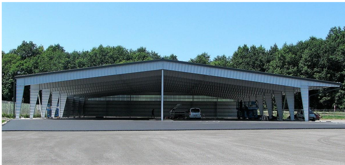
Obr. 79 Hala pro uskladnění zemědělské techniky: š. 36 m, dl. 56 m, v. 5m. Zdroj: BORGÁ s.r.o. – montované haly
