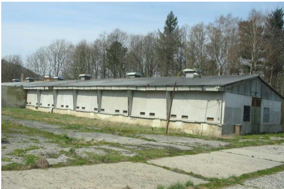
Obr. 65 Příklad stavby objektu socialistické drůbežárny včetně typického stavu okolního parteru. Zdroj: Dýr, P., autorské foto
