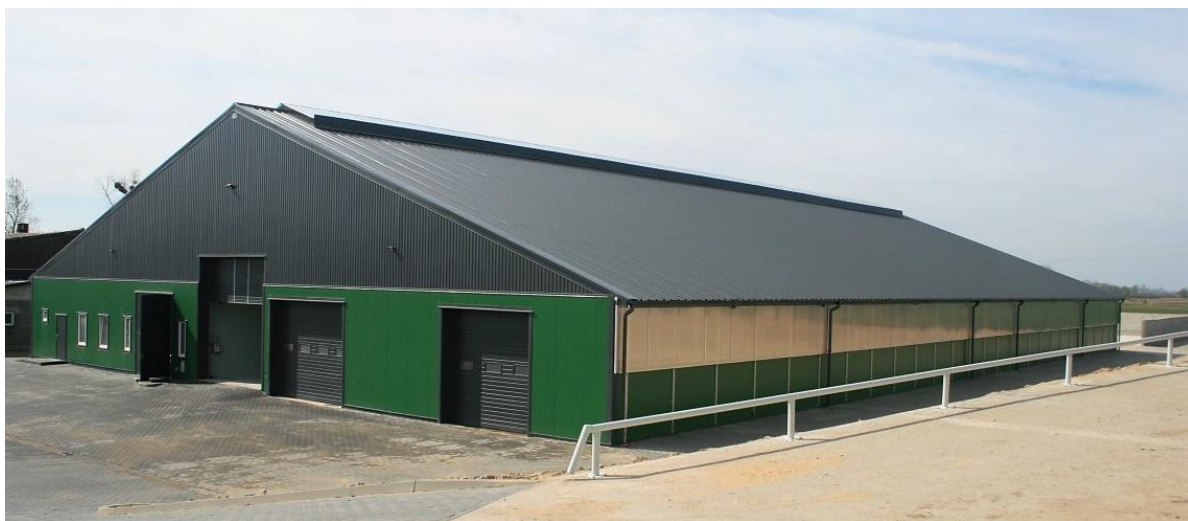
Obr. 51 Ukázka moderní ocelové haly chovu mléčného skotu. Šířka objektu 36 m, délka 60 m. Zdroj: BORGA s. r. o., Popůvky u Brna - výrobce a dodavatel ocelových hal
