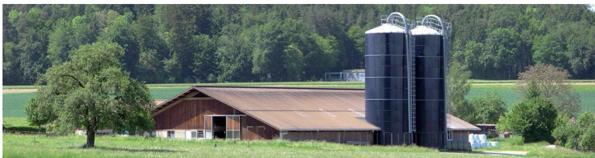
Obr. 80 Vertikální zásobníky kejdy jako kontrastní prvek k horizontálnímu objektu stájí. Zdroj: PERMASTORE s.r.o. – smaltované nádrže
