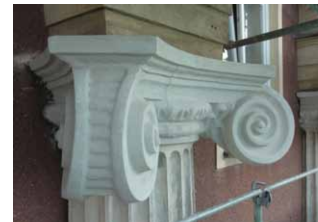
Soudobá náhrada poškozených hlavic dekorativních sloupů novodobými prefabrikáty (Hlavní třída v Porubě, podzim 2015). Zdroj: Fotografie Eva Špačková
