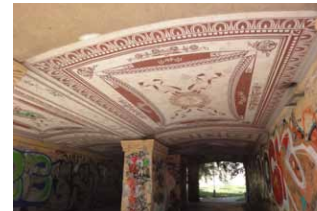
Soudobá náhrada poškozených hlavic dekorativních sloupů novodobými prefabrikáty (Hlavní třída v Porubě, podzim 2015). Zdroj: Fotografie Eva Špačková
