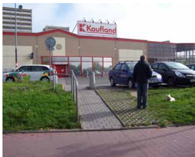
Příchod k centru z hlavní ulice
