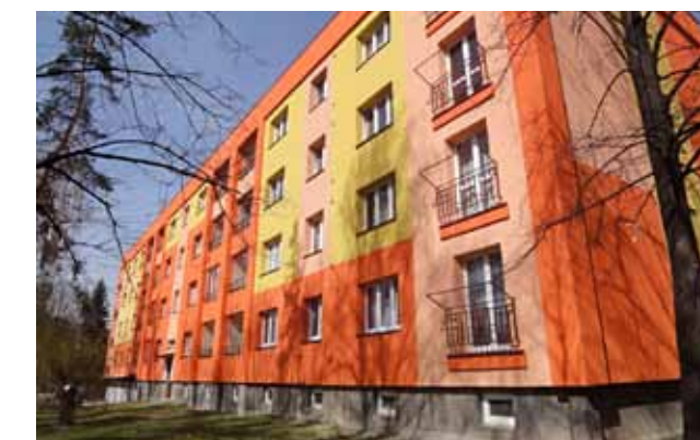
Provedené fasády – pohled z ulice Haškovy
