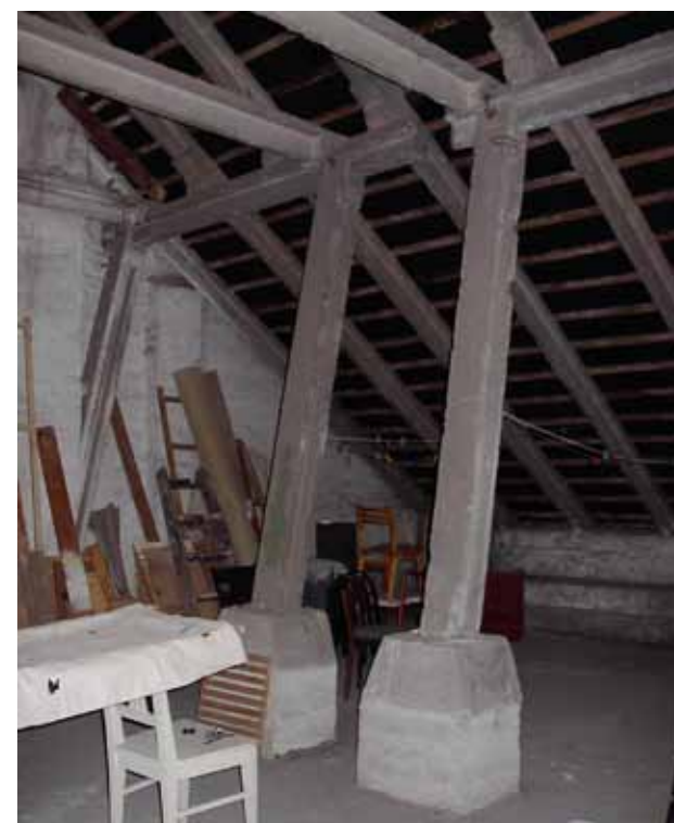
Montovaný železobetonový krov v domě na ulici Bohuslava Martinů, Poruba 2. obvod. Zdroj: Fotografie Eva Špačková
