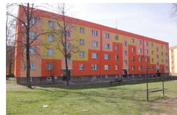
Provedené fasády ze dne 10. 4. 2012, pohled dvorní (SV)
