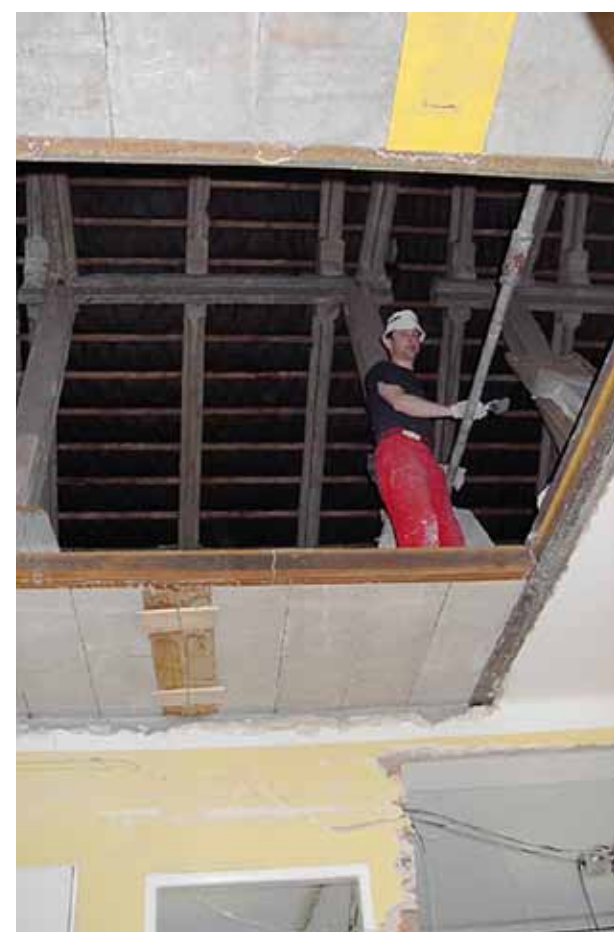
Úprava otvoru ve stropě bytu
