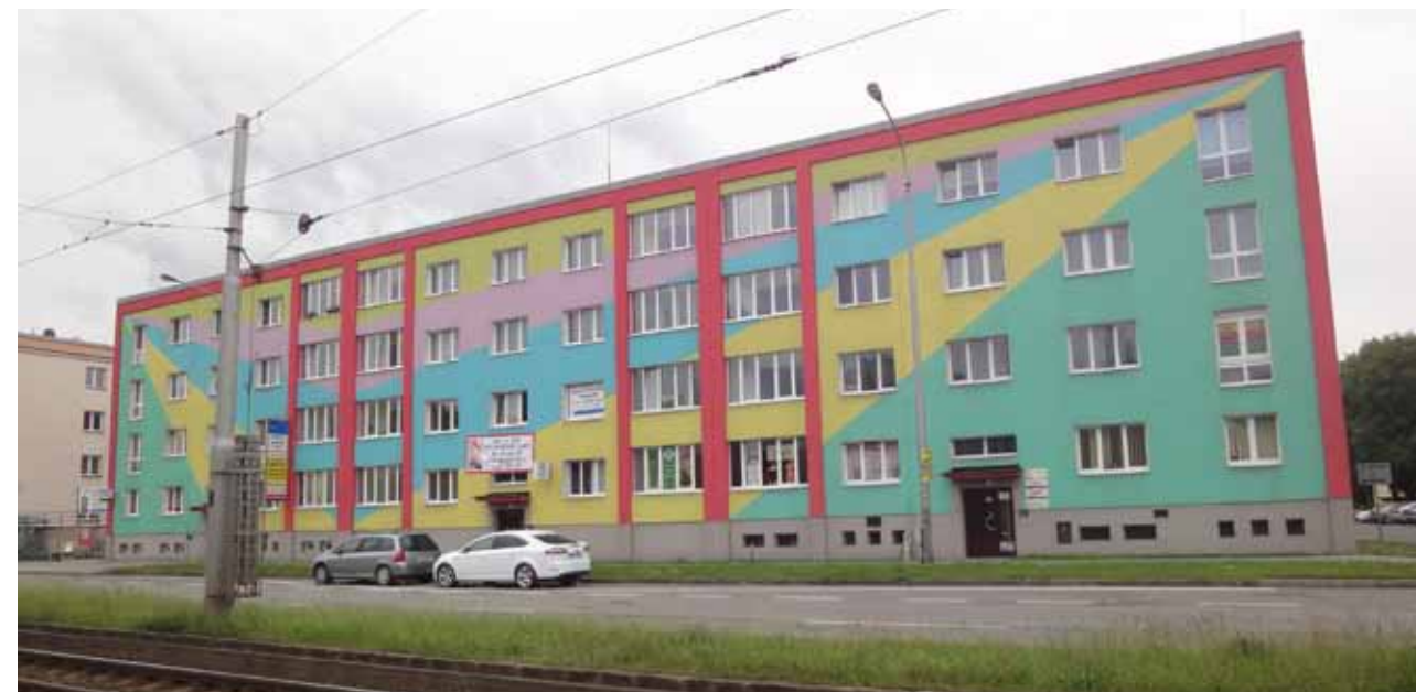
Příklady fasád panelových domů v Ostravě. Zdroj: fotografie Eva Špačková
