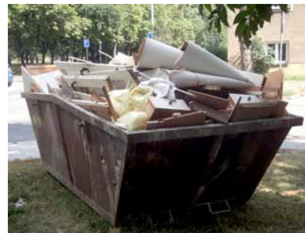
Skládka stavebního odpadu s likvidovanými původními prvky bytu
