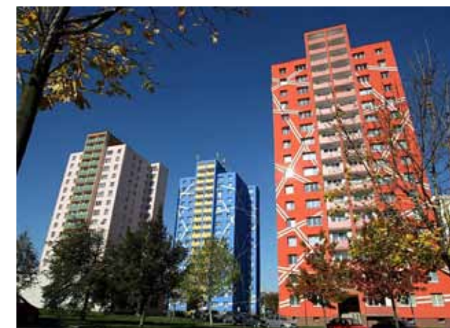
Příklady fasád panelových domů v Ostravě. Zdroj: fotografie Eva Špačková
