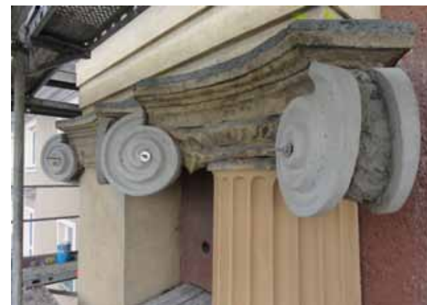
Soudobá náhrada poškozených hlavic dekorativních sloupů novodobými prefabrikáty (Hlavní třída v Porubě, podzim 2015). Zdroj: Fotografie Eva Špačková
