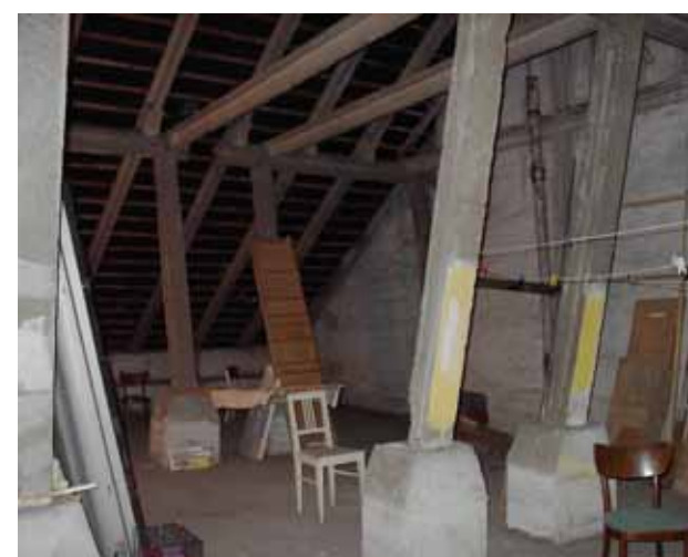
Původního stav montovaného betonového krovy
