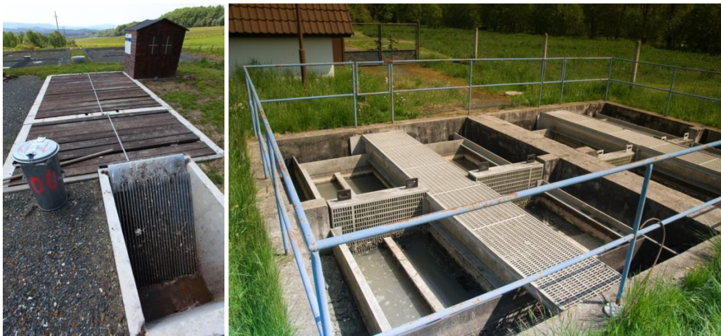
Obr. 3 A) Zakrytá nádrž s česlemi a B) odkrytá nádrž s bezpečnostním filtrem
