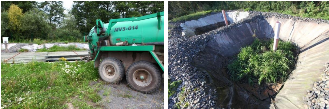
Obr. 71 Aplikace kalů na poloprovozní reed-bed kalové hospodářství (ČOV Kotečnice)
