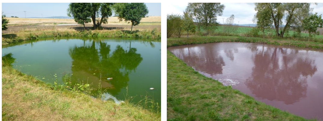
Obr. 5 Eutrofizace stabilizační nádrže za horizontálním filtrem
