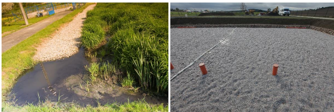
Obr. 38 Srovnání dvou řešení horizontálních filtrů (ČOV Pavlínov, Cekov)
