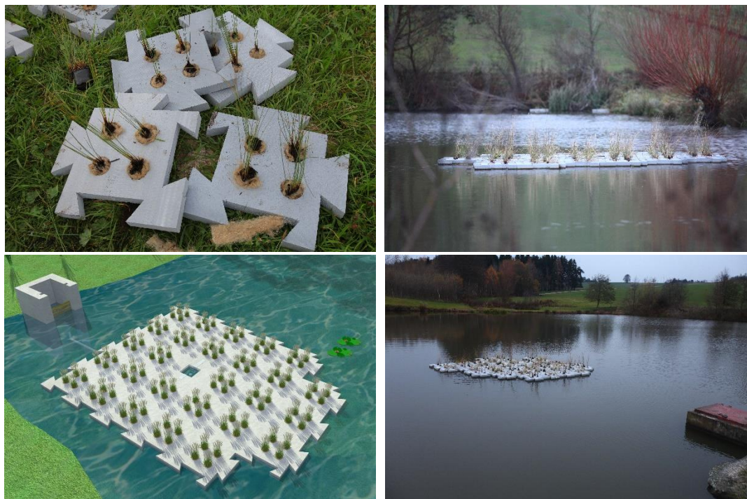
Obr. 24 Plovoucí ostrov - výroba, připojení, schéma a pohled
