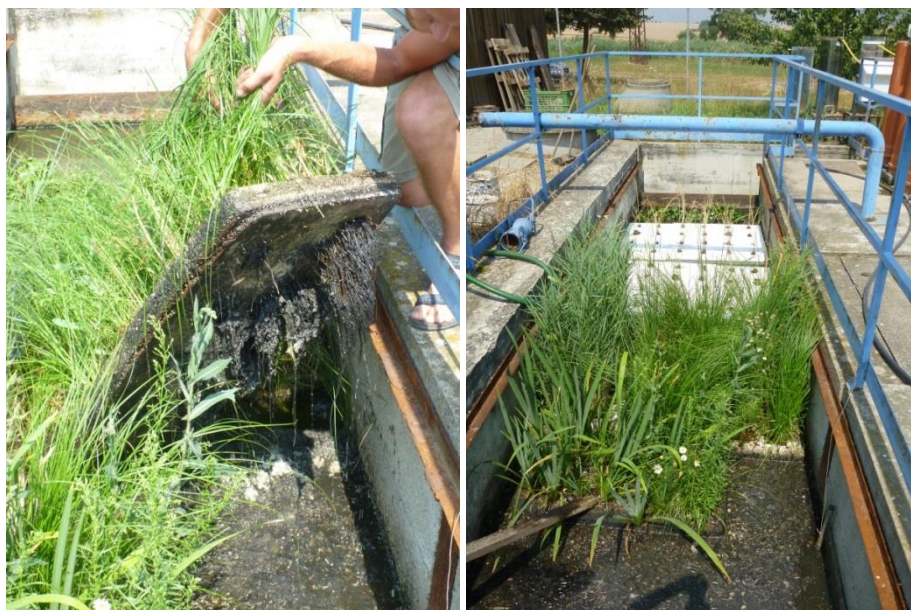
Obr. 31 Neúspěšný směr v rámci intenzifikace štěrbinových usazovacích nádrží
