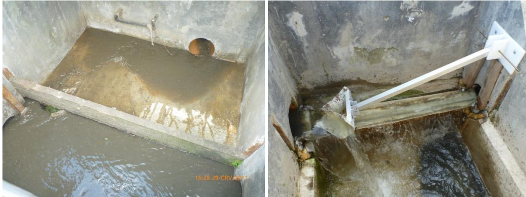
Obr. 29 Pohled na odlehčovací komoru před a po aplikaci užitého vzoru
