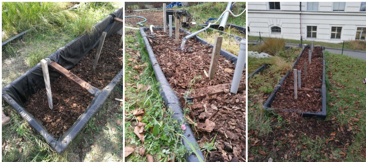
Obr. 28 Poloprovozní zařízení testované na výzkumném pozemku UVHK
