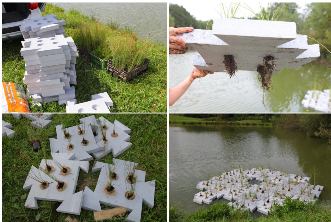
Obr. 59 Realizace poloprovozního objektu se systémem plovoucích ostrovů
