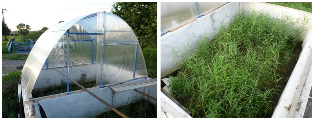
Obr. 68 Kalová pole v Dražovicích – A) se skleníkovým přístřeškem, B) bez přístřešku
