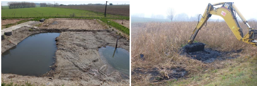
Obr. 62 Odtěžení zakolmatované vrstvy šterku v obci Lutopecny a Dražovice
