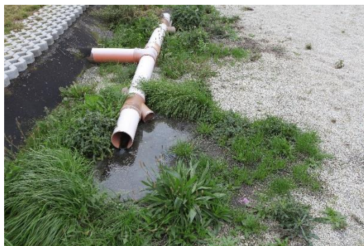
Obr. 39 Horizontální filtr bez vysázené vegetace (ČOV Skašov, 3 roky v provozu)
