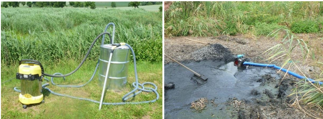
Obr. 66 A) Odsávání kalů podtlakovým zařízením, B) Odčerpání kalů kalovým čerpadlem
