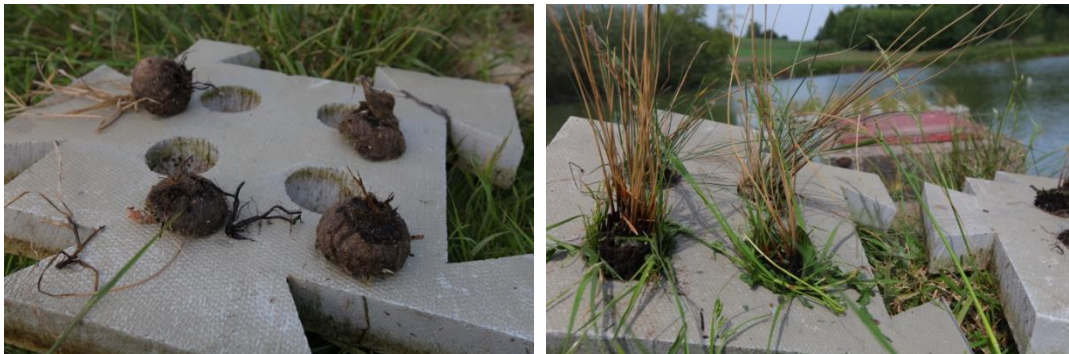
Obr. 61 Pohled na odumřelé sazenice a výsadbu nových rostlin
