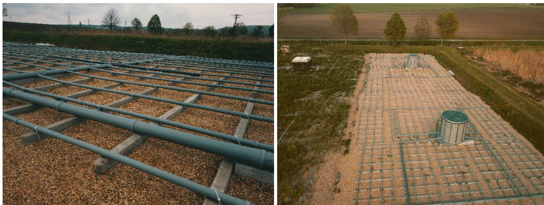
Obr. 52 Řešení distribučního potrubí na poloprovozním objektu
