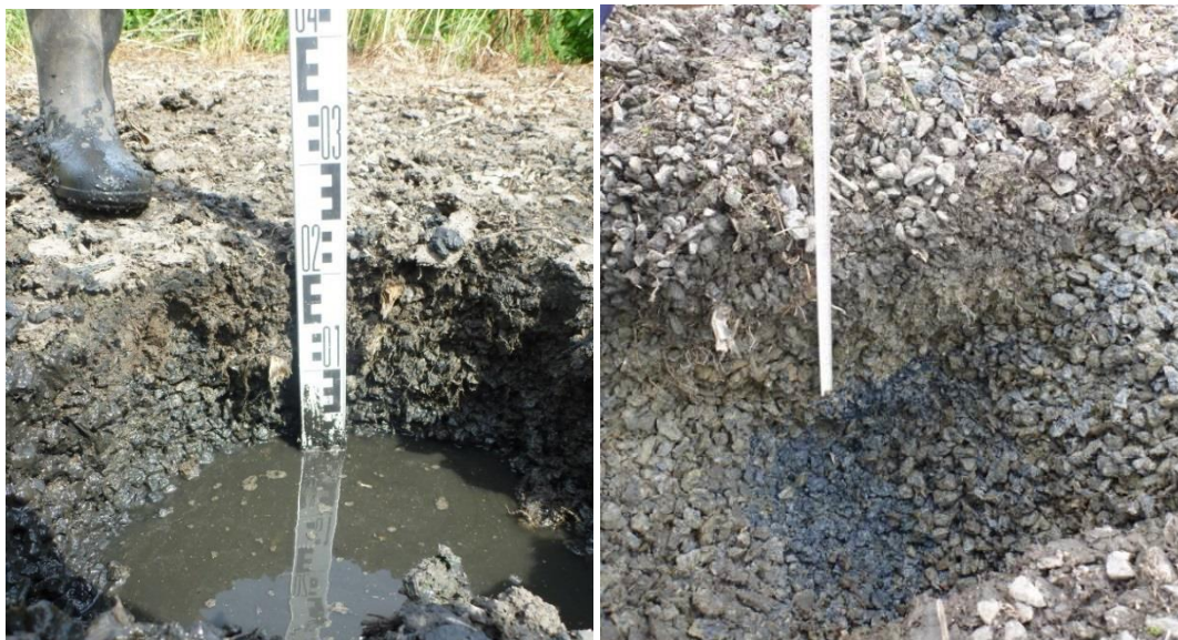
Obr. 67 Kolmatovaný a mineralizovaný substrát v horizontálním filtru
