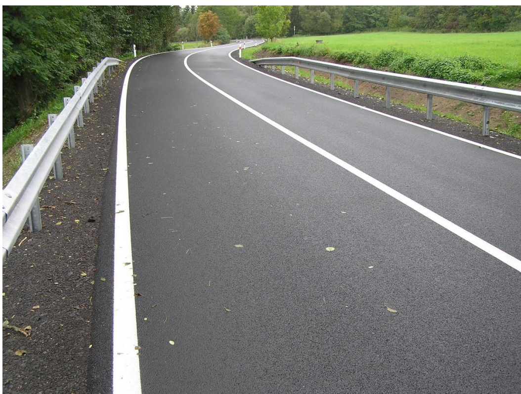
Obrázek 70: Pohled na pokusný úsek Borohrádek [126]
