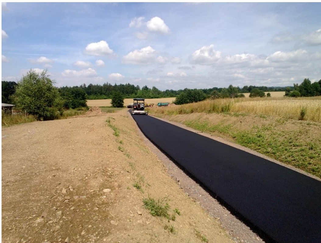
Obrázek 68: Pohled na 1. sekci úseku Lukavice [126]
