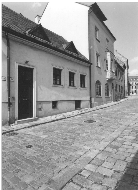
Obr.30 Kapitulska 12, uličná fasáda.
