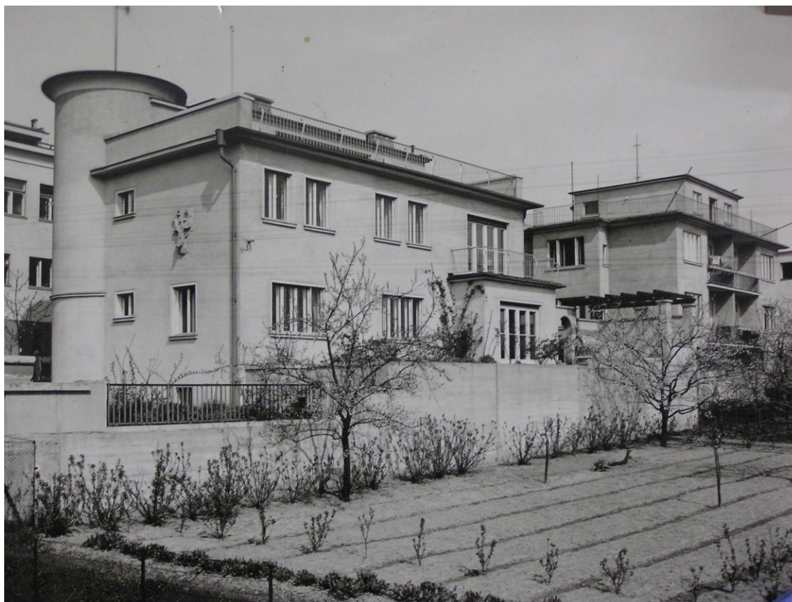
Obr. 80 V popredí vila MUDr. Szamáka, vpravo nájomný dom Hilde Stritzl, vľavo časť rodinného domu Emila Belluša. Zdroj: archív SNG
