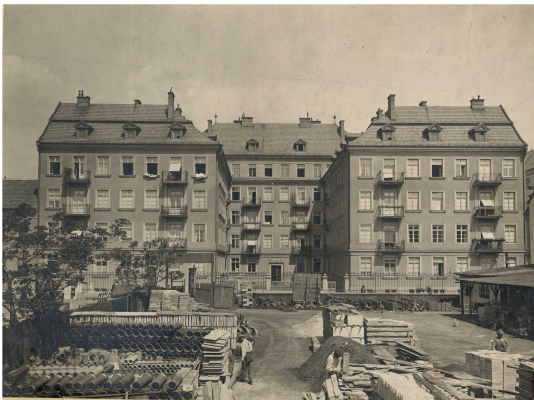
Obr. 16 Mestský bytový dom Grösslingova 59-63. Zdroj: AMB
