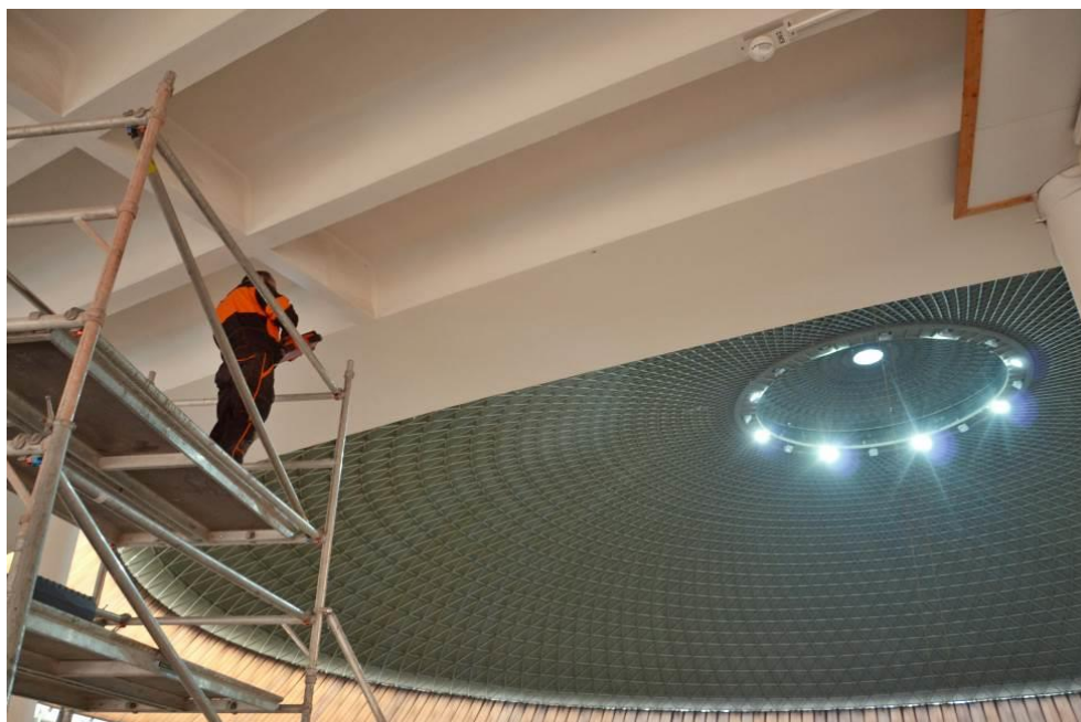
Obr. 81 Pohled na stropní konstrukci galerie II v pavilonu „Z“
