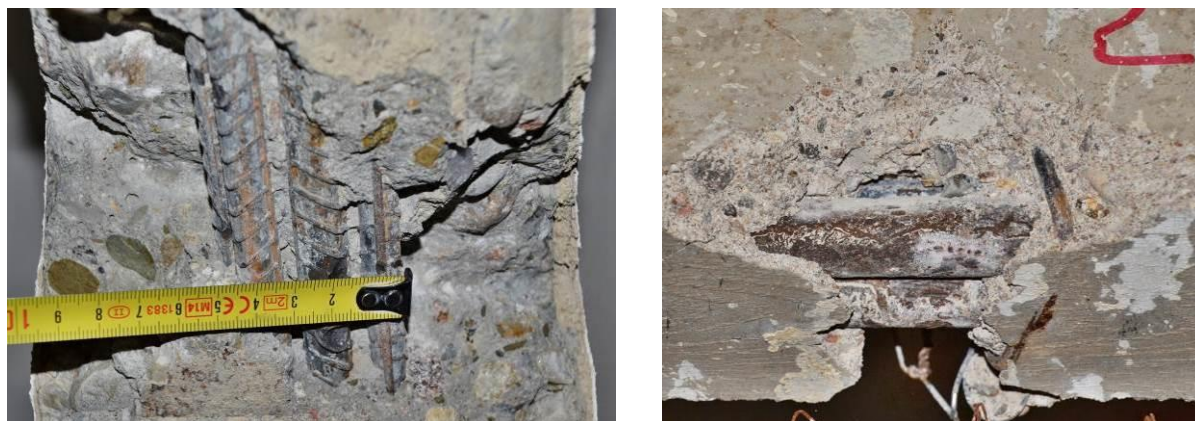
Obr. 108 Typické vyztužení stropních žeber, vlevo shluk 4 vložek \varnothing 10 a \varnothing 12 mm vedle sebe i nad sebou, vpravo 2 vložky \varnothing 22 mm a těsně nad nimi 1 vložka \varnothing 16 mm
