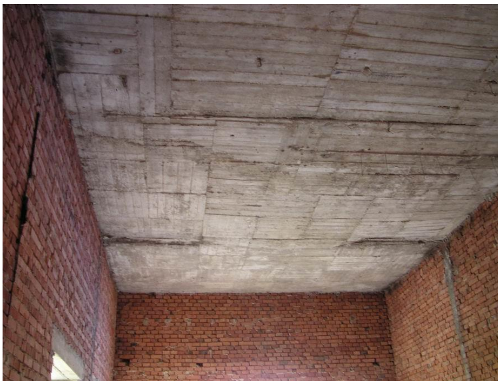
Obr. 26 Pohled na prostě uloženou desku nosné konstrukce
