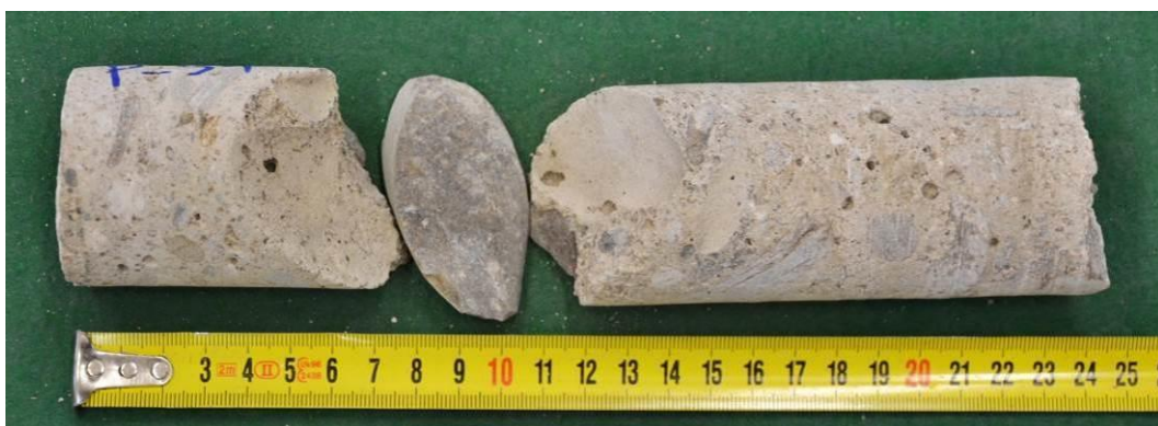
Obr. 32 Jádrový vývrt z betonu vyrobeného v roce 1915 se rozlomil v místě velkého zrna nekvalitního nepraného těžného kameniva; toto nekvalitní kamenivo má značný vliv na snížení pevnosti betonu v tlaku, ovšem na tvrdost betonu takový vliv nemá
