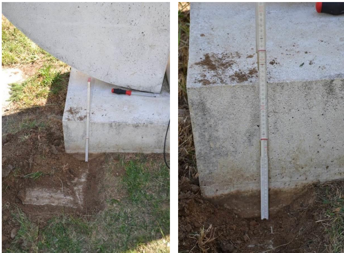
Obr. 112 Pohled na odkopáný roh, pod soklem o výšce 350 mm se objevil základ plastiky
