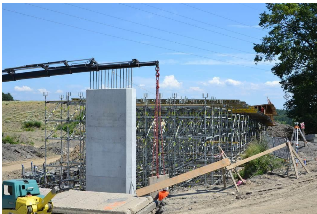
Obr. 61 Pohled na rozestavěný most na silnici I/11
