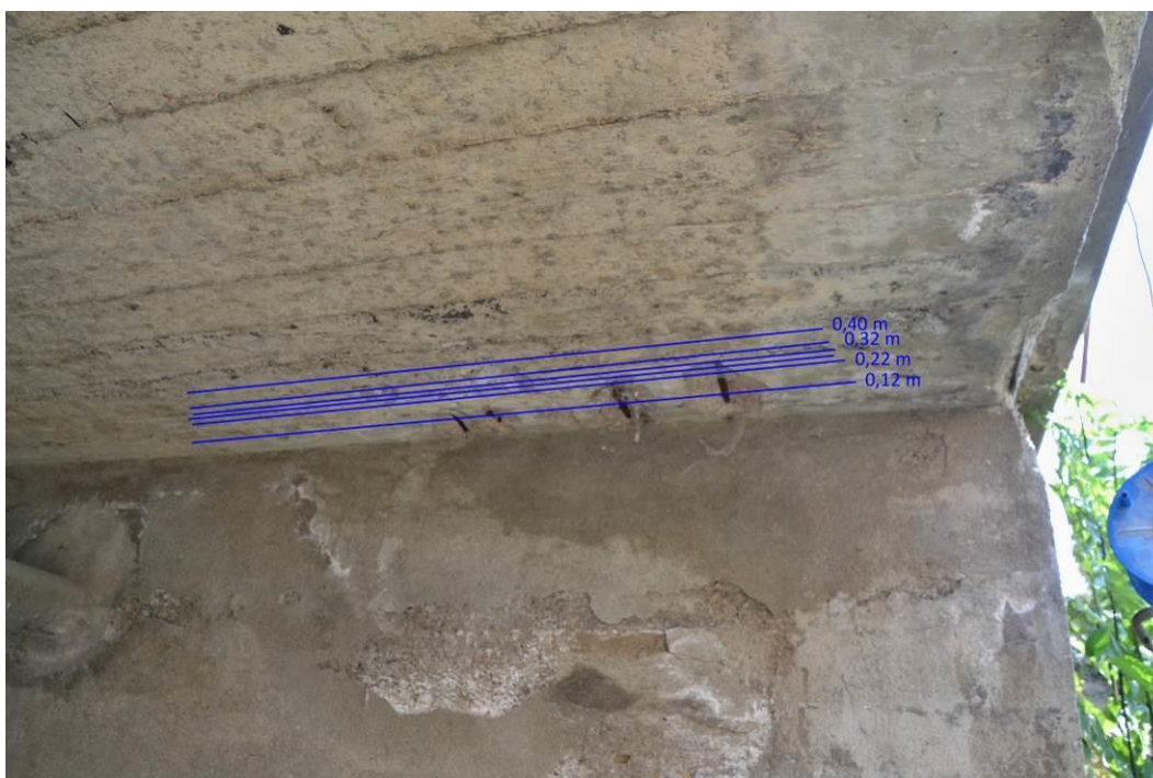
Obr. 88 Pohled na desku nosné konstrukce s vyznačenými liniemi skenování výztuže
