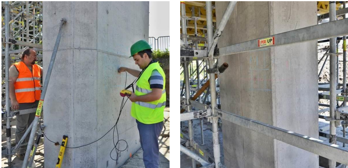
Obr. 62 Měření rychlosti šíření ultrazvukového vlnění přístrojem TICO na pilíři podpěry, vpravo pilíř opěry s vyznačeným rastrem výztuže (UZ měření mimo výztuž)
