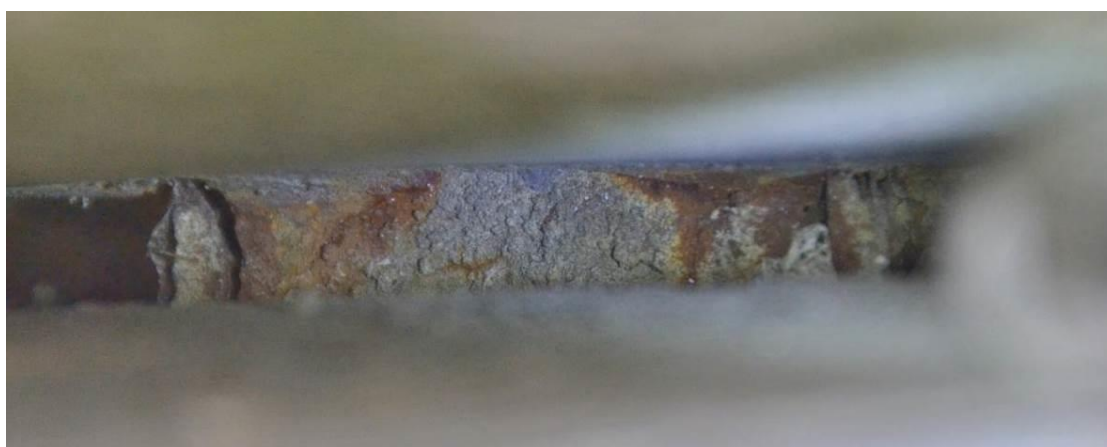
Obr. 126 Pohled do mezery mezi soklem a diskem plastiky (z boku) na jednu ze čtyř pásovin o šířce cca 40 mm spojujících sokl s diskem
