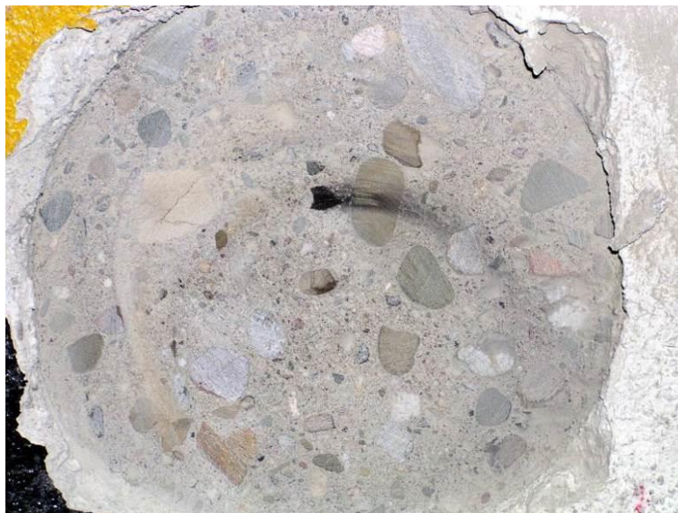
Obr. 73 Struktura betonu na vybroušeném místě; kostra je tvořena nekvalitním těžným kamenivem, ovšem hodnoty ukazatele tvrdosti jsou vysoké
