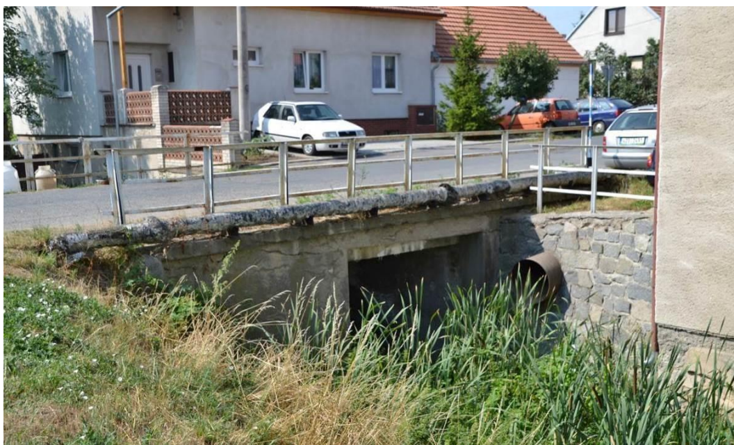
Obr. 86 Pohled ze severovýchodu na most přes místní potok v obci Nosislav
