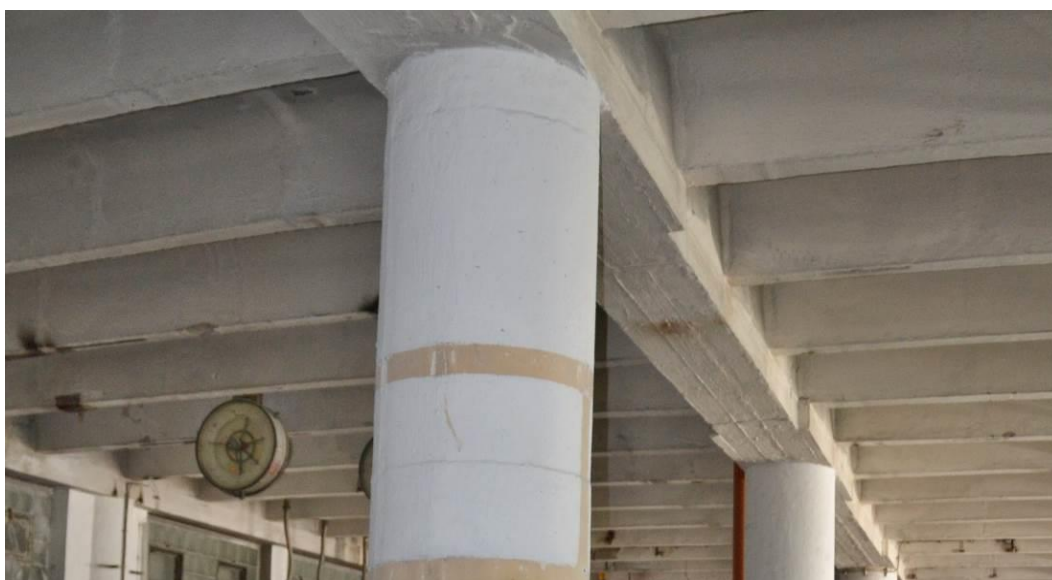
Obr. 109 Průvlak o šířce 500 mm mezi sloupy monolitického skeletu průmyslové haly
