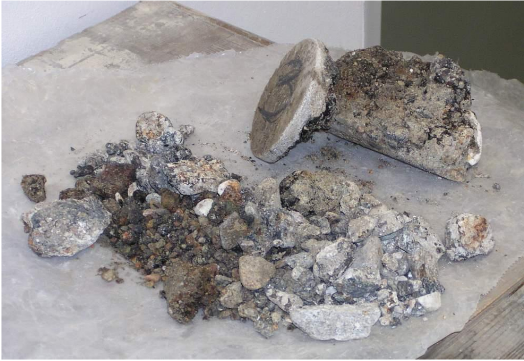
Obr. 30 Kontrolní vývrt betonovou klenbou stoky v místě, kde podle zprávy o průřezu mělo být 0,50 m betonu pevnostní třídy C 16/20
