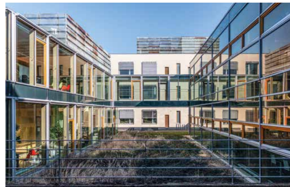
Podařilo se vybudovat místo, které slouží výuce, ale je také otevřené veřejnosti.
