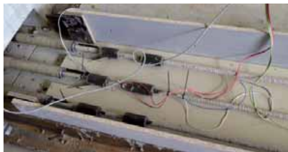
Stropní panel: příprava předpínání výztuže a měřicí zařízení
