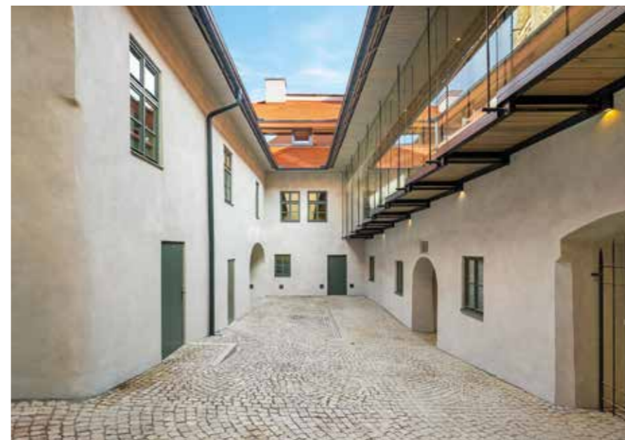
Rekonstrukce Kanovnické rezidence na Petrově
