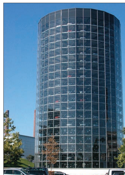
Wolfsburg, SRN – 20podlažní tubus skladu vyrobených vozů Volkswagen, sloužící současně jako reklamní a propagační objekt (automatický parkovací systém Round Palis).
