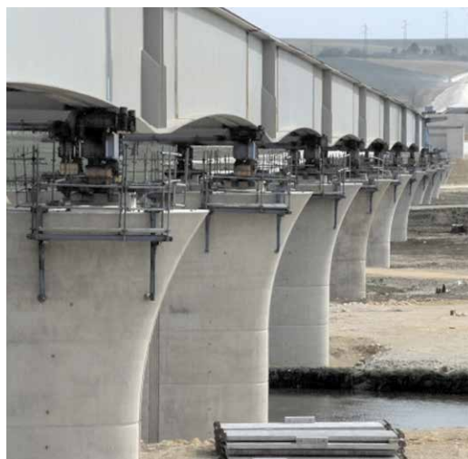
obr. 2.13 Viaduc de la Meuse, Lacroix-sur-Meuse, Francie, 2003–2005
