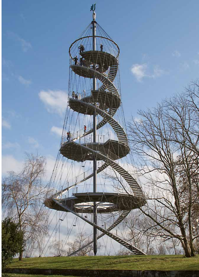
obr. 2.17 Rozhledna Killesberg, Stuttgart, 2001; subtilní středový tlačný sloup
