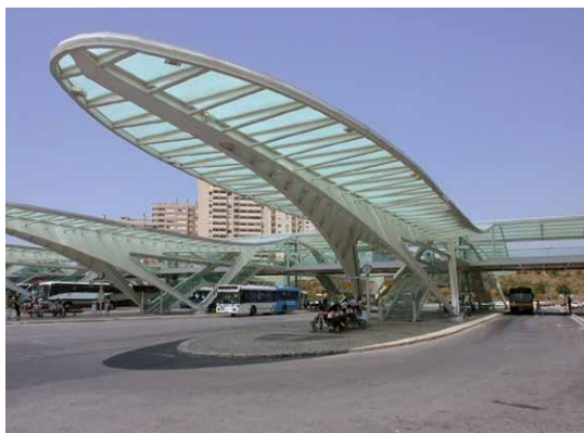
obr. 2.10 Železniční stanice Oriente, Lisabon, 1998; mohutné vyložení konzol
