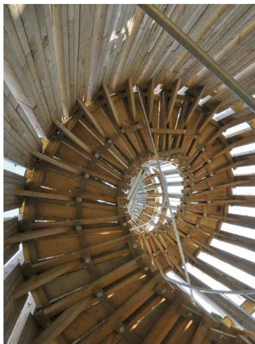
obr. 2.11 Akátová věž Výhon, Židlochovice, 2009; používá konzoly pro vynesení točitého schodiště
