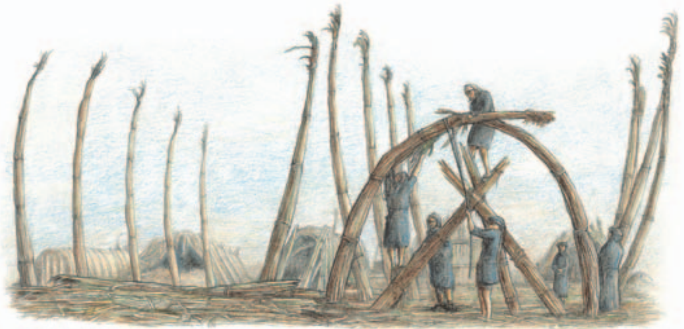
Stavba rákosové budovy u Basry v Iráku.
