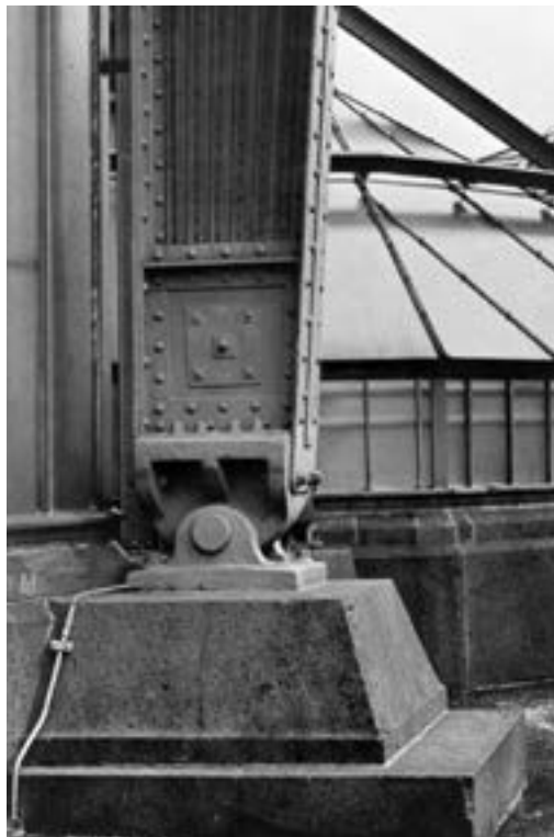
Pata ocelového sloupu, Palmový skleníků, Botanická zahrada, Dahlem, Berlín.
