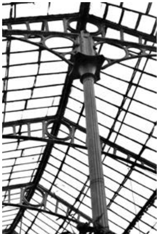
Střešní konstrukce ze skla a železa, Londýn.
