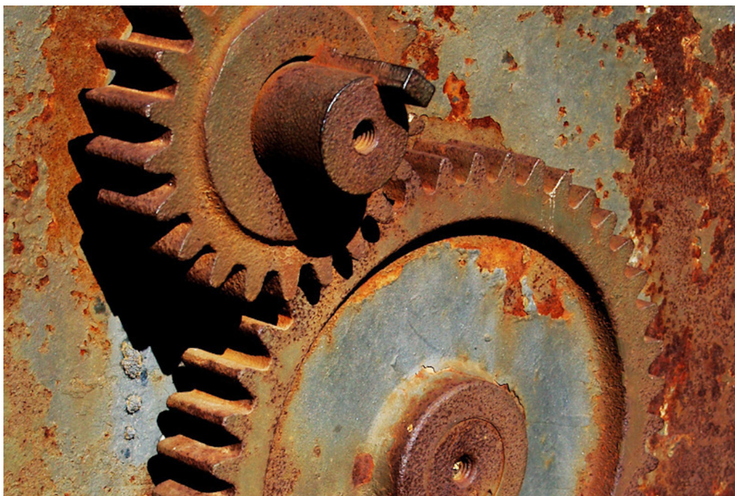
Obrázek 5.1 Znehodnocení kovového zařízení v agresivním prostředí. https://www.chiefaircraft.com/aircraft/chemicals/corrosion-control.html
