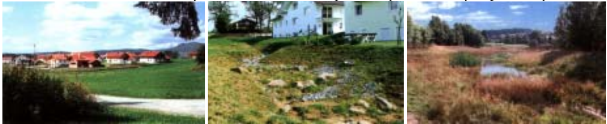
Odtokový kanál a velká mulda pro zachycování silných přívalových dešťů.
