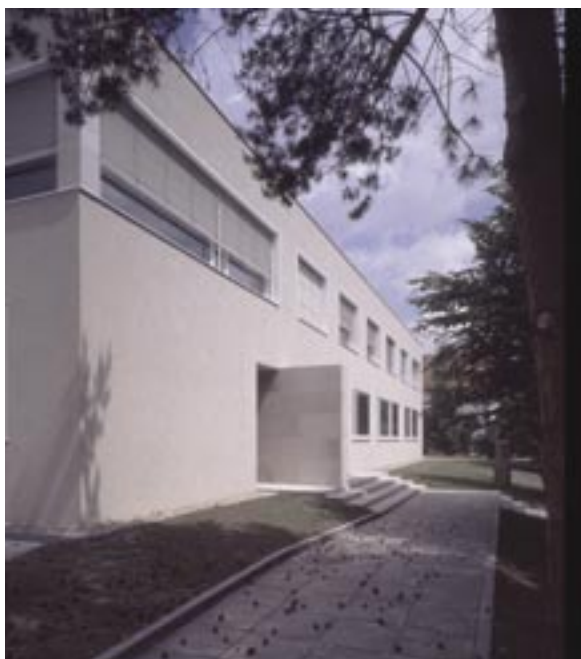
Hlavní vstup do radnice; Foto F. Šlapal
