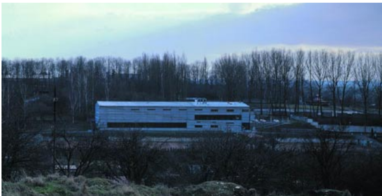
Pohled na halu přes údolí Libánky; Foto F. Šlapal
