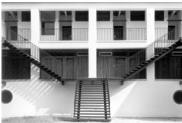
Objekt šaten; Foto I. Lutterer
