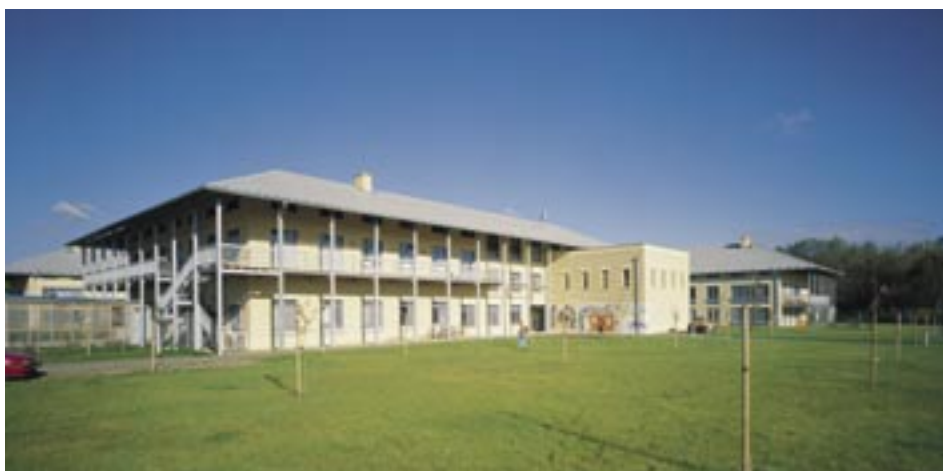
Vstupní pavilon s kaplí, v popředí nově založený sad; Foto F. Šlapal
