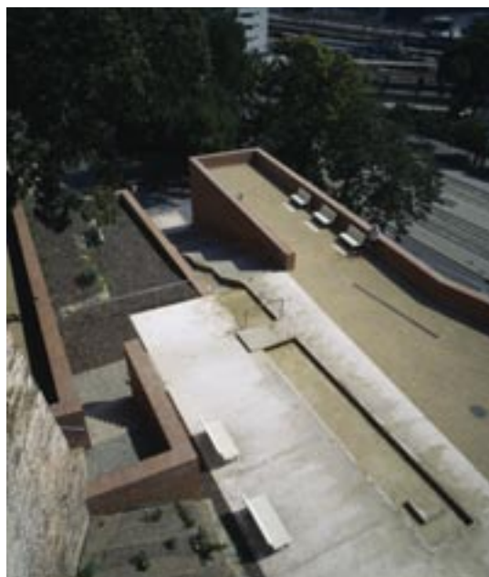
Vstup do ulice Bašty; Foto F. Šlapal
