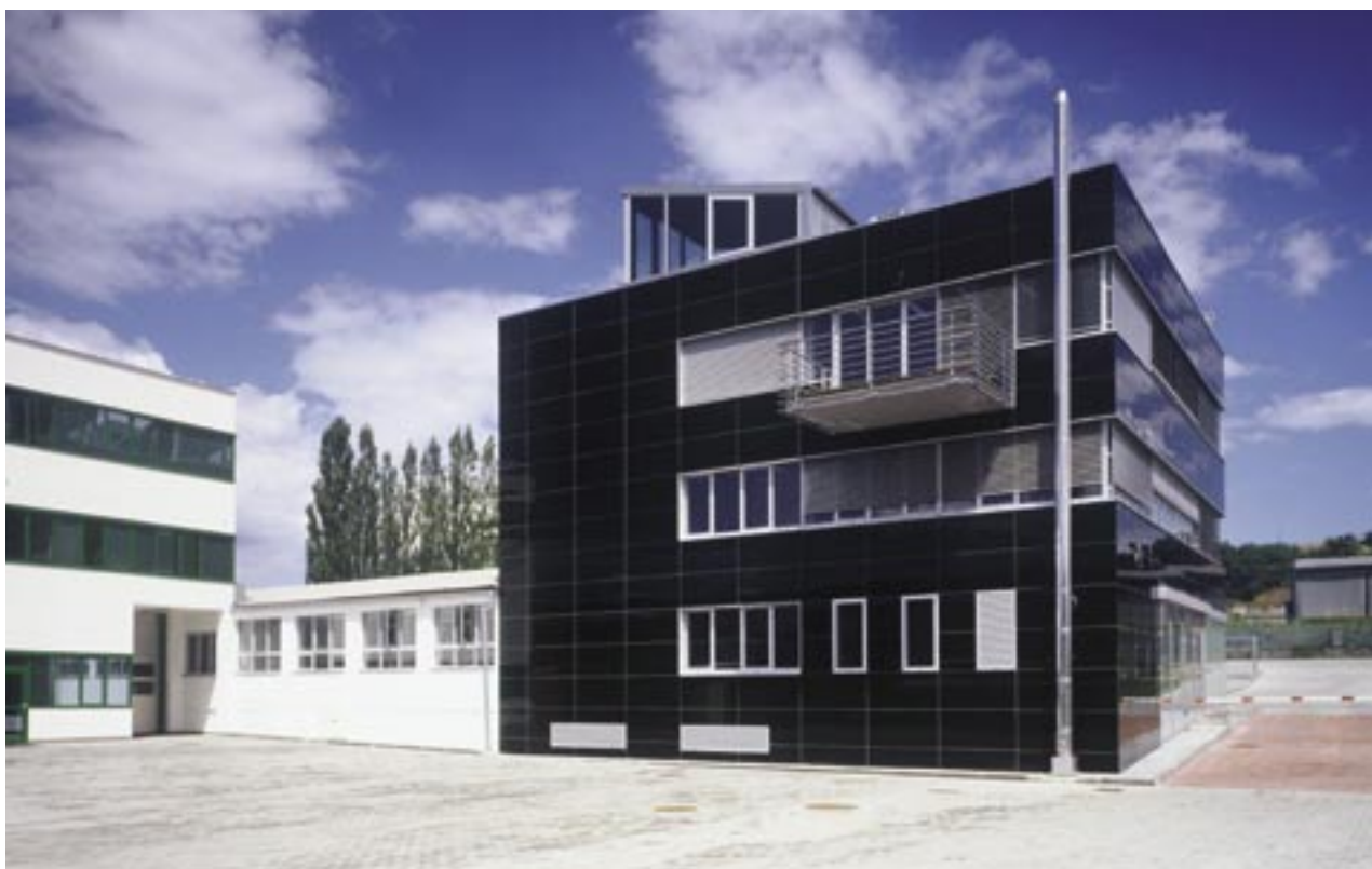
Administrativní budova ze dvora; Foto F. Šlapal
