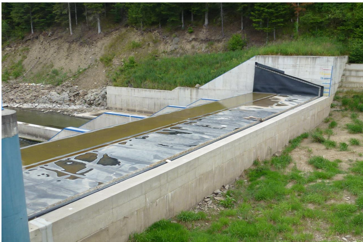
Obr. 1.1 Přeliv se širokou korunou s vakem, Ružbašská Miřava (foto Pařílková, 2014)
