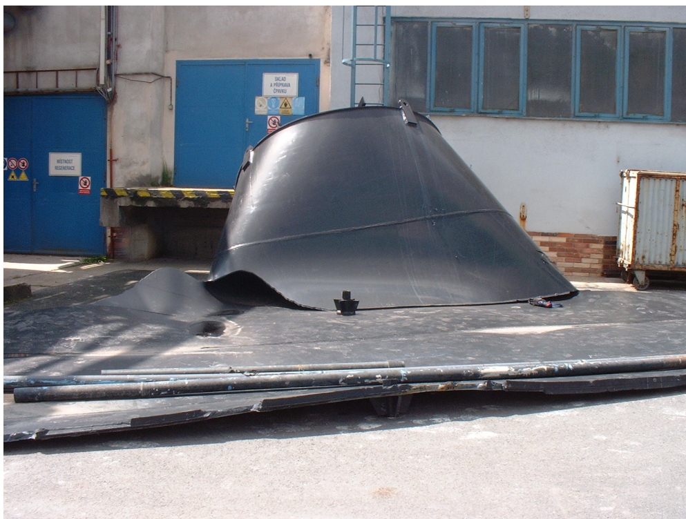
Obr. 1.1 Částečně rozvinutý plášť zničené nádrže [43]
