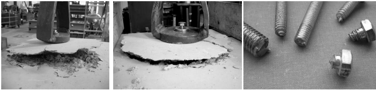
Obr. 4.05 Vytržené kužely betonu (vlevo) a přetržené šrouby
