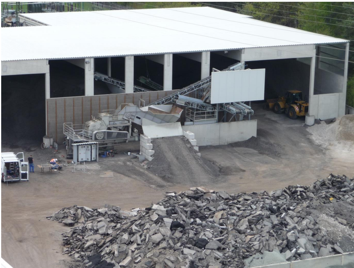
Obrázek 2: Zastřešení skládky R-materiálu a drtící zařízení
