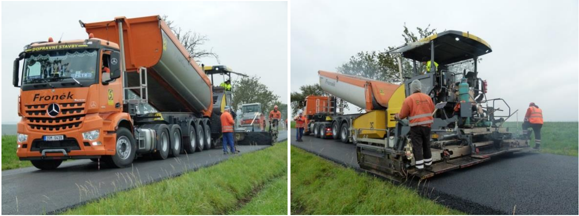
Obrázek 6 a 7: Pokládka směsi SMA 11S s 50 % podílem R – materiálu [54], vlevo: doprava směsi, vpravo: finišer
