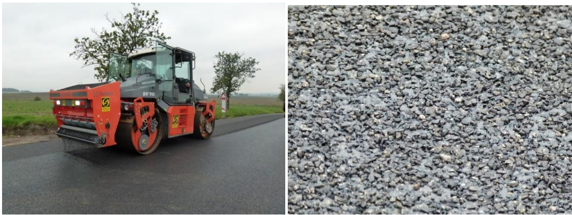
Obrázek 8 a 9: Vlevo: Poslední fáze hutnění s podrt'ováním povrchu vrstvy, vpravo: detail hotové zhutněné vrstvy [54]
