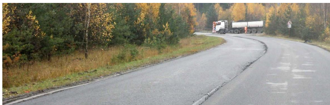
Obrázek 5: Provádění pokusného úseku
