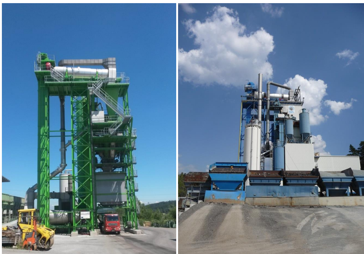
Obrázek 3: Obalovny asfaltových směsí vybavené paralelním sušícím bubnem – vlevo Česká republika - Bruntál, vpravo Spolková republika Německo - Norimberk
