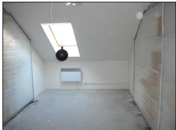
Obr. 8 Instalace akumuláčních stěn (autor)
