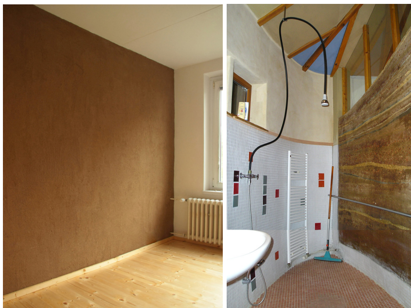
Obr. 8 Hrubá hliněná omítka v pracovně bytu v panelovém domě (T. Moštěk)
