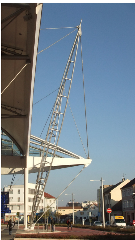
obr. 12 účinné tvary sloupů, Dopravní terminál, Hradec Králové, 2008, proměnný tvar sloupu po délce ve tvaru trojúhelníkového příčného průřezu
