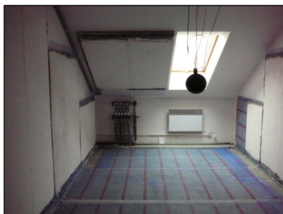
Obr.4.11 Rohože po omítnutí (autor)
