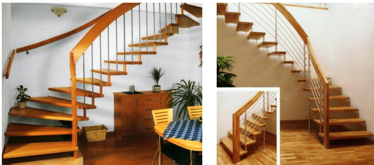
Obr. 1: Dřevěné segmentové schodiště s jednostranně zavěšenými stupni bez schodnice na straně nosné zdi. Fotografie převzaty z [22].
