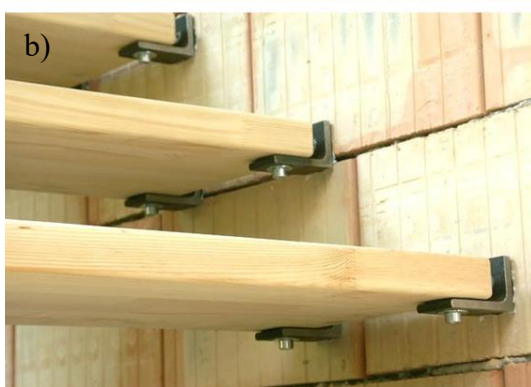
Obr. 28: Variantní připevnění stupňů.
