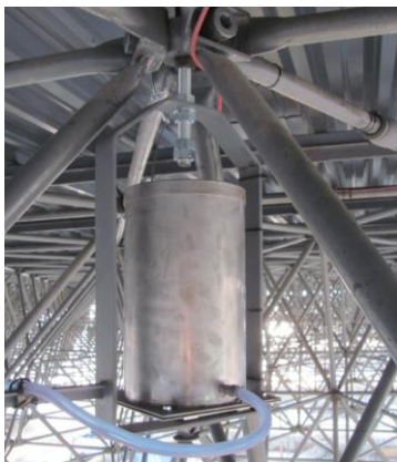
Obr. 22 Měřící bod - jedna z nádob prvního okruhu umístěná na horní styčník příhradové konstrukce.
