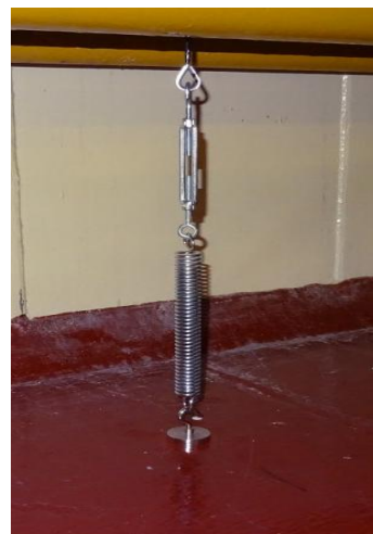
Obr. 39 Reálné přikotvení v plynojemů.
