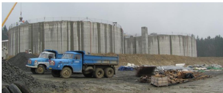
Obr. 7 Pohled na rozestavěné nádrže.
