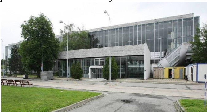
Obr. 17 Objekt pavilonu "D" v areálu BVV - původní stav.
