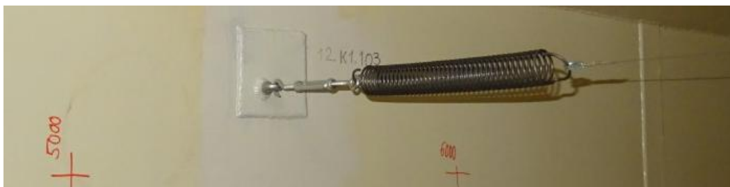
Obr. 37 Pružina T2540 napínající podélné lanko v horním plynojemu zakotvená do pevného bodu.
