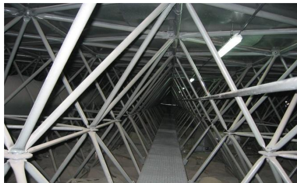
Obr. 18 Pohled v rovině původní konstrukce zastřešení.
