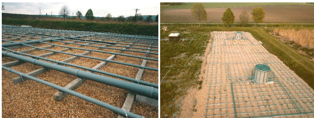
Obr. 6 Řešení distribučního potrubí na poloprovozním objektu
