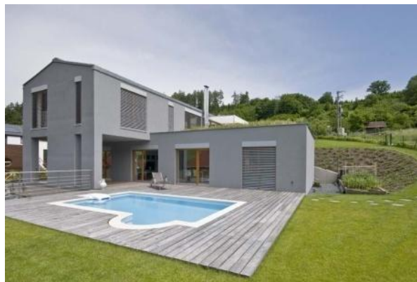
obr. 10 - foto úroveň přízemního bytu
