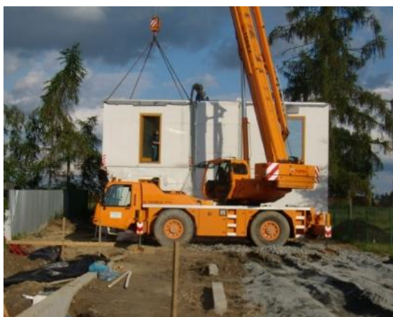
obr. 5 - foto z výstavby
