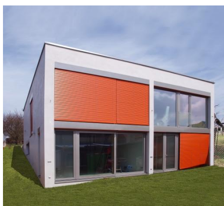
obr. 15 - foto jižní fasáda
