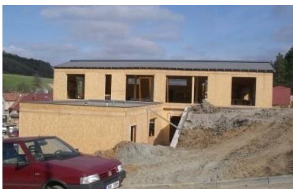
obr. 12 - foto z výstavby
